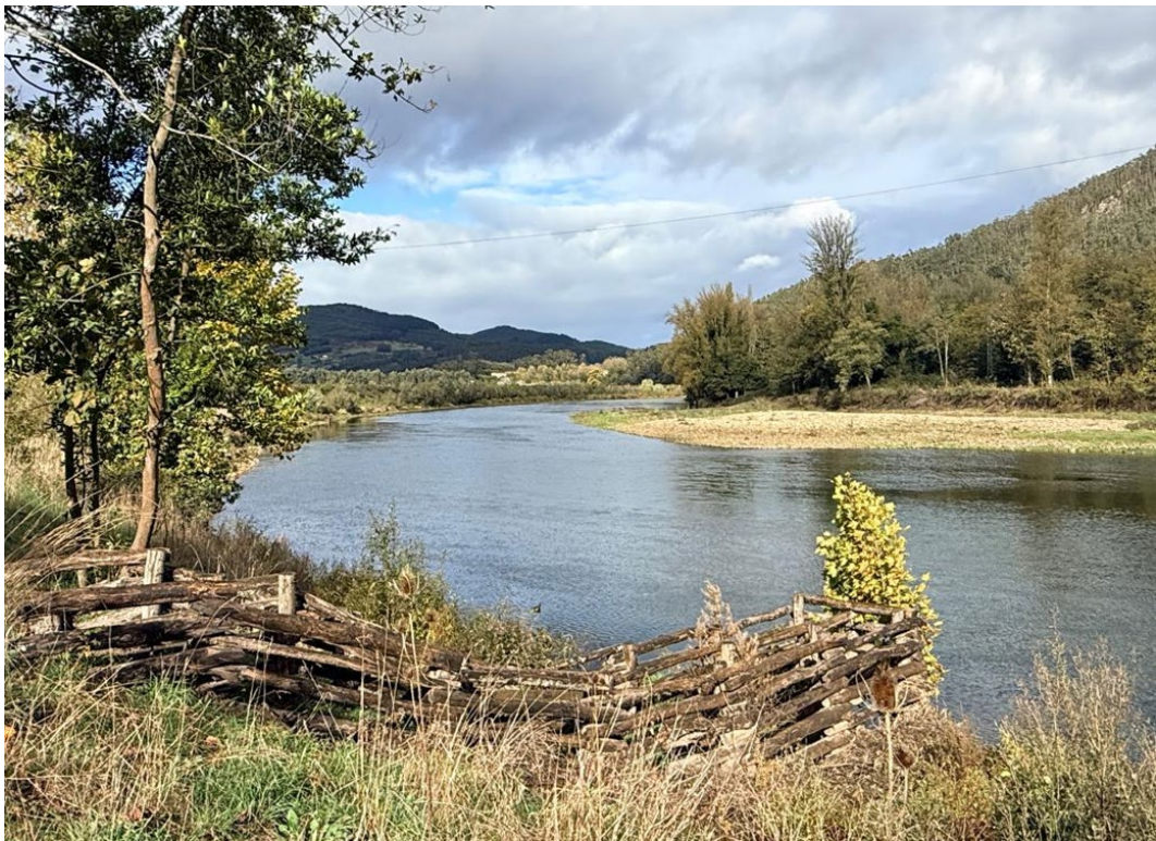
Figura 16. Arriba imagen durante las obras en 2021 (arriba) y abajo imagen actual, con aspecto de un deflector orgánico en primer término.
