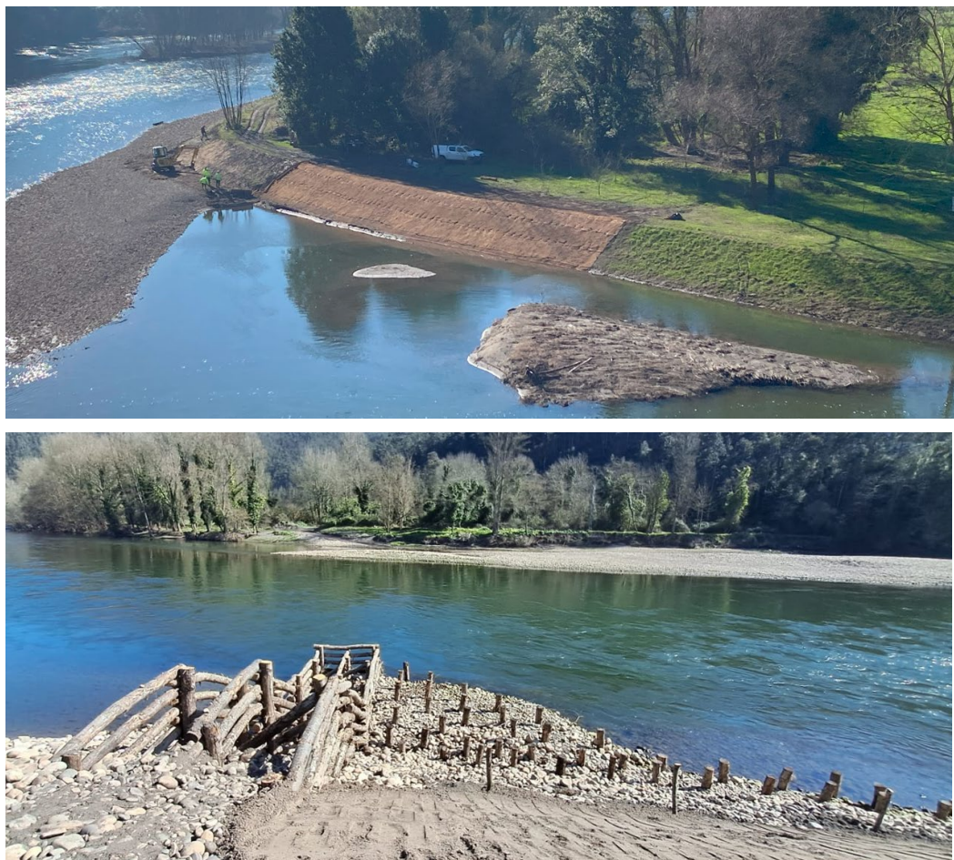
Figura 15. Imágenes durante las obras de bioingeniería en 2022.
