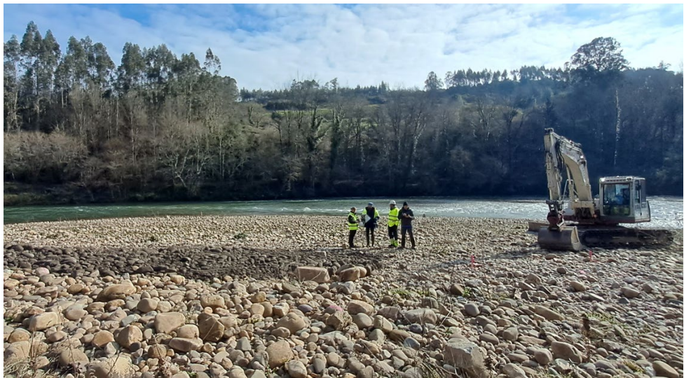
Figura 9. Trabajos de reubicación de sedimento sobre el meandro de Villamarín.
