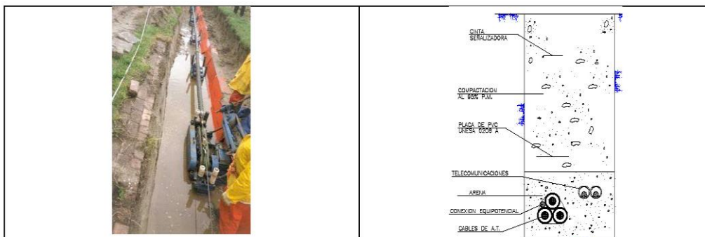
Cables en canalización entubada
