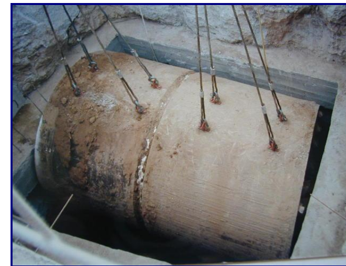
Imagen 38. Maniobra de retirada de una cabeza de corte
