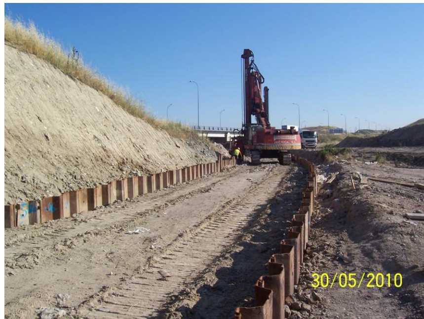
Imagen 5. Líneas de tablestacas para contención de tierra en excavación
