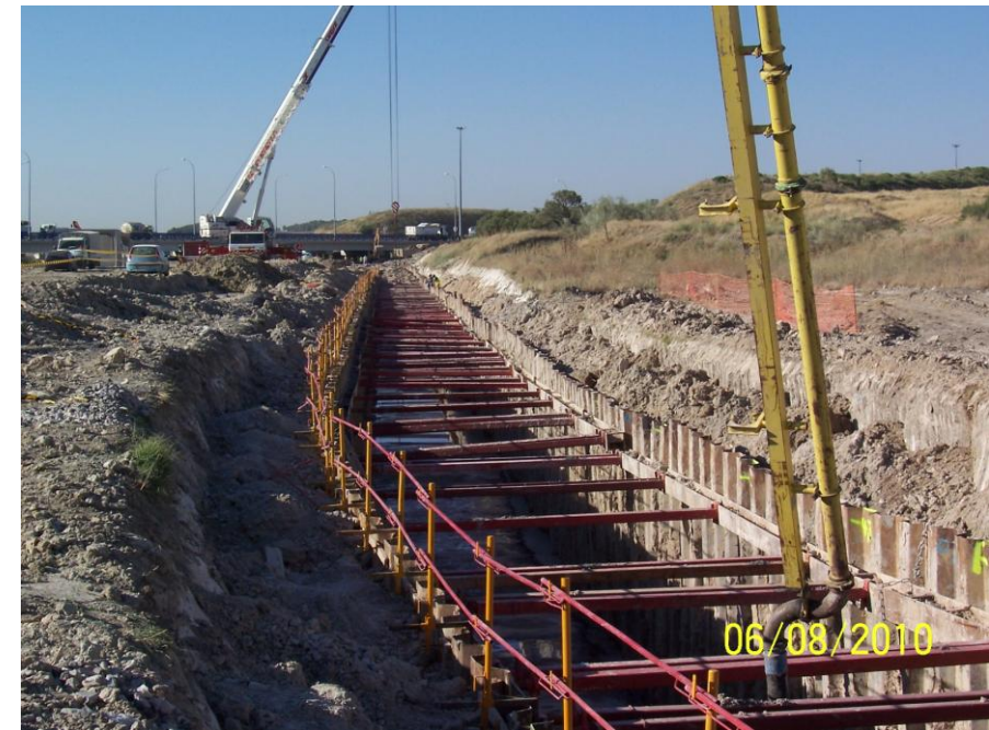
Imagen 6. Líneas de tablestacas para contención de tierra en excavación
