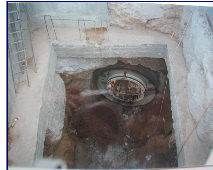
Imagen 37. Pozo de salida justo cuando comienza a salir la cabeza cortadora
