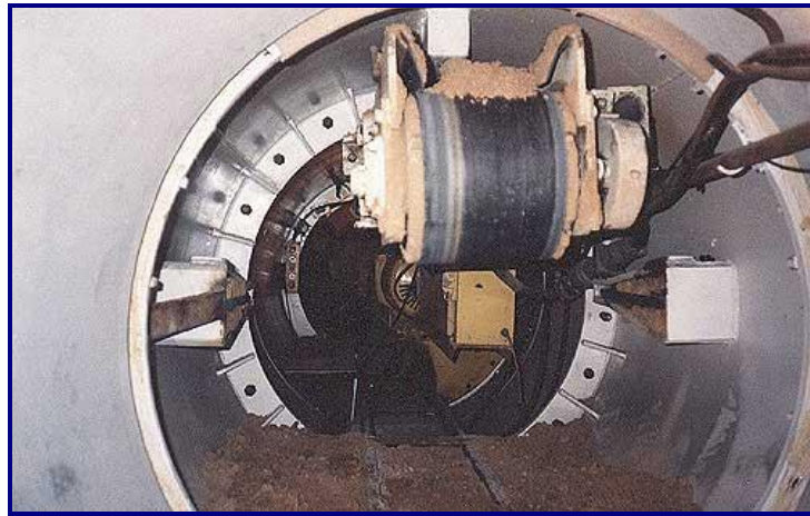
Imagen 13. Cinta transportadora que lleva el detritus hasta la vagoneta
