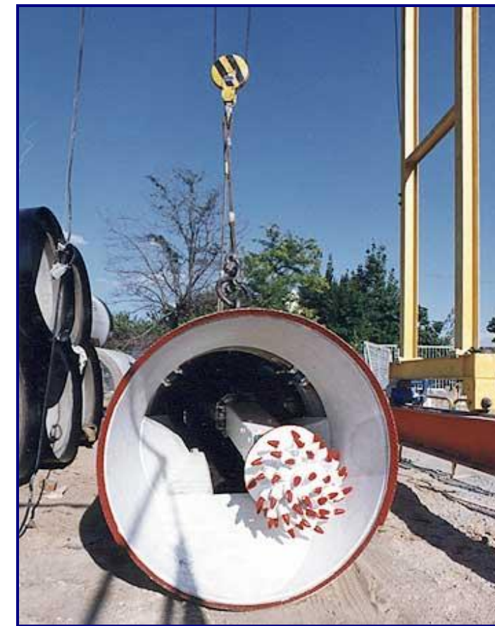
Imagen 12. Detalle del brazo o escudo abierto con rozadora
