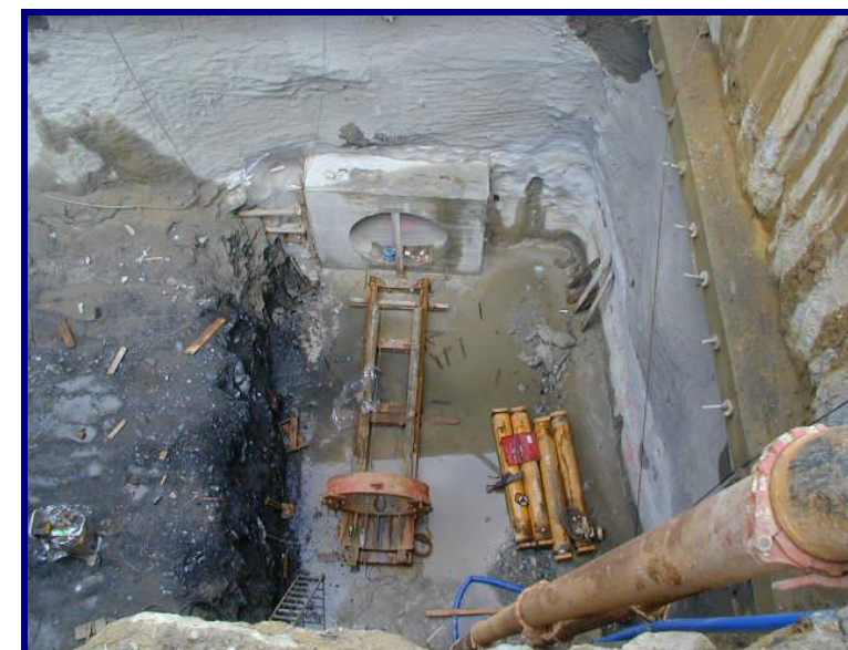
Imagen 21. Pozo de ataque para ejecución de micro túnel
