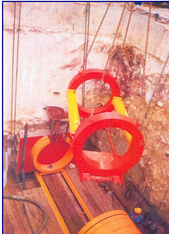
Imagen 19. Muro de reacción al fondo del pozo
