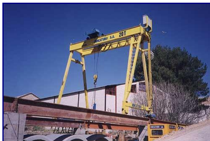
Imagen 15. Pórtico grúa para retirar las vagonetas llegadas al pozo de ataque
