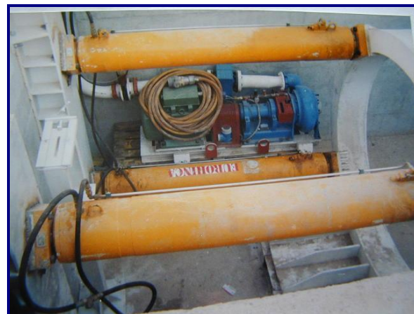
Imagen 23. Bastidor de empuje
