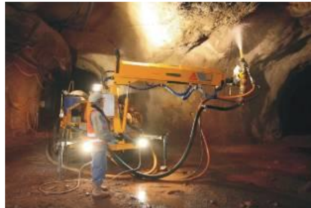
Imagen 40. Dispositivo móvil de pulverización de hormigón, o robot de gunitado
