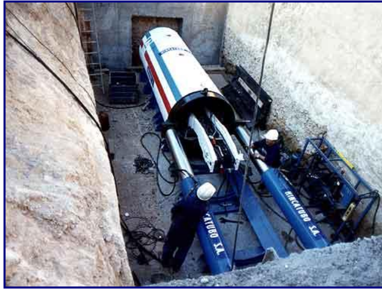
Imagen 7. Pozo de ataque correspondiente al sistema de hinca con escudo abierto
