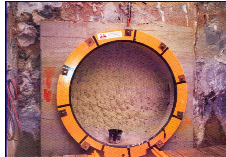
Imagen 20. Junta principal de estanqueidad del pozo de ataque
