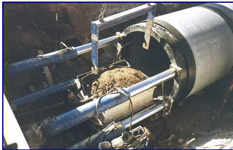
Imagen 14. Vagoneta llena en el pozo de ataque para ser evacuada
