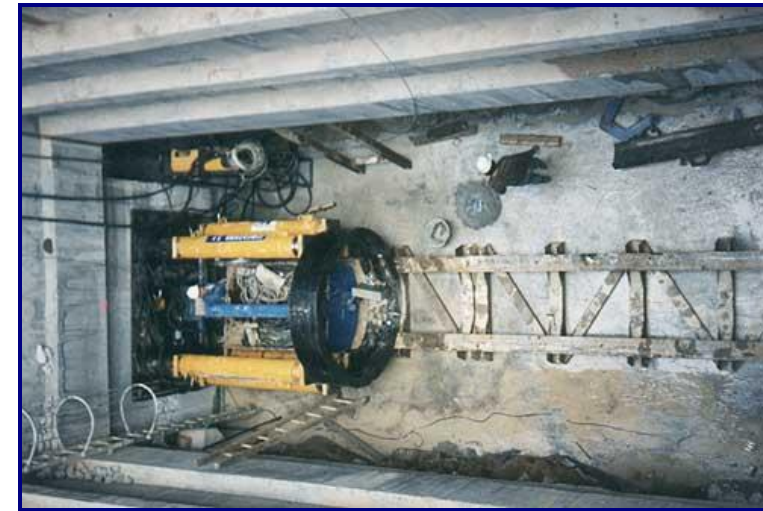
Imagen 9. Presentación de la tuneladora sobre el bastidor
