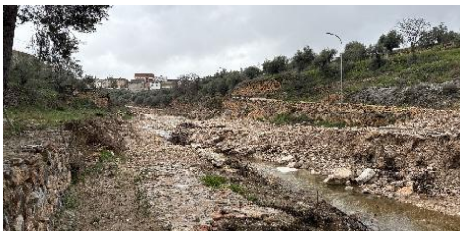
Figura 12. Tramo del arroyo de Letur aguas arriba del encauzamiento, con el Camino de San Antón en la margen izquierda
