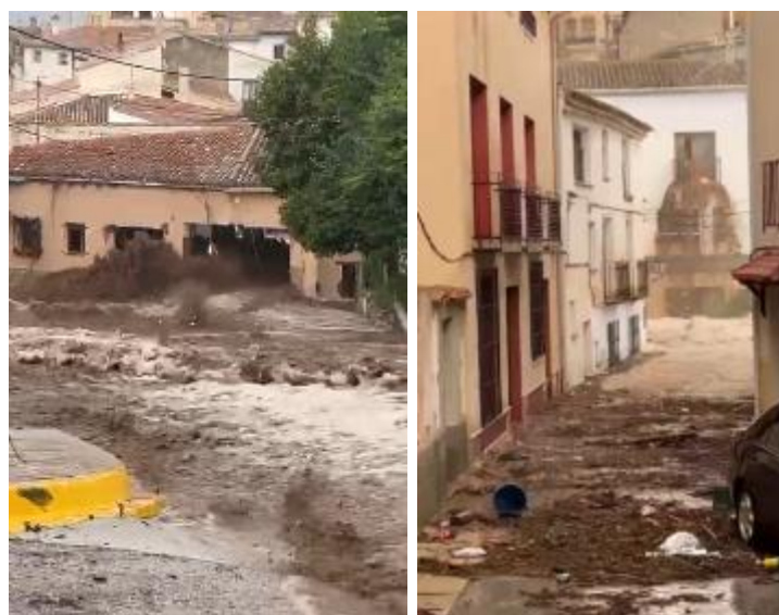
Figura 37. Entrada de agua a las viviendas de Cuesta de Las Moreras (imagen de la izq.) y salida de agua de las viviendas en la parte de atrás de la Cuesta de Las Moreras (imagen de la dcha.)
