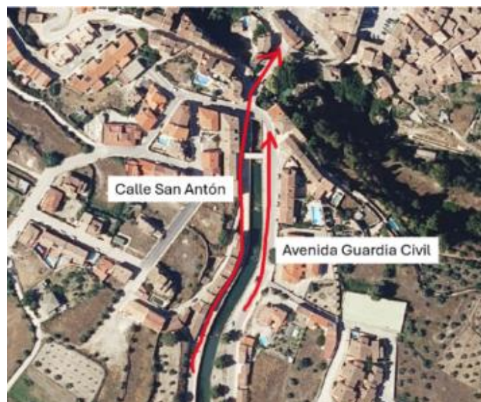
Figura 18. Tramo encauzado del arroyo de Letur. A la derecha, imagen de la calle San Antón durante avenida del medio día (vista desde aguas abajo)
