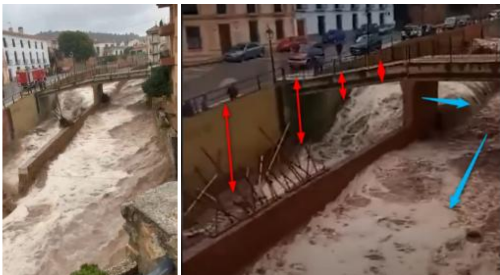
Figura 19. Situación en la pasarela de acceso al centro médico de Letur
