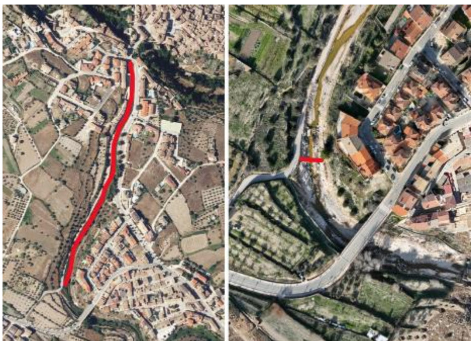
Figura 83. Ámbito del encauzamiento, trazado a la izquierda e inicio del encauzamiento a la derecha
