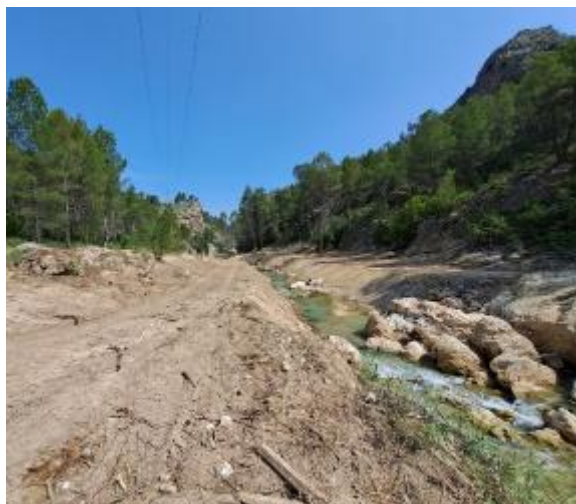
Figura 65. Acondicionamiento del arroyo de Letur
