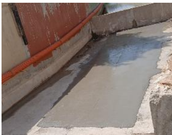
Figura 64. Detalle de la reparación de la losa del encauzamiento aguas abajo del segundo salto
