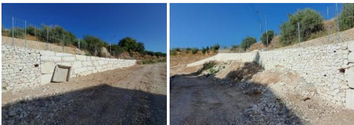
Figura 68. Reconstrucción del muro del cauce junto al camino de la Dehesa
