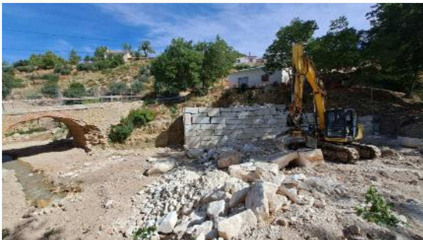
Figura 67. Reconstrucción de las aletas del puente arco
