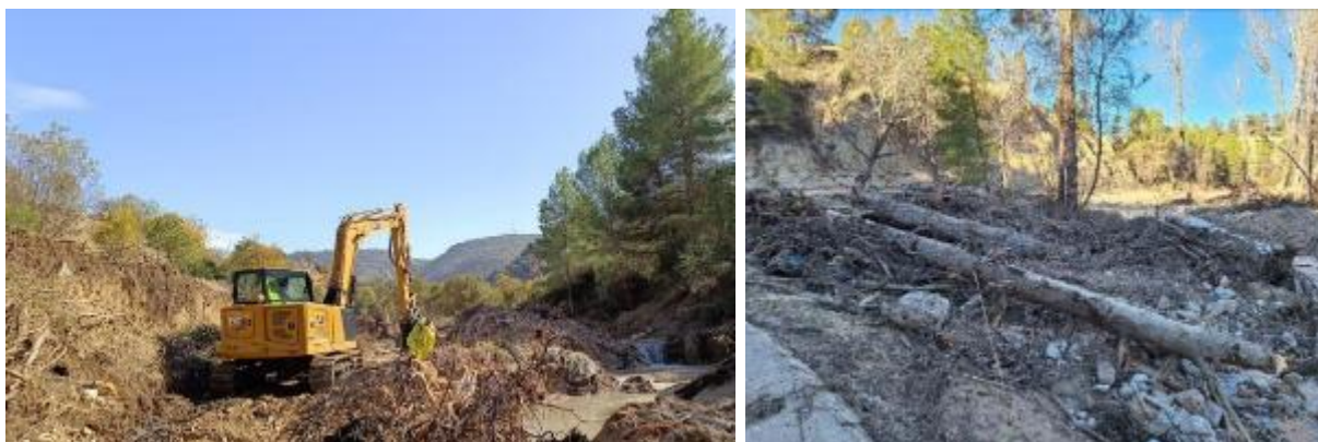
Figura 53. Retirada de arrastres del arroyo de Letur hasta confluencia con el río Segura
