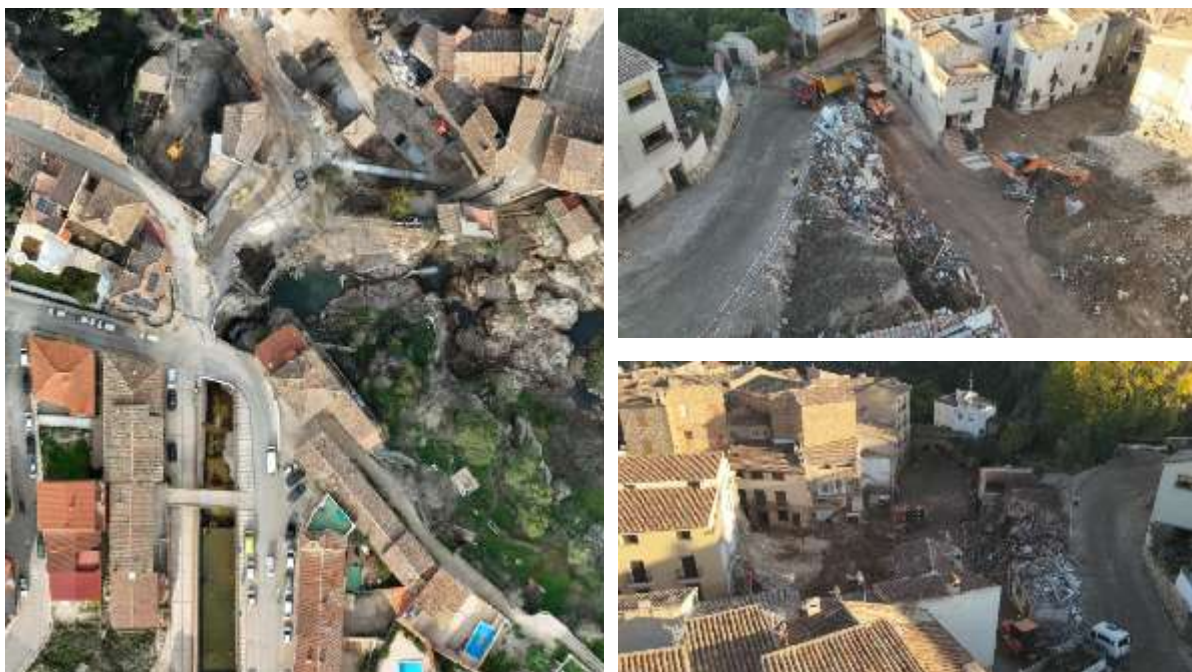
Figura 62. Imágenes aéreas tomadas desde un dron durante las labores de reconstrucción. Fuente: Ayuntamiento de Letur
