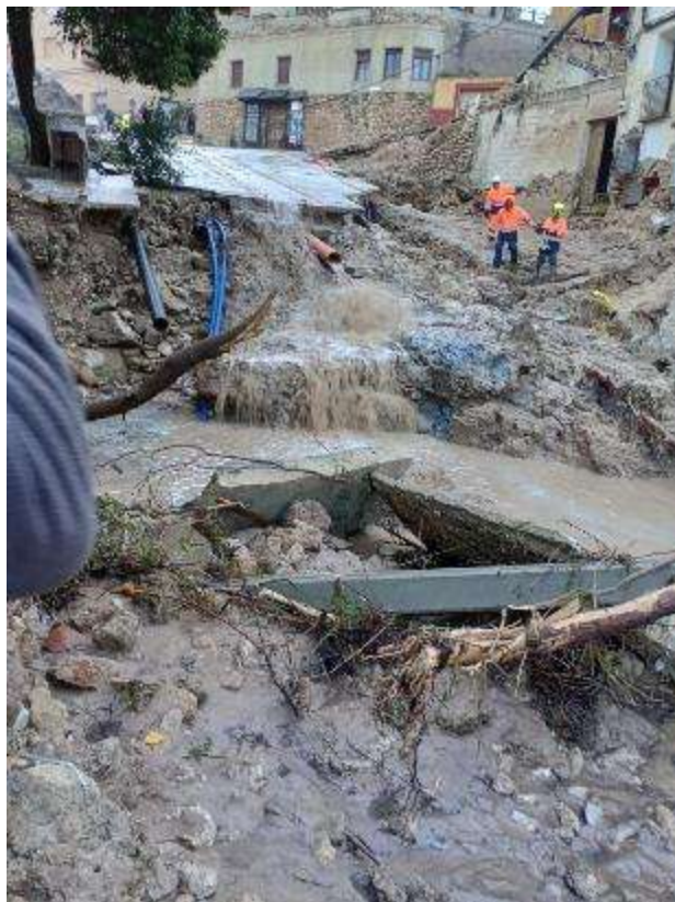
Figura 52. Conducciones seccionadas, entrada al casco histórico de Letur
