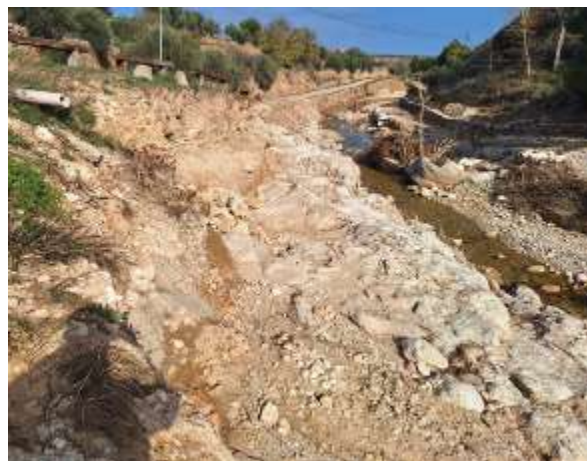
Figura 58. Muro del cauce junto al camino de la Dehesa
