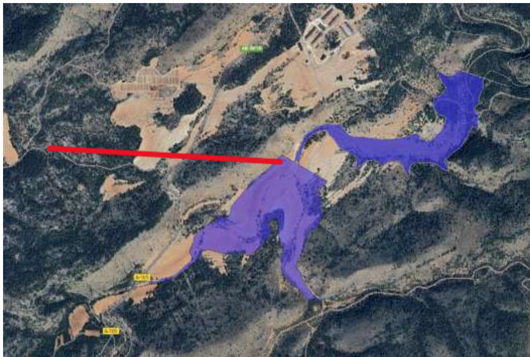
Figura 81. Vaso de los embalses a coronación: presa de laminación, aguas abajo. y presa de laminación y toma de aguas arriba
