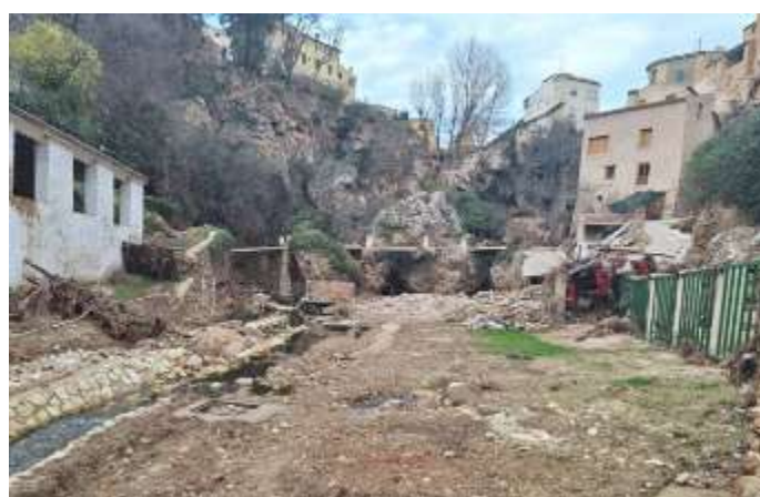
Figura 55. Zona del camino de los Toros tras la DANA 2024
