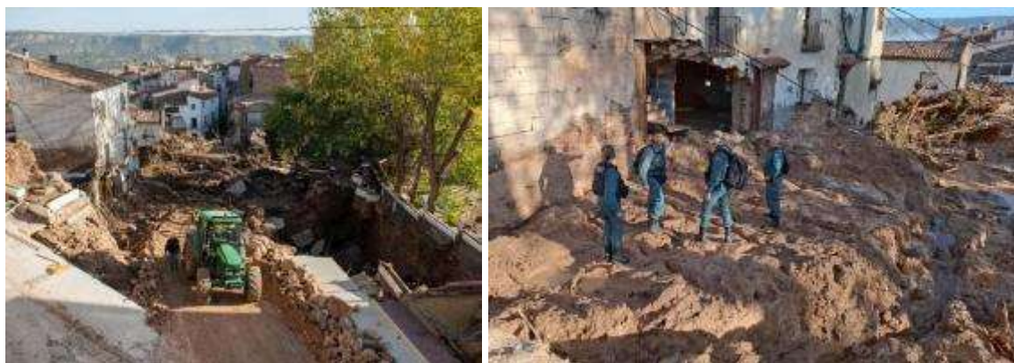
Figura 35. Socavón en la calle de la Cuesta de Las Moreras. Al fondo se aprecia el derrumbe de viviendas
