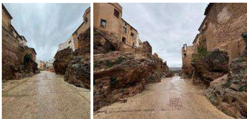
Figura 44. Calle del Barranco, la imagen de la izquierda está tomada hacia aguas arriba, y la de la derecha hacia aguas abajo
