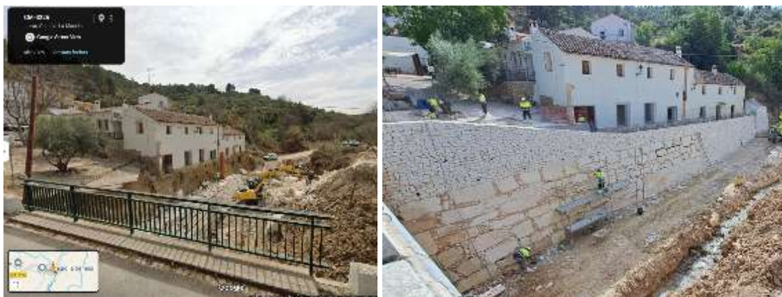
Figura 69. Rambla de la Dehesa de Letur, reconstrucción del muro del cauce
