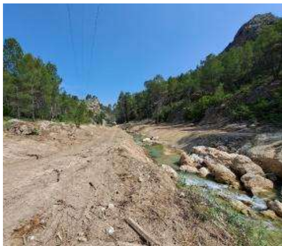
Figura 65. Acondicionamiento del arroyo de Letur
