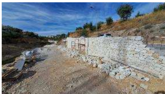
Figura 63. Reconstrucción muro del cauce junto camino San Antón
