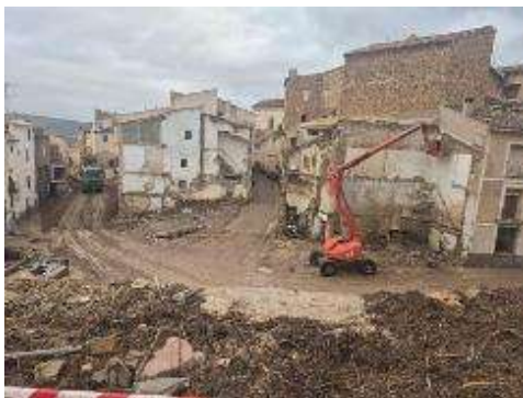
Figura 40. Estado de la plaza de Las Moreras tras las labores de desescombro, fotografía tomada desde donde se situó el edificio que colapsó
