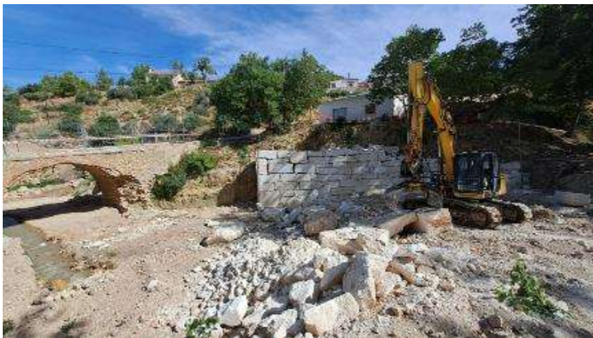
Figura 67. Reconstrucción de las aletas del puente arco
