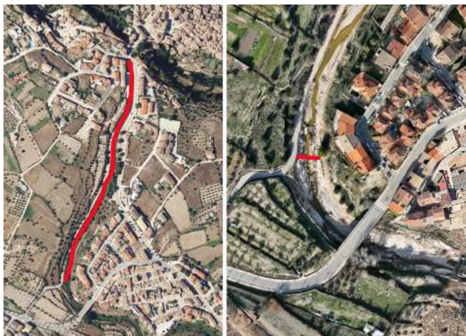
Figura 83. Ámbito del encauzamiento, trazado a la izquierda e inicio del encauzamiento a la derecha
