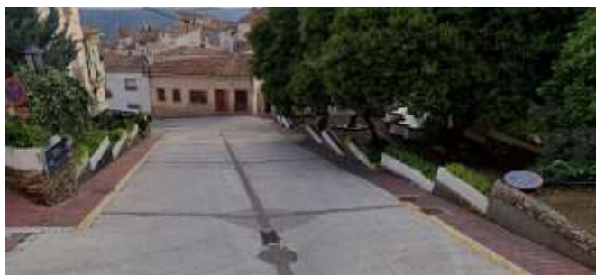
Figura 33. Cuesta de la calle Moreras antes de la DANA 2024
