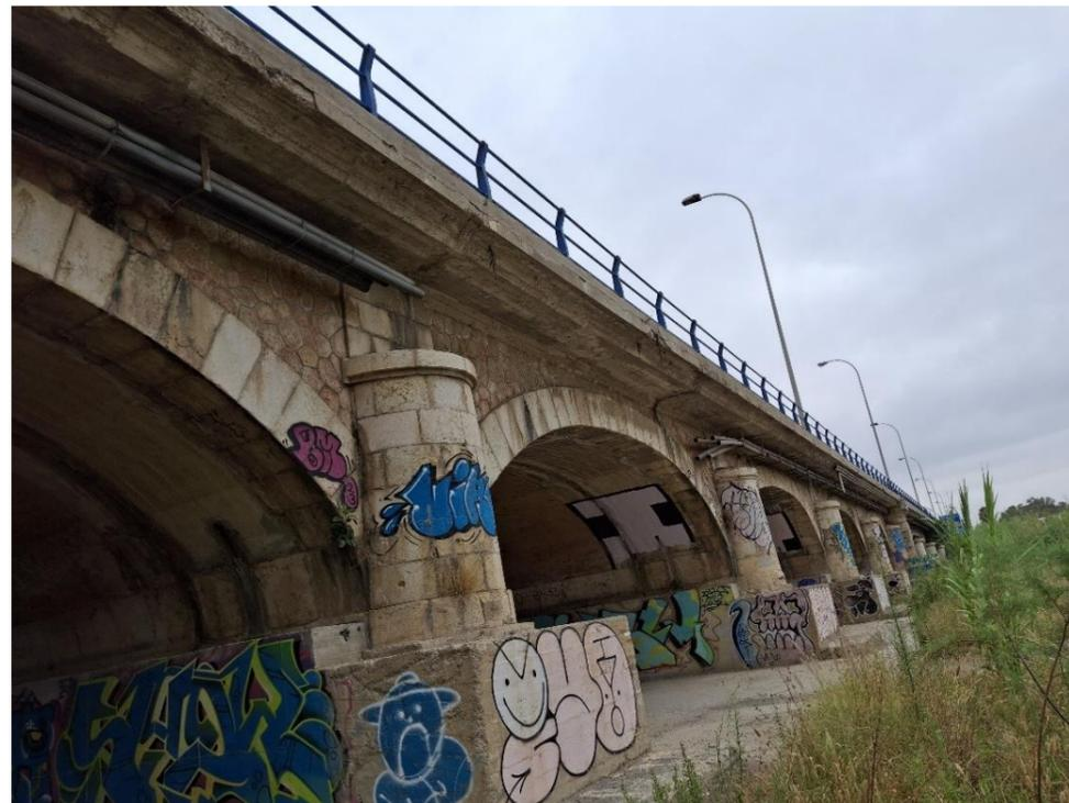
**Figura 69. Estructura aguas abajo. Arcos rebajados.**
