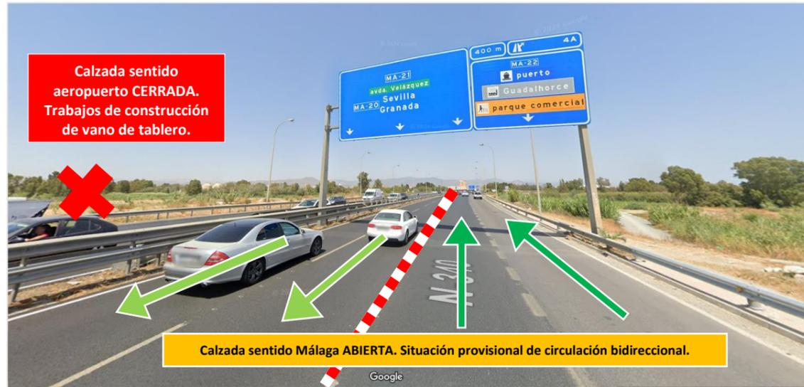
Figura 84. MA-21. Trabajos de construcción de vano de tablero. Esquema de circulación provisional en calzada sentido Málaga. Fuente: Google maps 2024.
