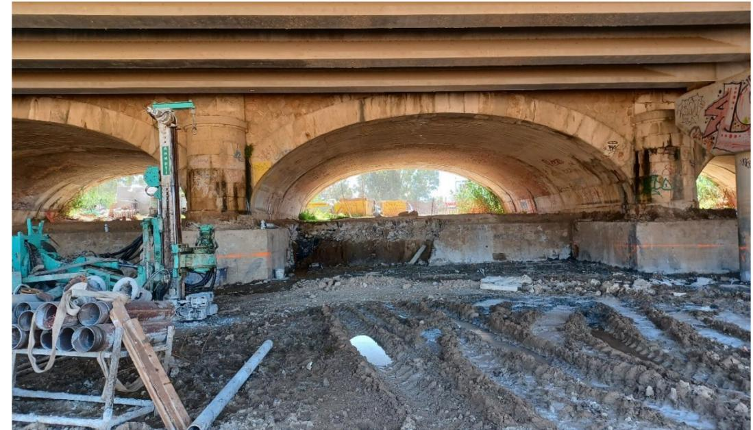
Figura 14. Obras en ejecución. Inyecciones entre vanos. Octubre 2022
