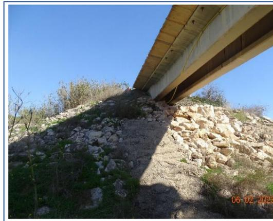
**Figura 125. Estribo de entrada perdido en pedraplén y hormigón en masa.**
