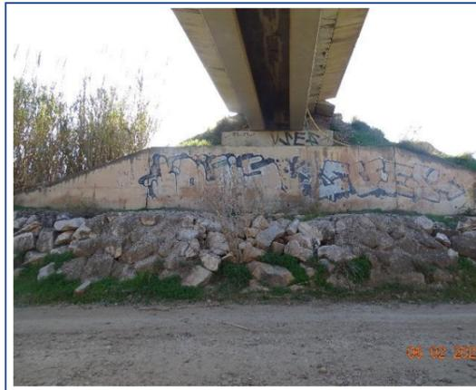
**Figura 127. Estribo de salida. Muro y aletas.**
