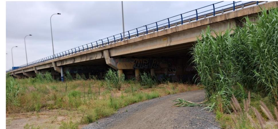
Figura 68. Estructura aguas arriba. Tablero vigas doble T
