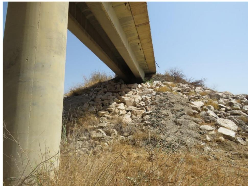
Figura 117. Terraplén de estribo de la estructura de ferrocarril existente en la zona de proyecto. Margen izquierda.
