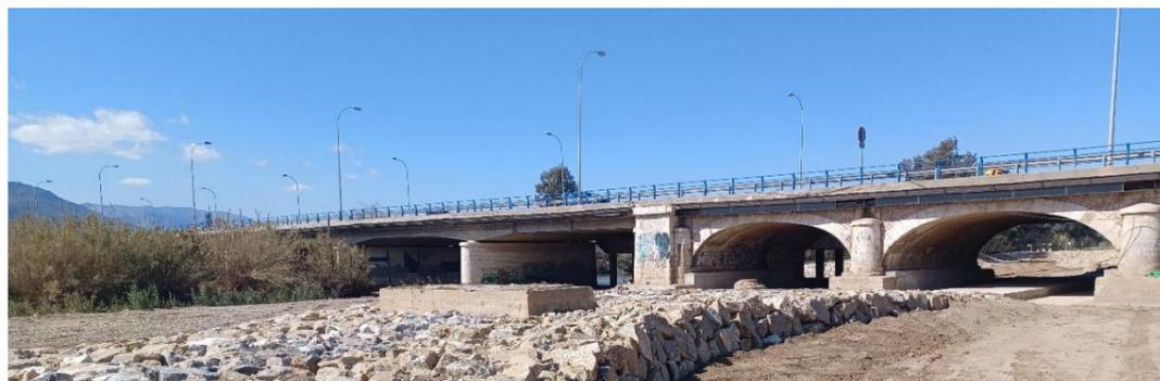
**Figura 70. Estructura aguas abajo. Losas nervadas + Arcos rebajados.**
