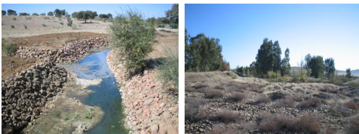
Imagen 2.- Escollera en el Arroyo Borrachuelo y una zona de extracción de áridos en el Río Zujar . Fuente: Libro Digital del Agua. MARM
