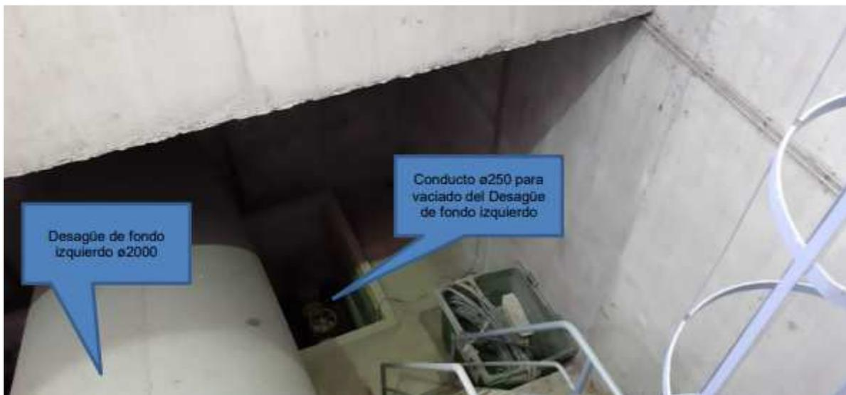
En la actualidad, ninguna de esas válvulas es de regulación, por lo que se propone reemplazar la válvula de aguas abajo por una anular, en caso de que no cupiera en la arqueta, se dispone una de regulación en la salida al cauce.
