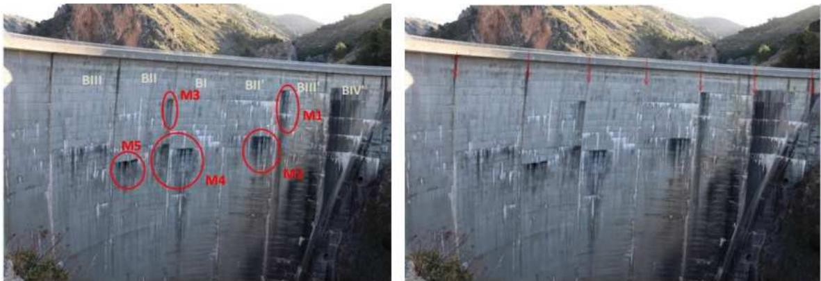
Ilustración 1 – Filtraciones detectadas en la inspección visual.
