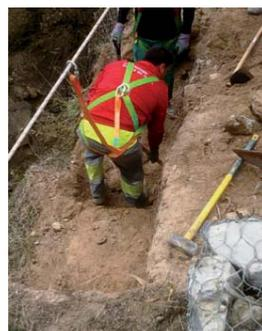
Foto 3 Trabajos de mantenimiento de diques para la retención de fijos procedentes, en parte, de cortas de extracción de caudal, en la cuenca del arroyo Merdero, T.M. de Prihalán (Gauklajara).
