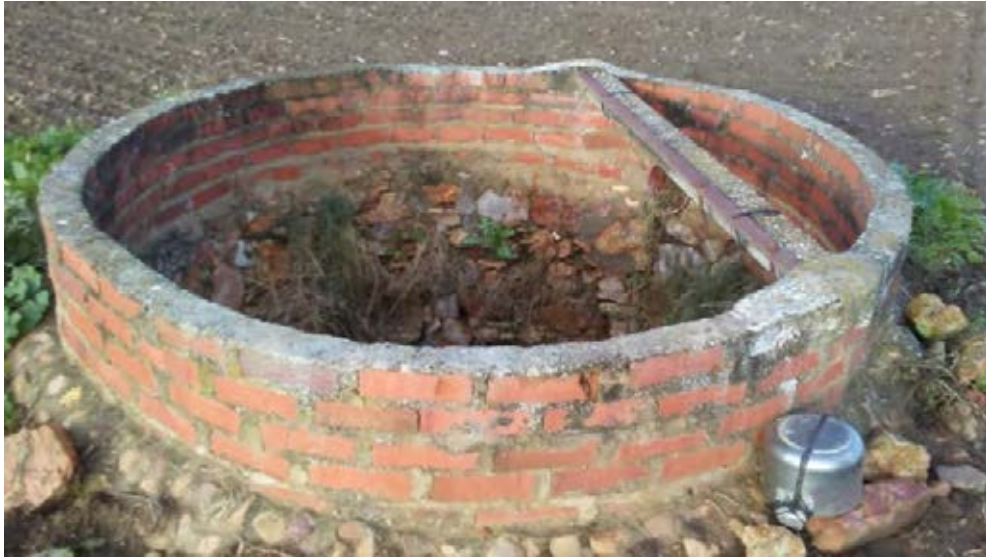
Fig. 6.1. Ejemplo de pozo de gran diámetro, con agua somera, en el que tradicionalmente se han instalado bombas de succión o "chuponas".
