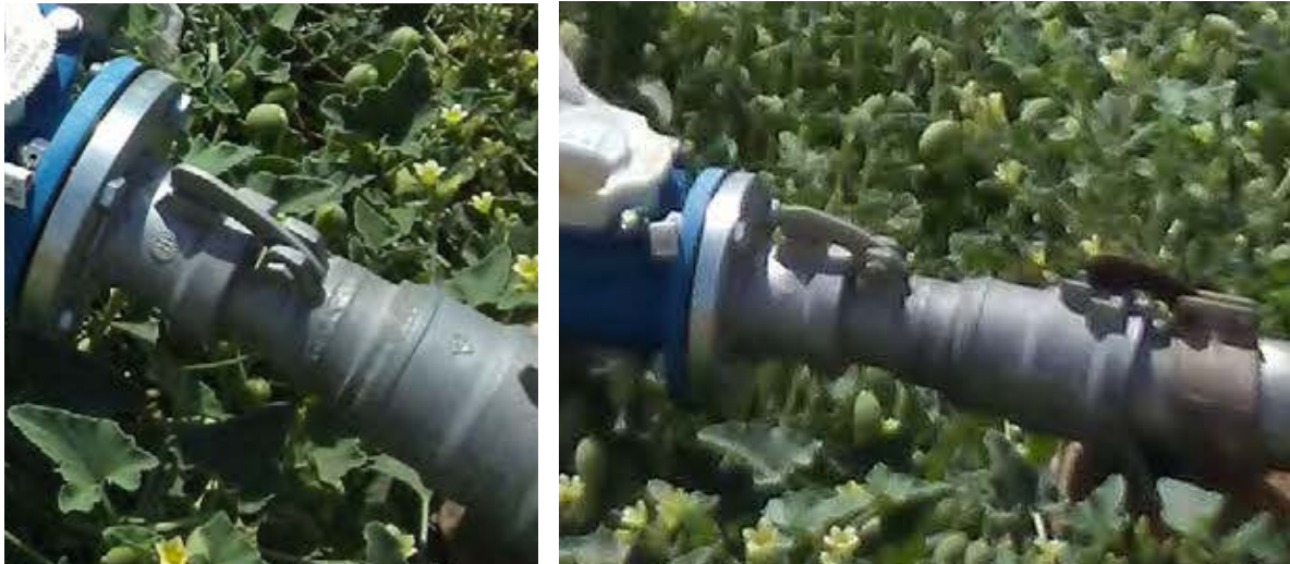
Figura 3.18. Uniones incorrectas aguas abajo de un contador. El desmontaje de las mismas da acceso al interior del contador.
