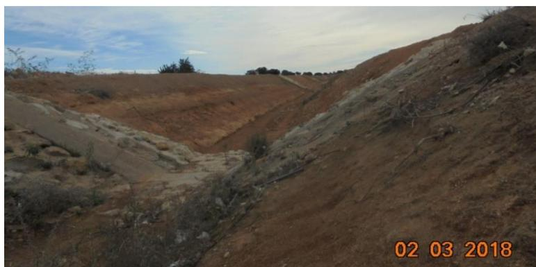
Figura 137: Ejemplo de tramo con encauzamiento y rastrillos en la Rambla del Albujón (entre el Canal del Campo y Pozo Estrecho).
