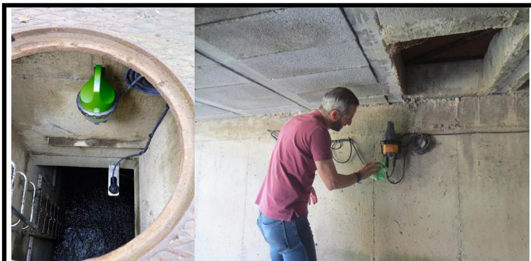
**Modelo SOFREL LT-US sin alimentación eléctrica: Sensor de nivel por ultrasonidos (US) sin contacto + Registrador de datos SOFREL LT-US (Data Logger). Cortesía de «LACROIX SOFREL».**
