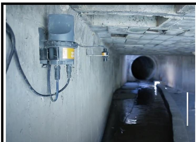
**Modelo SOFREL LT-US sin alimentación eléctrica: Sensor de nivel por ultrasonidos (US) sin contacto + Registrador de datos SOFREL LT-US (Data Logger). Cortesía de «LACROIX SOFREL».**
