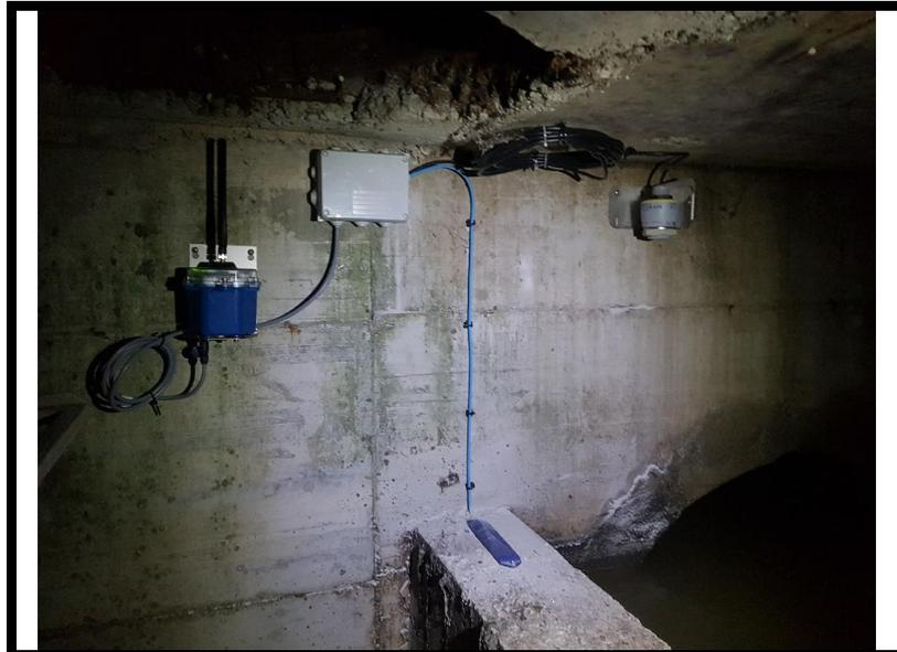
*Monitorización de un aliviadero (muro) en el sistema de saneamiento compuesto por una Sonda capacitiva para detectar el inicio y el final del vertido por el labio del aliviadero, un Sensor de nivel (radar) y un Registrador de datos (data logger). Cortesía de CleanWater, Microcom y VEGA.*
