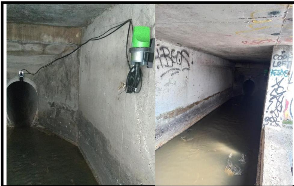
**Caudalímetro con tecnología Radar instalado en un aliviadero del sistema de saneamiento unitario en Alcalá de Henares (Madrid), compuesto por: Sensor de nivel por ultrasonidos (US) sin contacto + Sensor de velocidad Radar VRad-i sin contacto + Registrador de Datos SOFREL LT-US. Cortesía de «FCC – aqualia» y «LACROIX SOFREL».**
