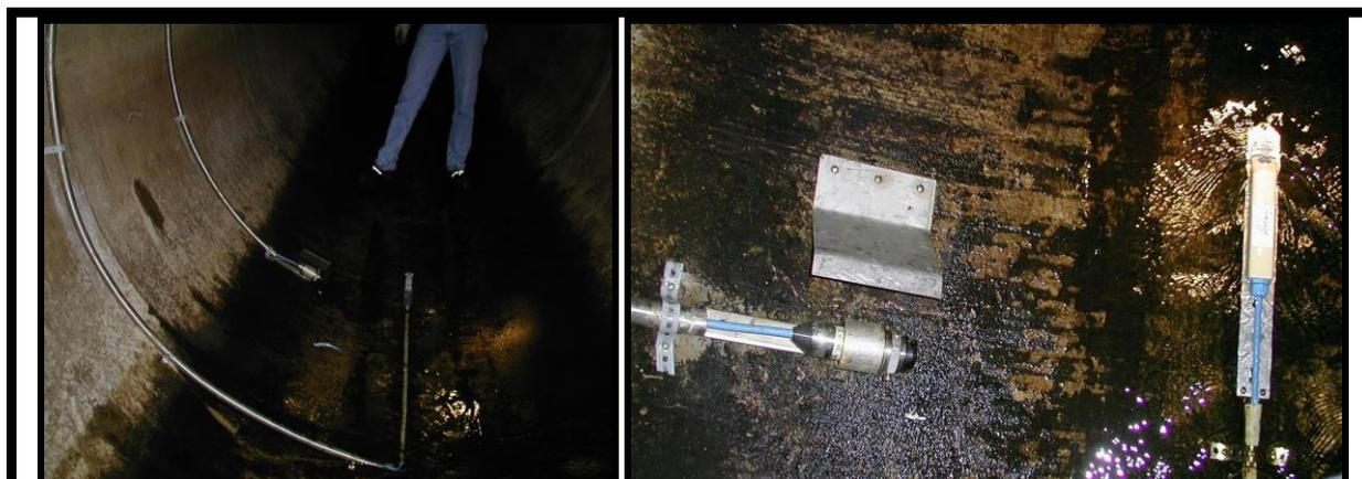
***Caudalímetro con tecnología de correlación ultrasónica para canales y colectores parcialmente llenos. Instalación en colector de aguas residuales con un DN de 2.000 mm, con medición independientes del nivel y la velocidad del caudal. Cortesía de Lana Sarrate, S.A.***
