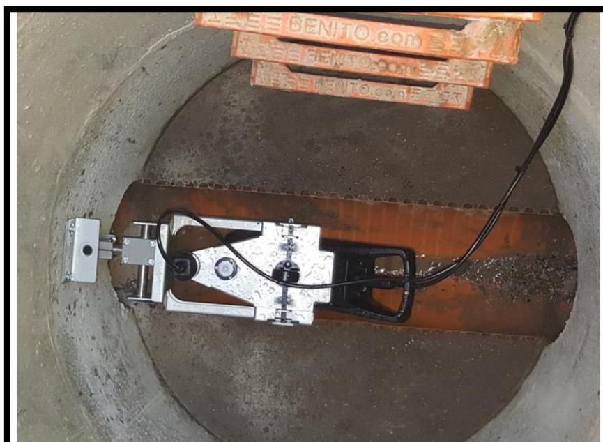
***Caudalímetro Radar Raven-Eye instalado en la red de saneamiento de Guadalajara. Cortesía de Mejoras Energéticas, S.A.***
