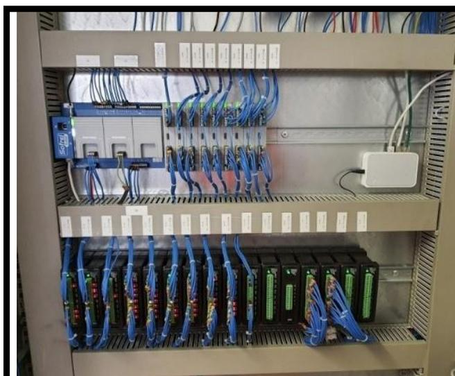
*Gama SOFREL S4W Large: Estación Remota (RTU) (o autómatas de telegestión) instalada en una planta de tratamiento en Pontedeume (A Coruña). Explotación local y remota mediante navegador web HTML5. Ciberseguridad integrada (gestión de certificación digital). Redundancia de comunicaciones: puerto ETHERNET/módem 4G. Traslado de alarmas. Explotación directa en pantalla gráfica interactiva integrada de 7" y 10". Cortesía de «LACROIX SOFREL».*
