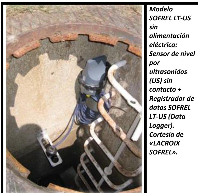
**Modelo SOFREL LT-US sin alimentación eléctrica: Sensor de nivel por ultrasonidos (US) sin contacto + Registrador de datos SOFREL LT-US (Data Logger). Cortesía de «LACROIX SOFREL».**
