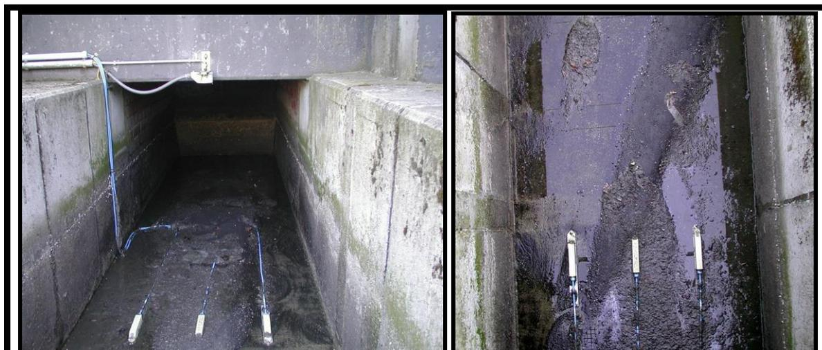
***Caudalímetro con tecnología de correlación ultrasónica para canales y colectores parcialmente llenos. Cortesía de Lana Sarrate, S.A.***
