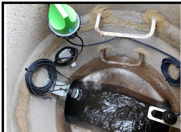
**Caudalímetro con tecnología Radar: Sensor de nivel por ultrasonidos (US) sin contacto + Sensor de velocidad Radar VRad-i sin contacto + Registrador de Datos SOFREL LT-US (Data Logger) + Caja estanca de conexión. Se puede calcular el caudal a partir de la fórmula  $Caudal = Velocidad \times \text{Área mojada}$ . Cortesía de «LACROIX SOFREL».**
