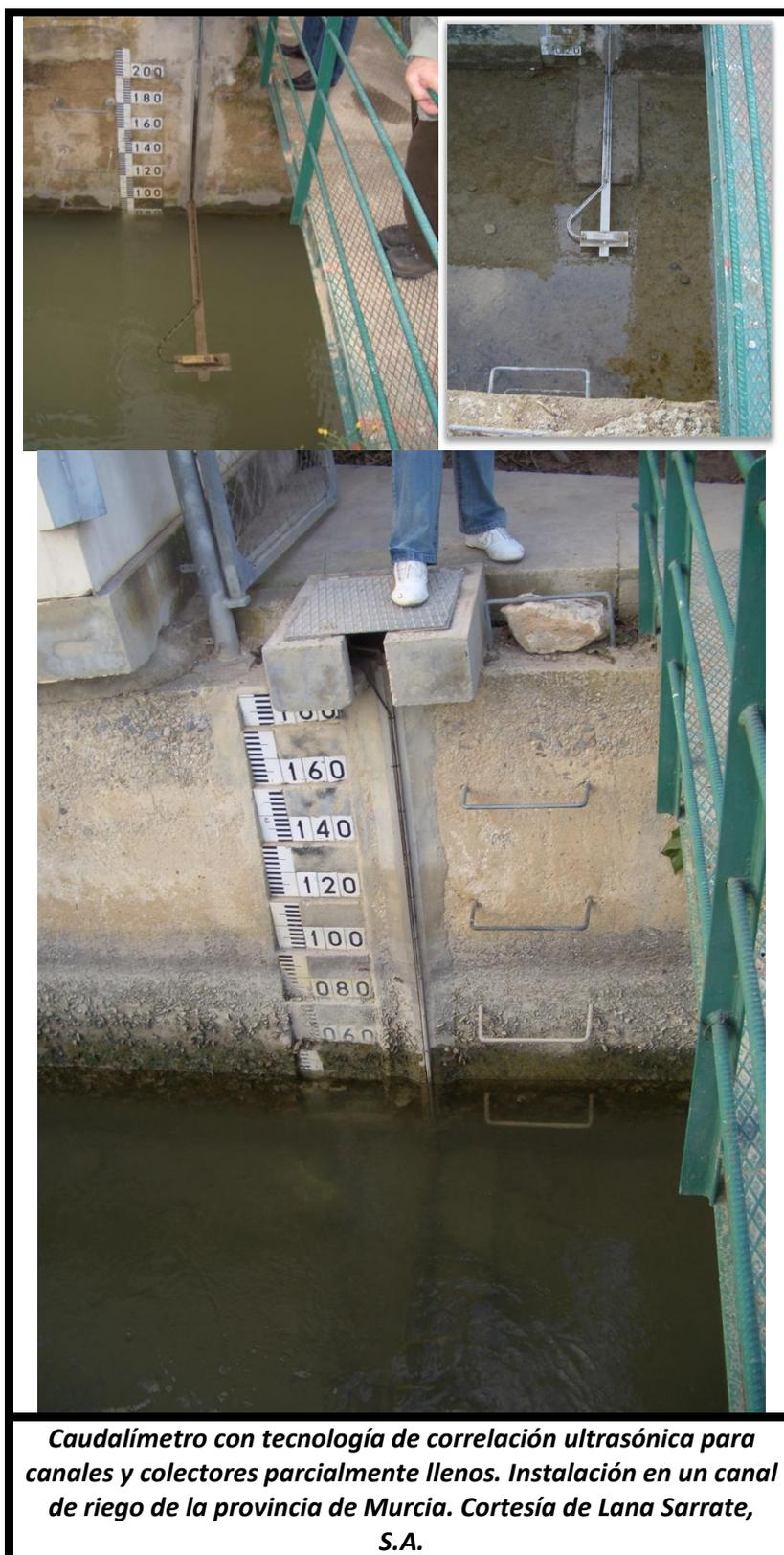
***Caudalímetro con tecnología de correlación ultrasónica para canales y colectores parcialmente llenos. Instalación en un canal de riego de la provincia de Murcia. Cortesía de Lana Sarrate, S.A.***
