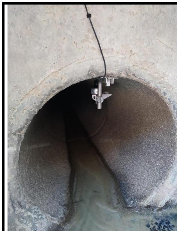
***Limnómetro ultrasónico Sonicens® 3 instalado en la red de saneamiento de Tarragona. Cortesía de Mejoras Energéticas, S.A.***
