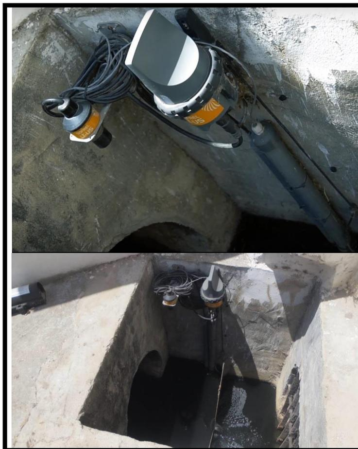
**Sensor de nivel por ultrasonidos (US) sin contacto + Registrador de Datos SOFREL LT-US (Data Logger) + Sensor de conductividad + sensor de pH en vertedero triangular. Cortesía de «LACROIX SOFREL».**
