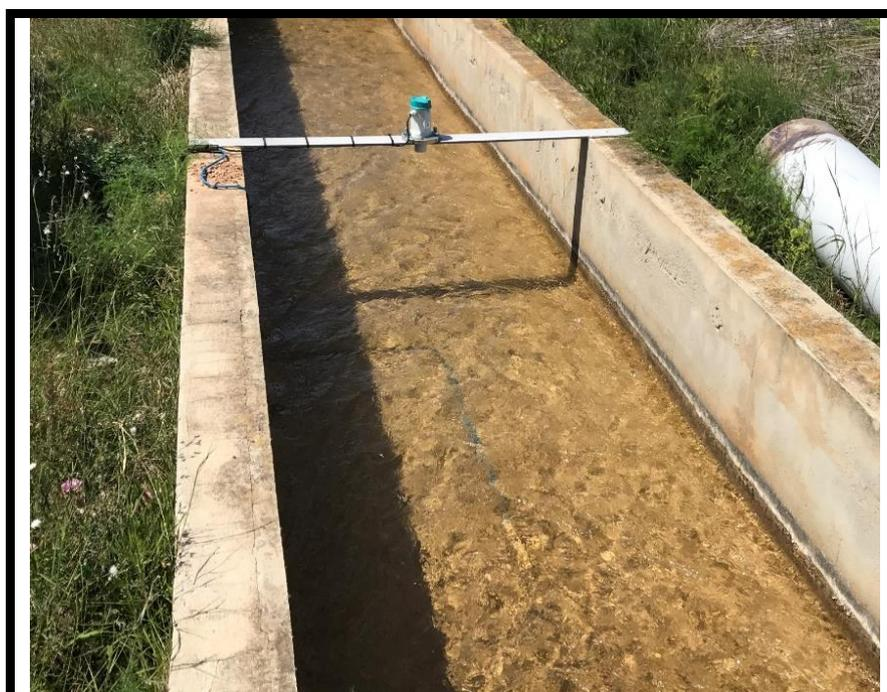
***Caudalímetro con tecnología de correlación ultrasónica para canales y colectores parcialmente llenos. Instalación en canal de riego con medición independiente del nivel y de la velocidad del caudal de agua. Comunidad Valenciana. Cortesía de Lana Sarrate, S.A.***
