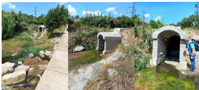
Punto de vertido por desbordamientos del sistema de saneamiento en episodios de lluvia al río Ripoll. Se han instalado 3 cestas TecnoGrabber® para la retención de sólidos y se encuentra monitorizado el colector [Sensor de nivel por ultrasonidos (US) sin contacto + Registrador de datos SOFREL LT-US (Data Logger)]. Parc de La Clota. Sabadell (Barcelona). Río Ripoll. 28/07/2022. Fuente: Agencia Catalana del Agua (ACA), LACROIX y Tecnoconverting.
