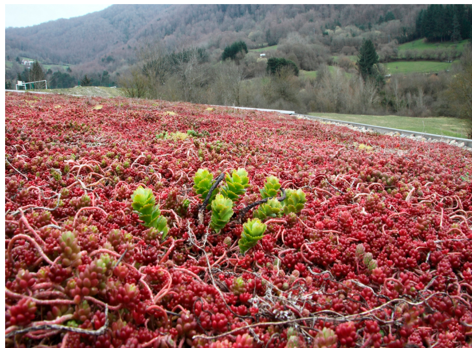
FIGURA 4: CUBIERTA VEGETADA SOBRE UN TANQUE DE LAMINACIÓN EN EUGI (NAVARRA).
