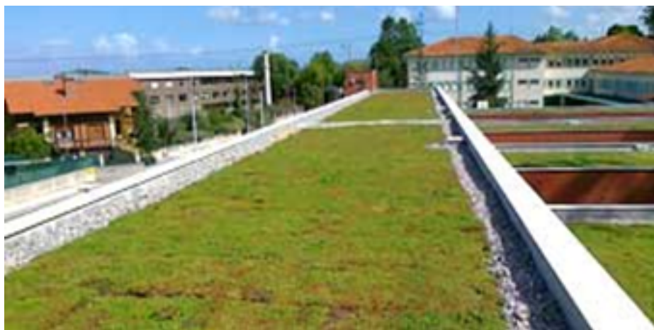
FIGURA 1: EJEMPLO DE CUBIERTA CON SUSTRATO SOMERO.
