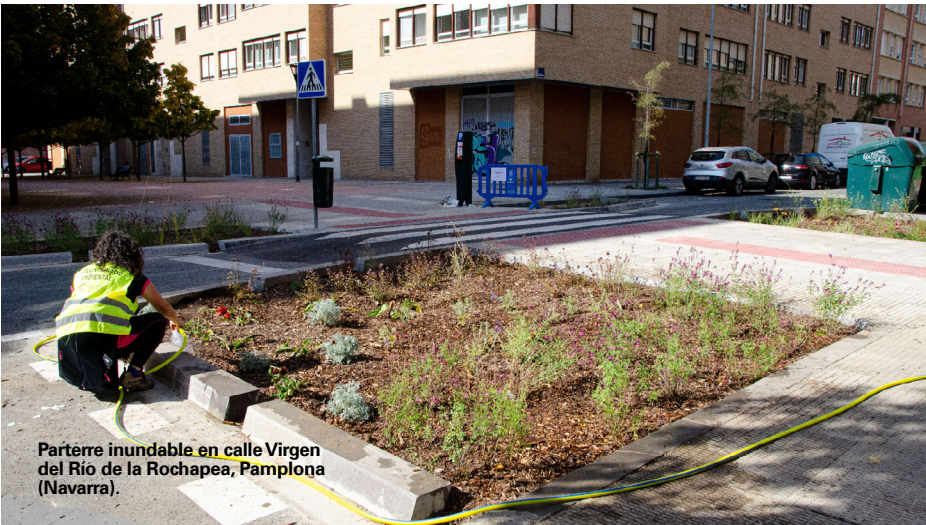
FIGURA 31: EJEMPLOS DE INCORPORACIÓN DE SUDS EN CALLES.
