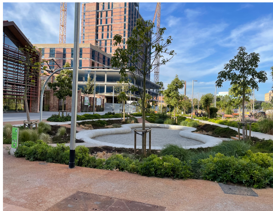
BALSA DE INFILTRACIÓN EN LA CALLE CRISTÓBAL DE MOURA, BARCELONA. EN ESTE EMPLAZAMIENTO EL MANTENIMIENTO DE LOS SUDS DEBE SER CONTINUADO Y ESPECIALIZADO DEBIDO A LA PRESENCIA DE VEGETACIÓN VARIADA Y SU VALOR ESTÉTICO Y RECREATIVO.
