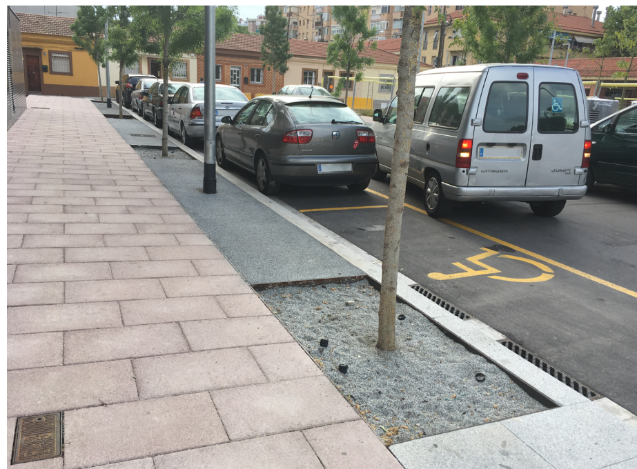
FIGURA 6: ALCORQUES ESTRUCTURALES EN EL BARRIO DE BON PASTOR, BARCELONA.
