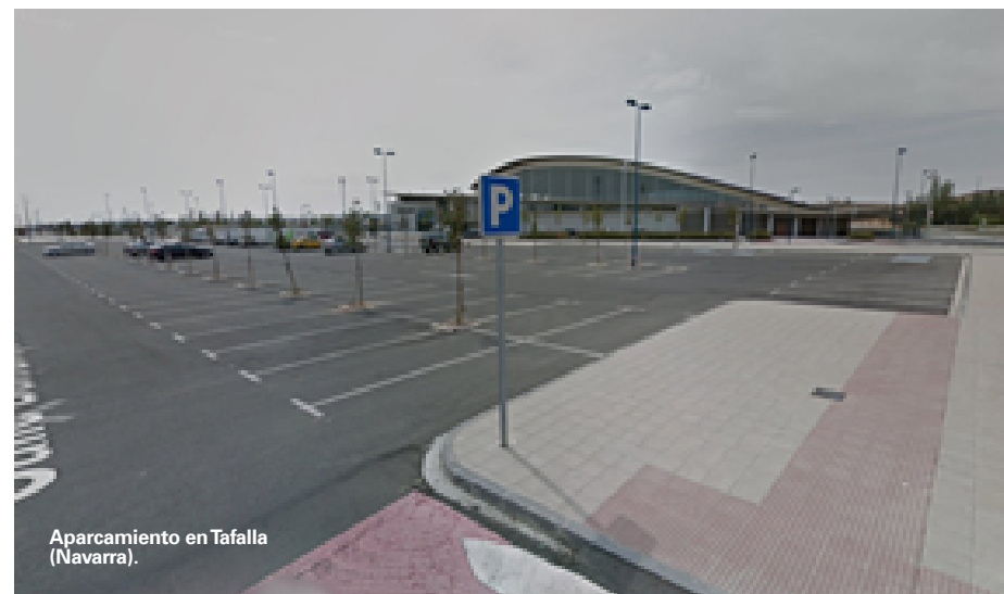
FIGURA 32: APARCAMIENTOS EN DIFERENTES ZONAS DE NAVARRA. FUENTE: GOOGLE MAPS.
