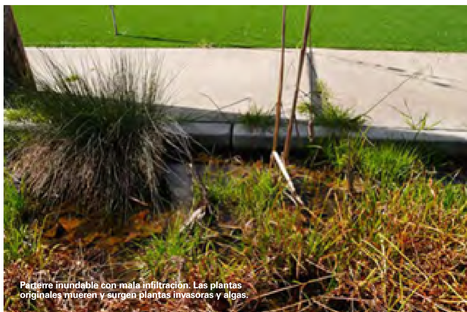
FIGURA 46: EJEMPLOS DE MAL MANTENIMIENTO. FUENTE: SAN MATEO COUNTYWIDE WATER PREVENTION PROGRAM 2020.
