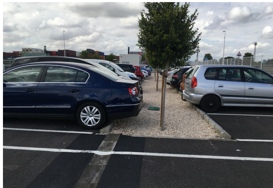
FIGURA 8: ZANJA DE INFILTRACIÓN EN RIBA-ROJA DE TÚRIA (VALENCIA).
