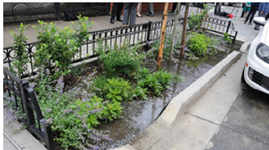
FIGURA 8: EJEMPLOS DE PARTERRES INUNDABLES SIN RIEGO.
