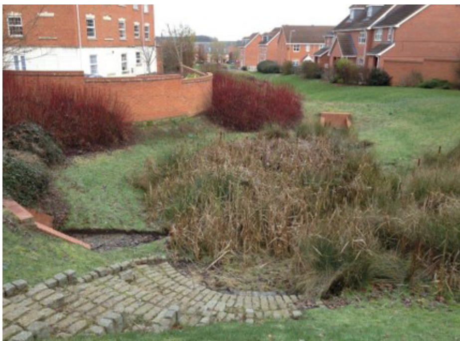
FIGURA 36: INTEGRACIÓN DE SUDS EN NUEVOS DESARROLLOS: JARDÍN DE LLUVIA (IZQUIERDA) Y CUNETA VEGETADA (ARRIBA). LEICESTER (REINO UNIDO).
