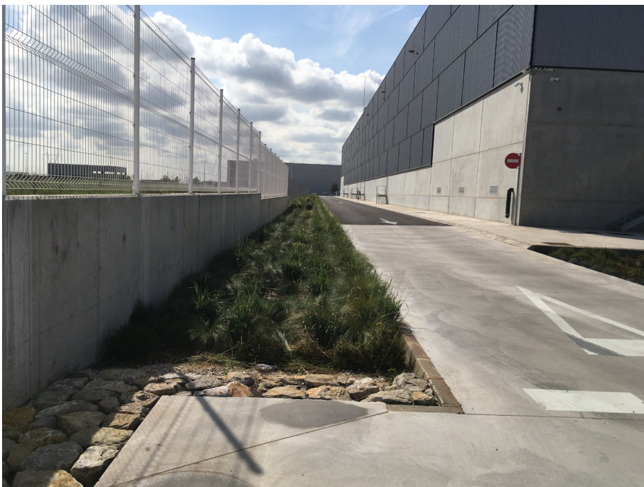
ZONA DE BIORRETENCIÓN EN EL POLÍGONO DE RIBA-ROJA DE TÚRIA. EN ESTE EMPLAZAMIENTO EL MANTENIMIENTO SE CENTRA EN EL FUNCIONAMIENTO CORRECTO DEL SUDS Y EL CONTROL DEL CRECIMIENTO EXCESIVO DE LA VEGETACIÓN. EL VALOR ESTÉTICO ES SECUNDARIO.
