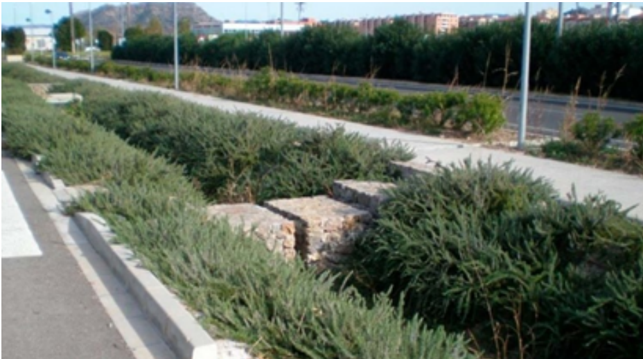
FIGURA 11: EJEMPLO DE CUNETAS VEGETADAS.
