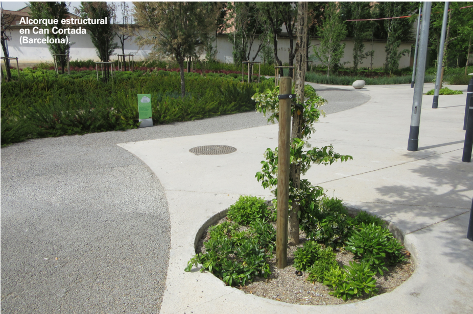
FIGURA 21: EJEMPLO DE INCORPORACIÓN DE SUDS EN ZONAS DE URBANIZACIÓN DENSA.
