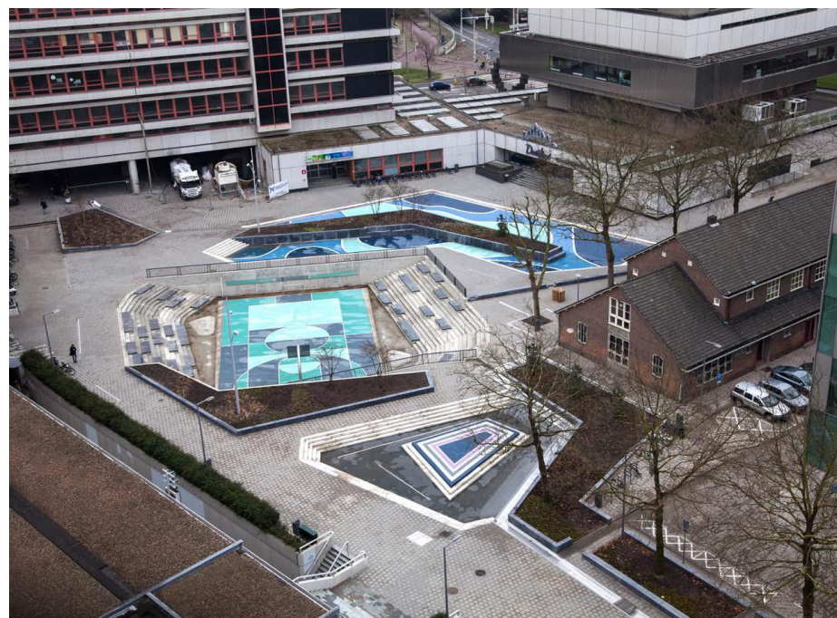
FIGURA 13: BALSA DE DETENCIÓN MULTIFUNCIONAL. WATER SQUARE EN BENTHEMPLEIN, ROTTERDAM (PAÍSES BAJOS). FUENTE: OSSIP VAN DUIVENBODE, DE URBANISTEN.
