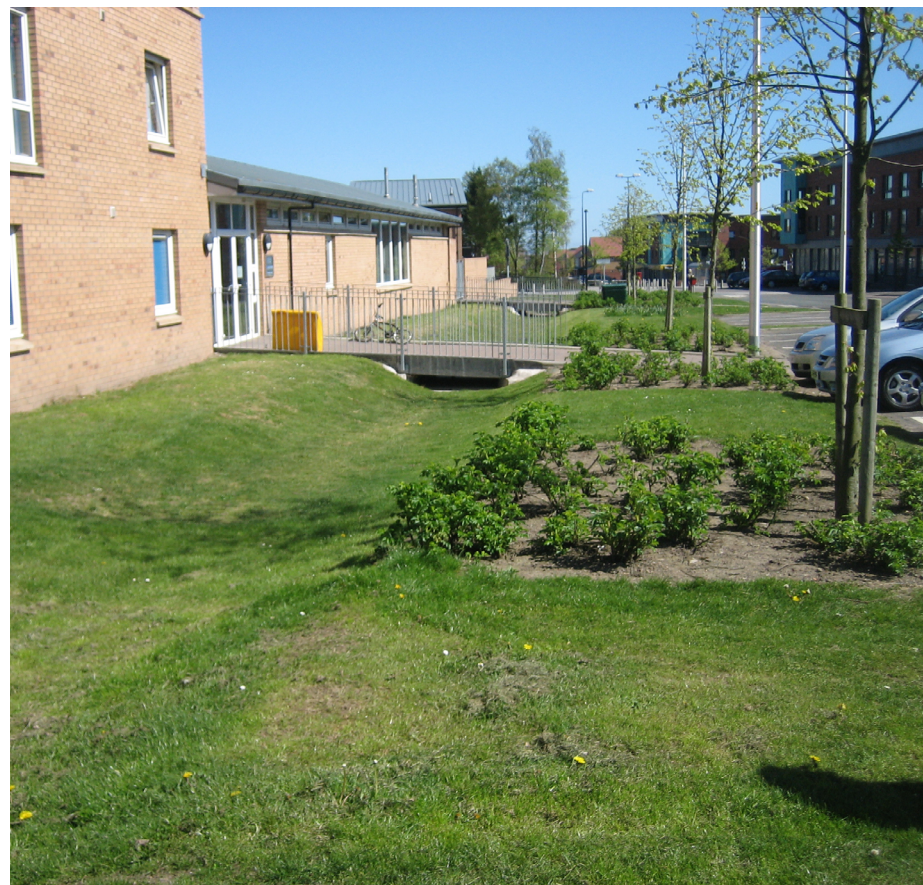
FIGURA 12: CUNETA VEGETADA EN DUNDEE (ESCOCIA).
