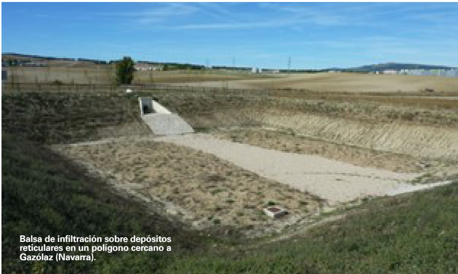
FIGURA 27: EJEMPLOS DE INCORPORACIÓN DE SUDS EN ZONAS INDUSTRIALES.
