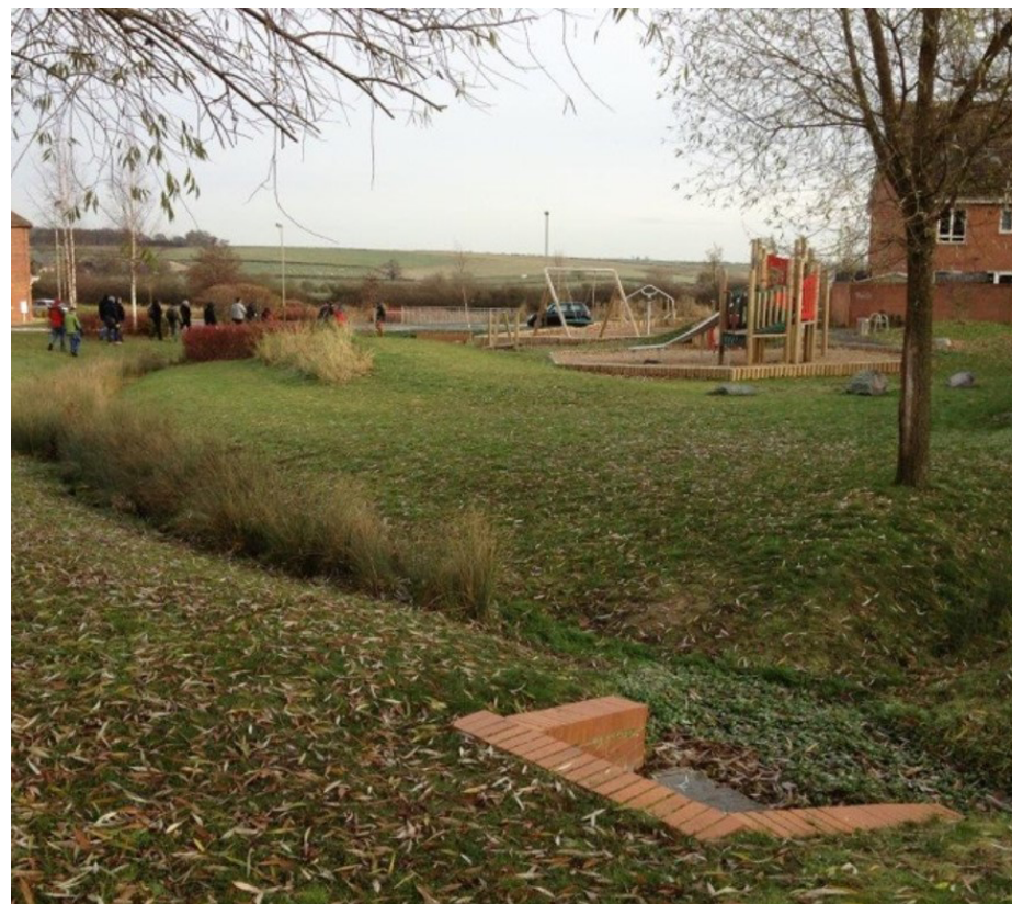
FIGURA 36: INTEGRACIÓN DE SUDS EN NUEVOS DESARROLLOS: JARDÍN DE LLUVIA (IZQUIERDA) Y CUNETA VEGETADA (ARRIBA). LEICESTER (REINO UNIDO).
