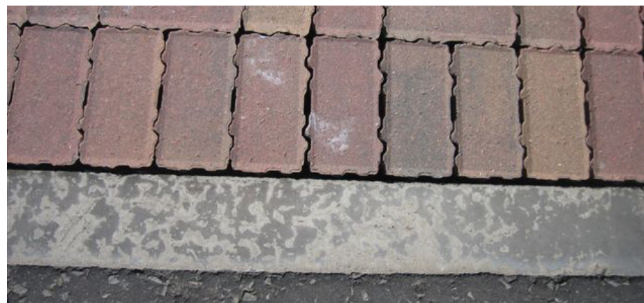
FIGURA 44: EJEMPLO DE ADOQUÍN PERMEABLE BIEN MANTENIDO, DUNDEE (ESCOCIA).
