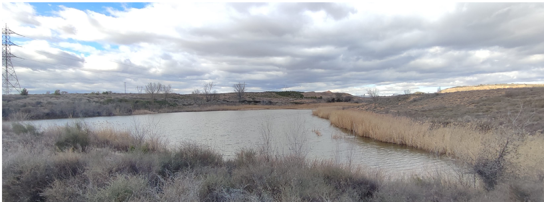
FIGURA 14: ESTANQUE DE LAMINACIÓN DE PLUVIALES DE LA CIUDAD AGROALIMENTARIA DE TUDELA (NAVARRA).
