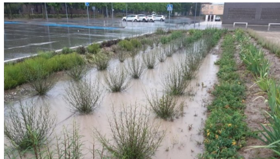
FIGURA 49: IMÁGENES DE LOS SUDS REALIZADOS EN EL APARCAMIENTO DE UPNA, TUDELA (NAVARRA).
