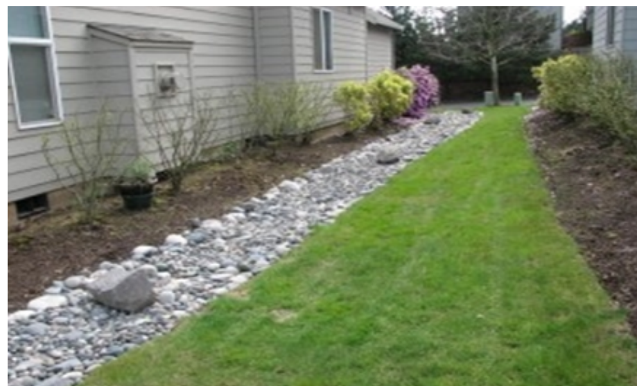
FIGURA 10: EJEMPLOS DE DRENES FILTRANTES.
