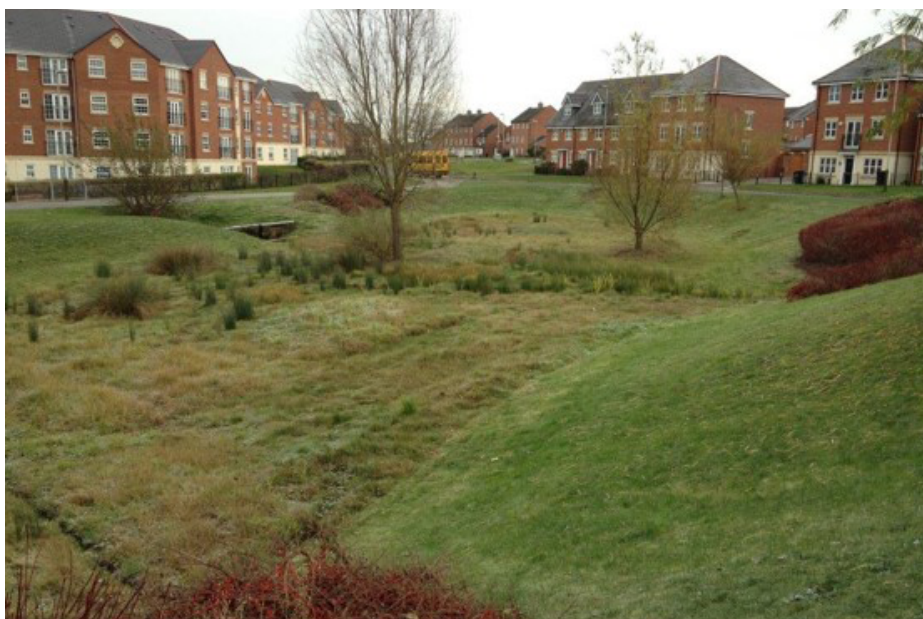
FIGURA 37: INTEGRACIÓN DE SUDS EN NUEVOS DESARROLLOS: REPRESA DE MADERA EN CUNETTA VEGETADA (ARRIBA) Y Balsa de infiltración (ABAJO). LEICESTER (REINO UNIDO).
