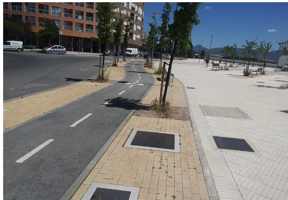
FIGURA 5: PAVIMENTO PERMEABLE EN AV. PAMPLONA, ECHAVACIOZ NORTE (NAVARRA).
