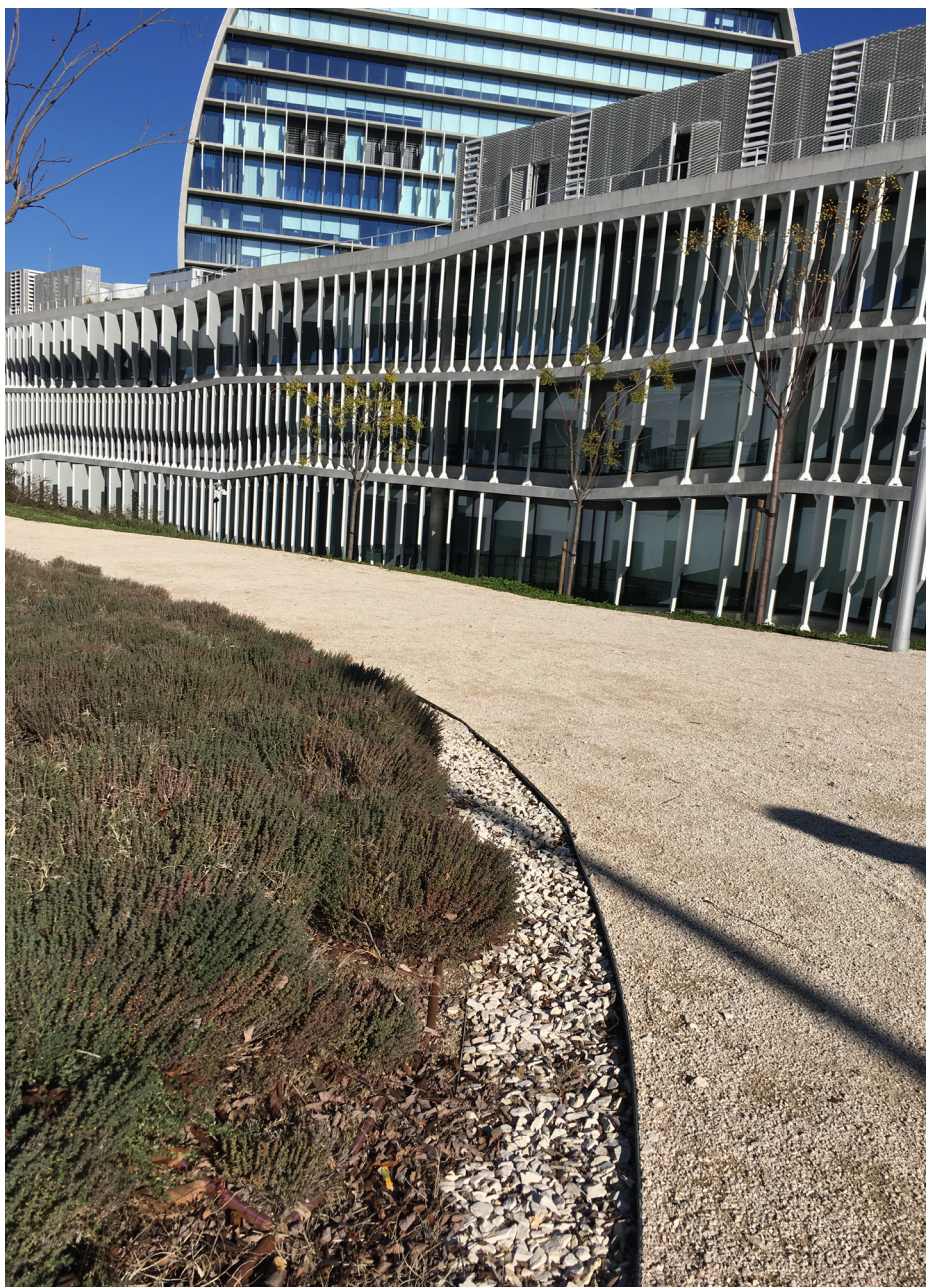
FIGURA 10: DREN FILTRANTE EN LA ZONA VERDE DE LA SEDE DEL BBVA, MADRID.
