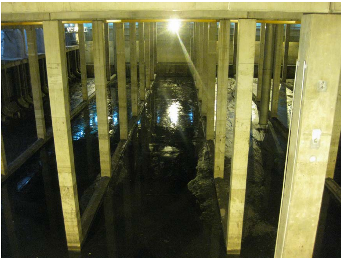
Figura 91 Tanque de tormentas de Butarque
