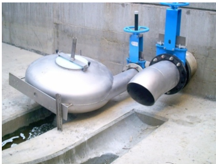
Figura 19 Válvula tipo vórtice
