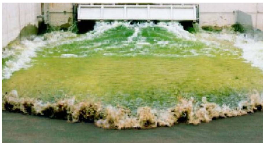
Figura 47 Operación de limpieza mediante la apertura de la clapeta de descarga
