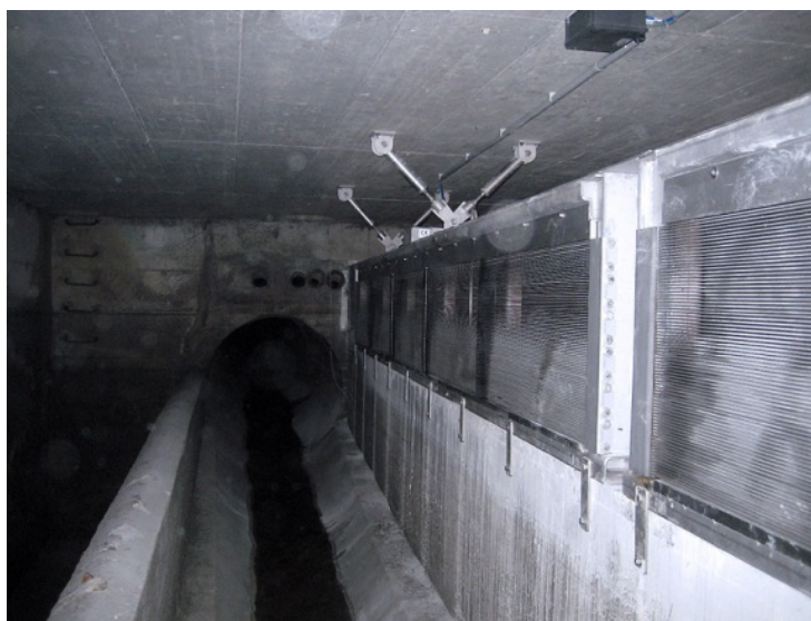
Figura 29 Ejemplo de reja de tamiz de barras
