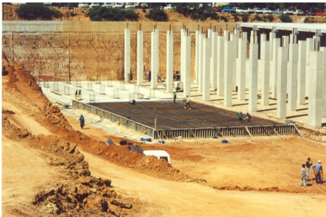
Figura 72 Ejecución de solera y pilares
