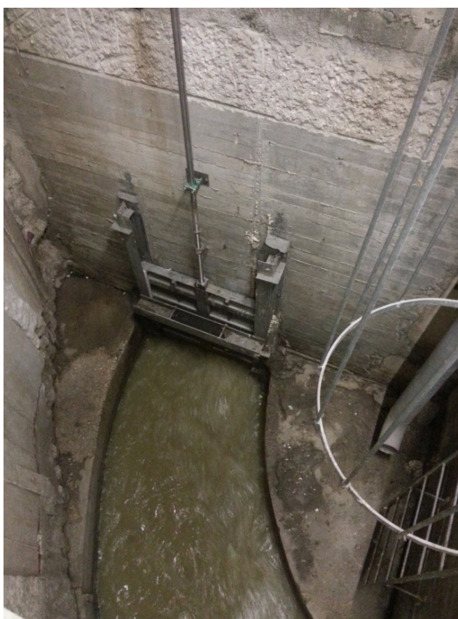
Figura 43 Compuerta en el tanque Jose Manuel Obrero (Alicante)
