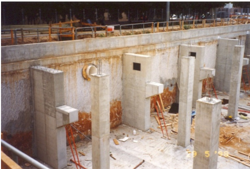
Figura 73 Ejecución de cimentación y pilares
