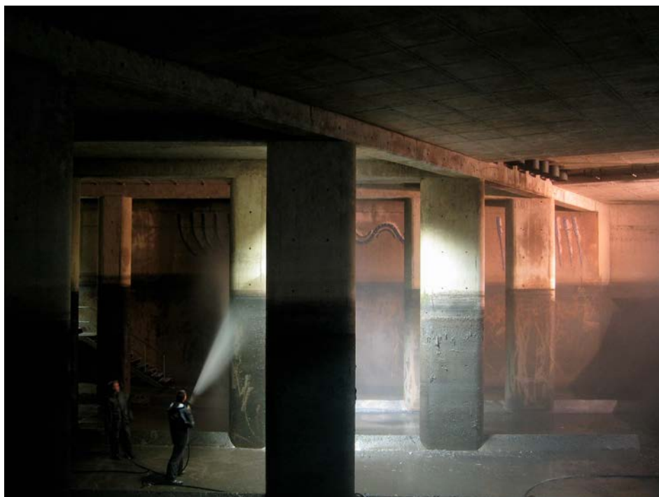
Figura 60 Limpieza manual de tanque en Gijón
