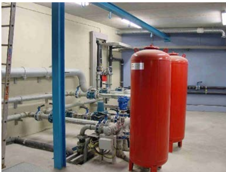
Figura 82 Circuito de agua a presión
