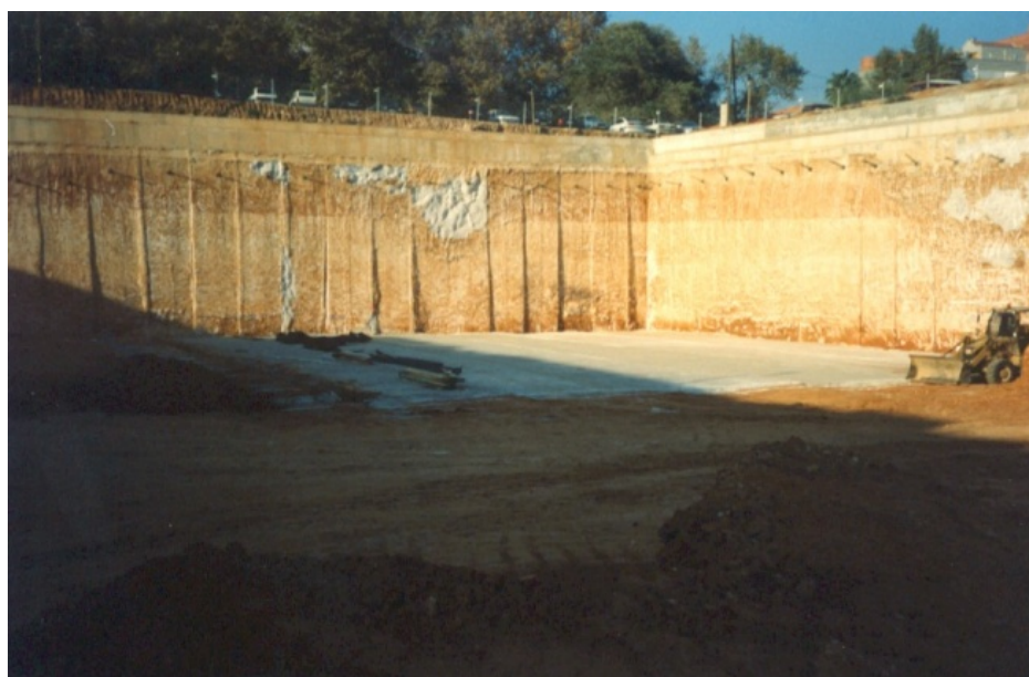
Figura 65 Excavación entre pantallas.
