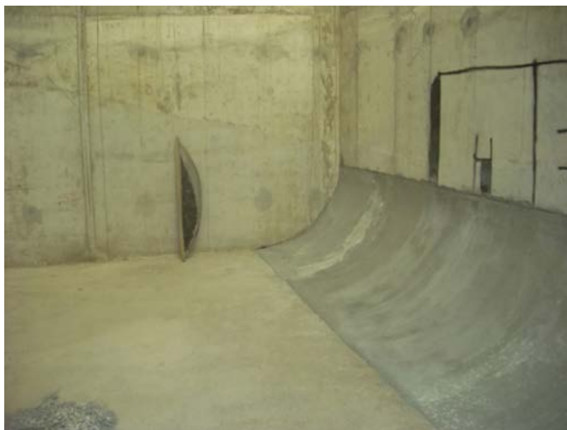
Figura 46 Cuna de hormigón entre la solera y la pared
