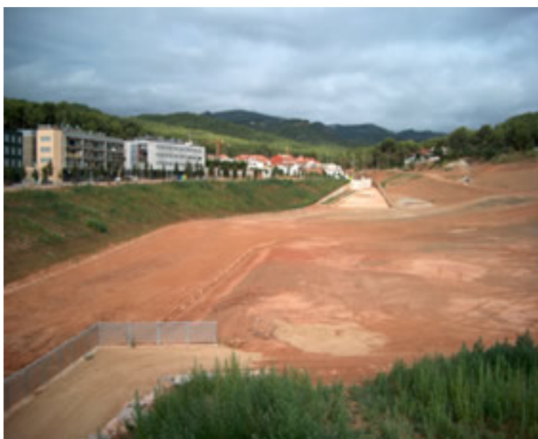
Figura 35 Balsa a cielo abierto. (Viladecans, Barcelona)
