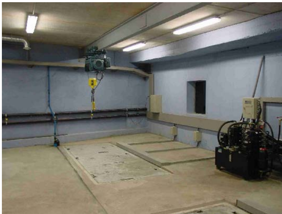
Figura 84 Locales técnicos, tapas de extracción de equipos y polipasto
