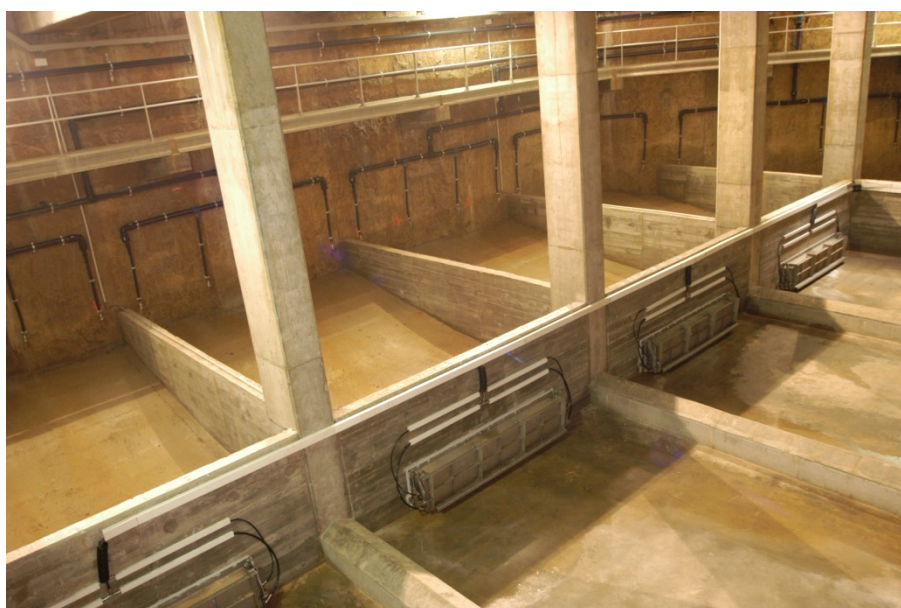
Figura 48 Ejemplo de cámaras de descarga y clapetas en el tanque de Vilalba dels Arcs (Barcelona)
