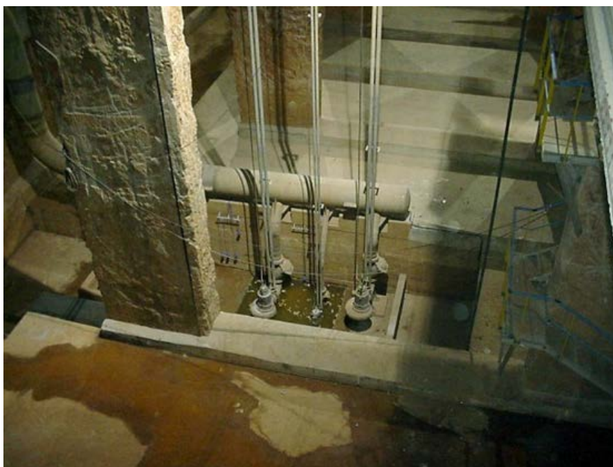
Figura 77 Pozo de bombeo de un tanque de tormentas
