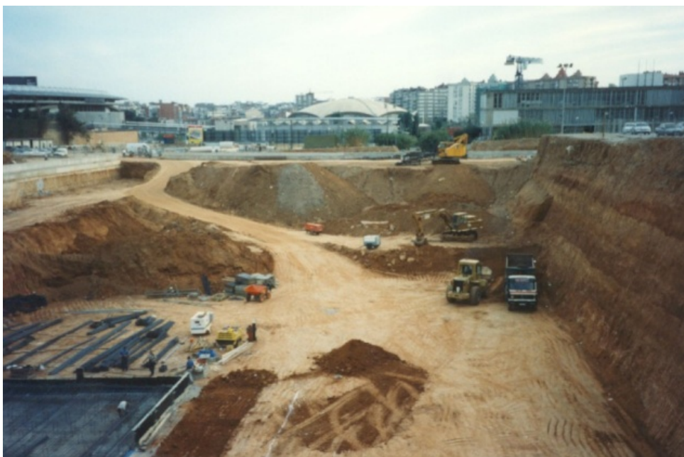
Figura 63 Excavación en talud
