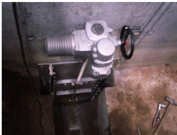
Figura 20 Compuerta con accionamiento eléctrico
