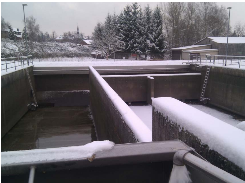
Figura 5 Ejemplo en Alemania de tanque multiconfiguración, con un cuerpo (el de arriba) de tipo on-line y dos (el de abajo) de tipo off-line
