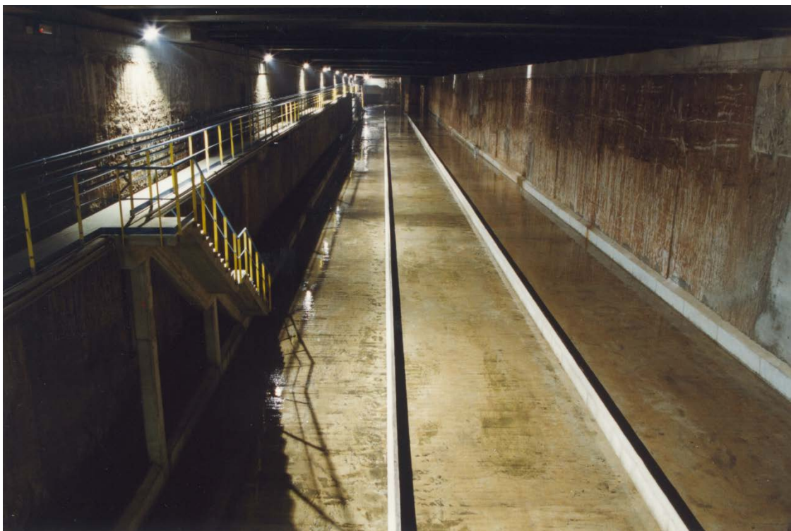
Figura 40 Ejemplo de pasarelas y escaleras de acceso a la solera en tanque de Bori Fontestà (Barcelona)
