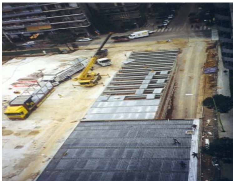
Figura 74 Cubierta ejecutada in situ
