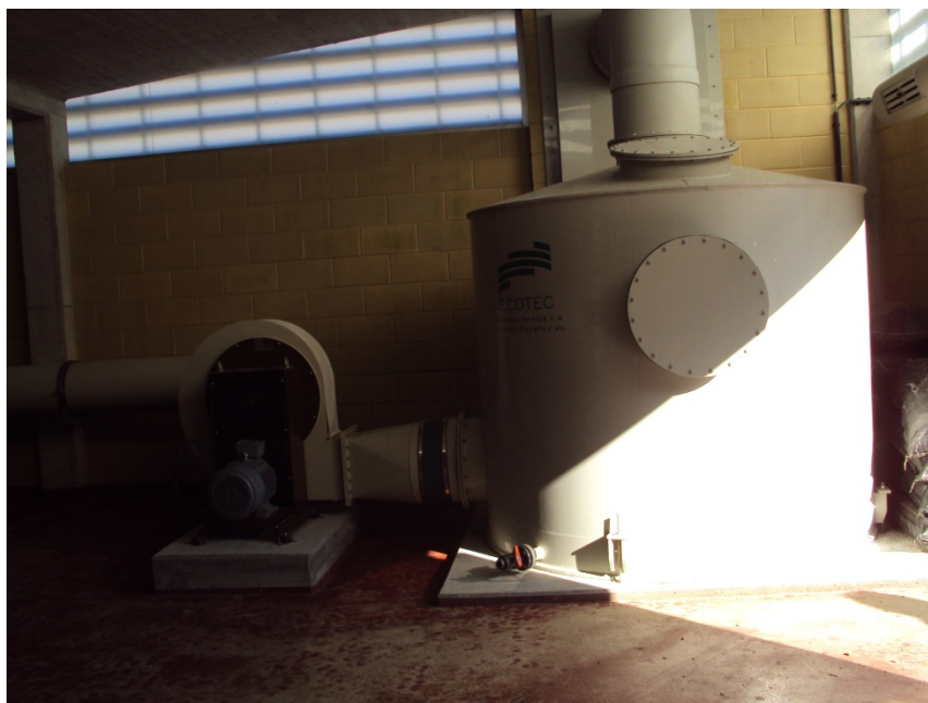
Figura 51 Extractor de aire y filtro de carbón activo
