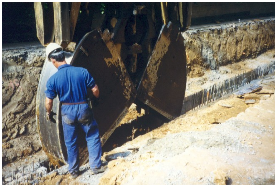
Figura 64 Ejecución de muro continuo.
