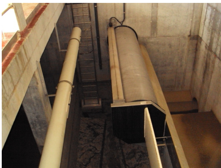
Figura 30 Rototamiz automático
