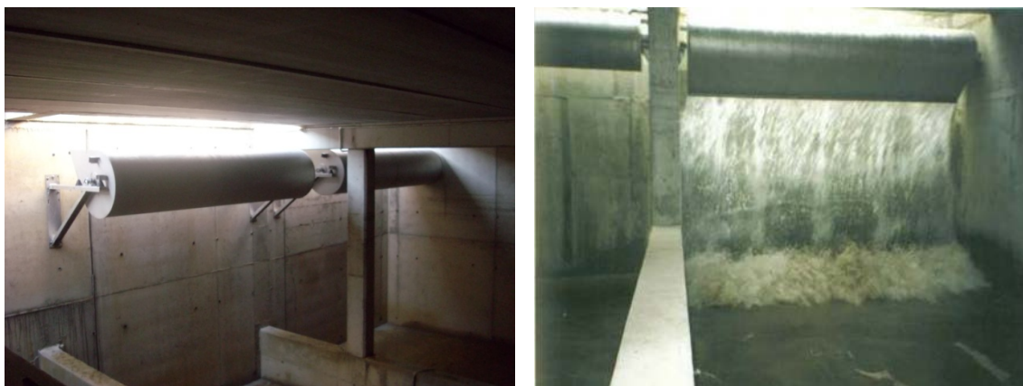
Figura 44 Limpiador basculante en reposo y en acción
