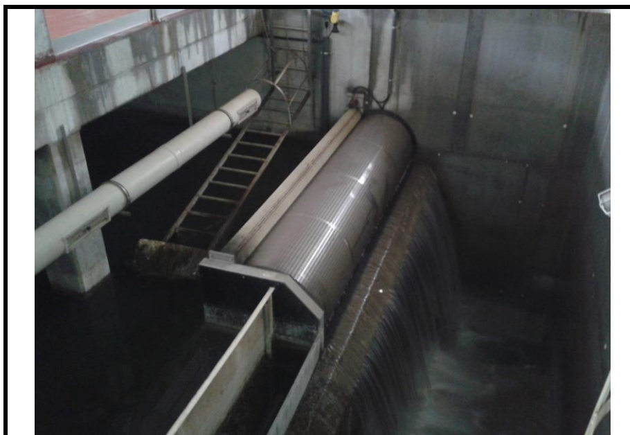
Filtro-Tamiz rotativo (Modelo FluidRotor) (DN 1.200 mm; L 4 m) con devolución de los sólidos gruesos y flotantes al colector. Recomendado para caudales elevados ( \leq 1.300 l/s·m). Fuente: CleanWater.
