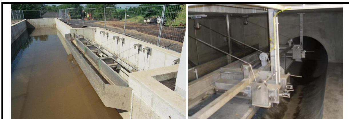
Tamiz de aliviadero de limpieza automática Tipo APA sin energía. En los sistemas de saneamiento y durante episodios de lluvia, las partículas suspendidas, los sólidos gruesos y flotantes, etc. son retenidos y almacenados por el tamiz. Una vez finalizado el episodio, son devueltos al colector o canal central para ser evacuados hacia la EDAR. Fuente: Hidrostack.
