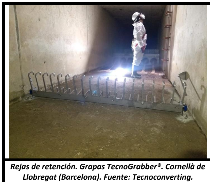
Rejas de retención. Grapas TecnoGrabber®. Sant Feliu de Llobregat (Barcelona). 15/12/2021. Fuente: Tecnoconverting.
