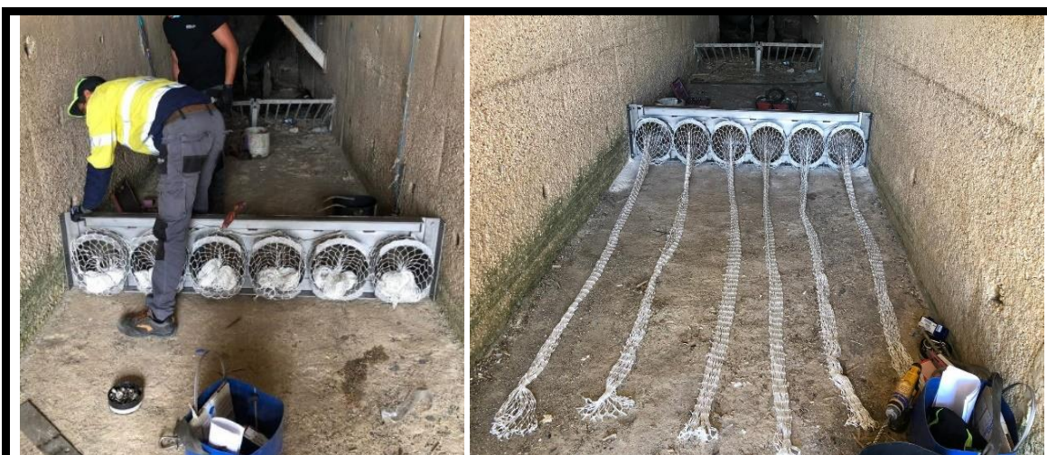
Instalación de 6 cestas TecnoGrabber®. Platja del Miracle (Tarragona). Fuente: Tecnoconverting.
