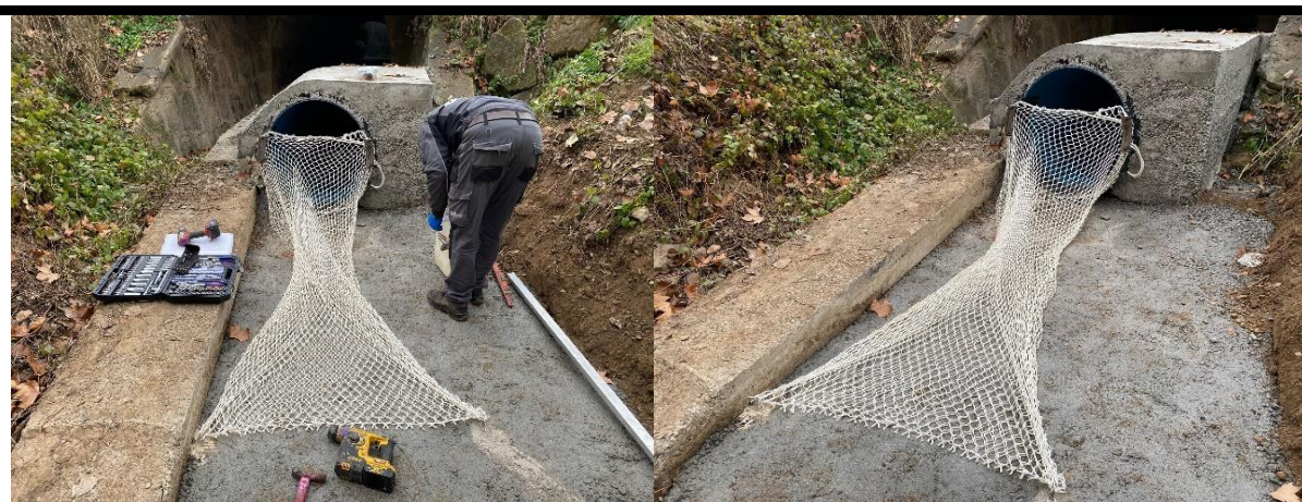
Instalación de 1 cesta TecnoGrabber® en un colector de \varnothing 800\text{mm} . El Pont de Vilomara i Rocafort (Barcelona). Fuente: Tecnoconverting.
