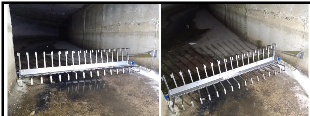
Rejas de retención. Grapas TecnoGrabber®. Sant Feliu de Llobregat (Barcelona). 15/12/2021. Fuente: Tecnoconverting.
