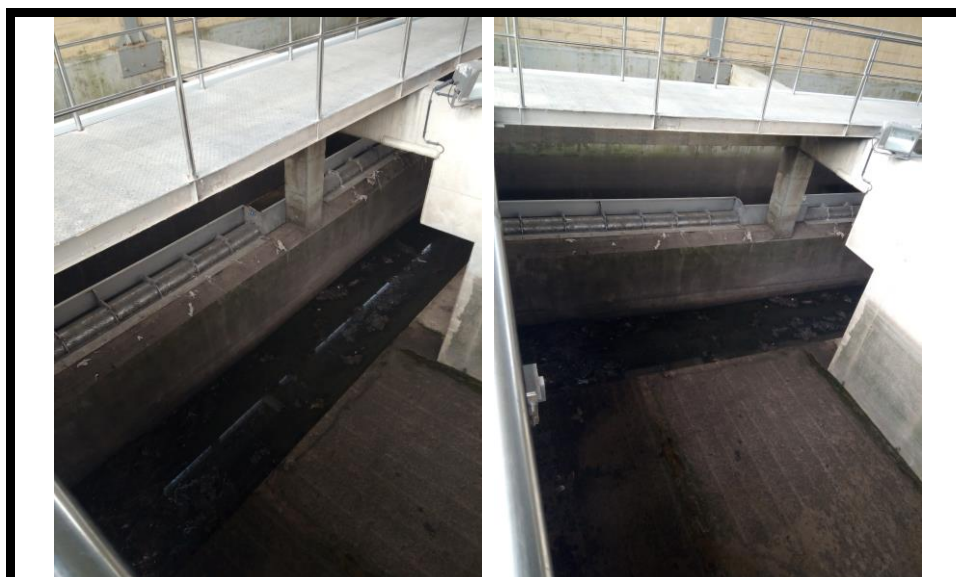
Tanque de Tormentas Fluyente Off-Line. Tamices rotativos en el Aliviadero Oviedo Norte (o Tanque de Tormentas Oviedo Norte) entre la Cámara central y las Cámaras de retención. Cortesía del Consorcio de Aguas de Asturias (CADASA). Gobierno del Principado de Asturias.
