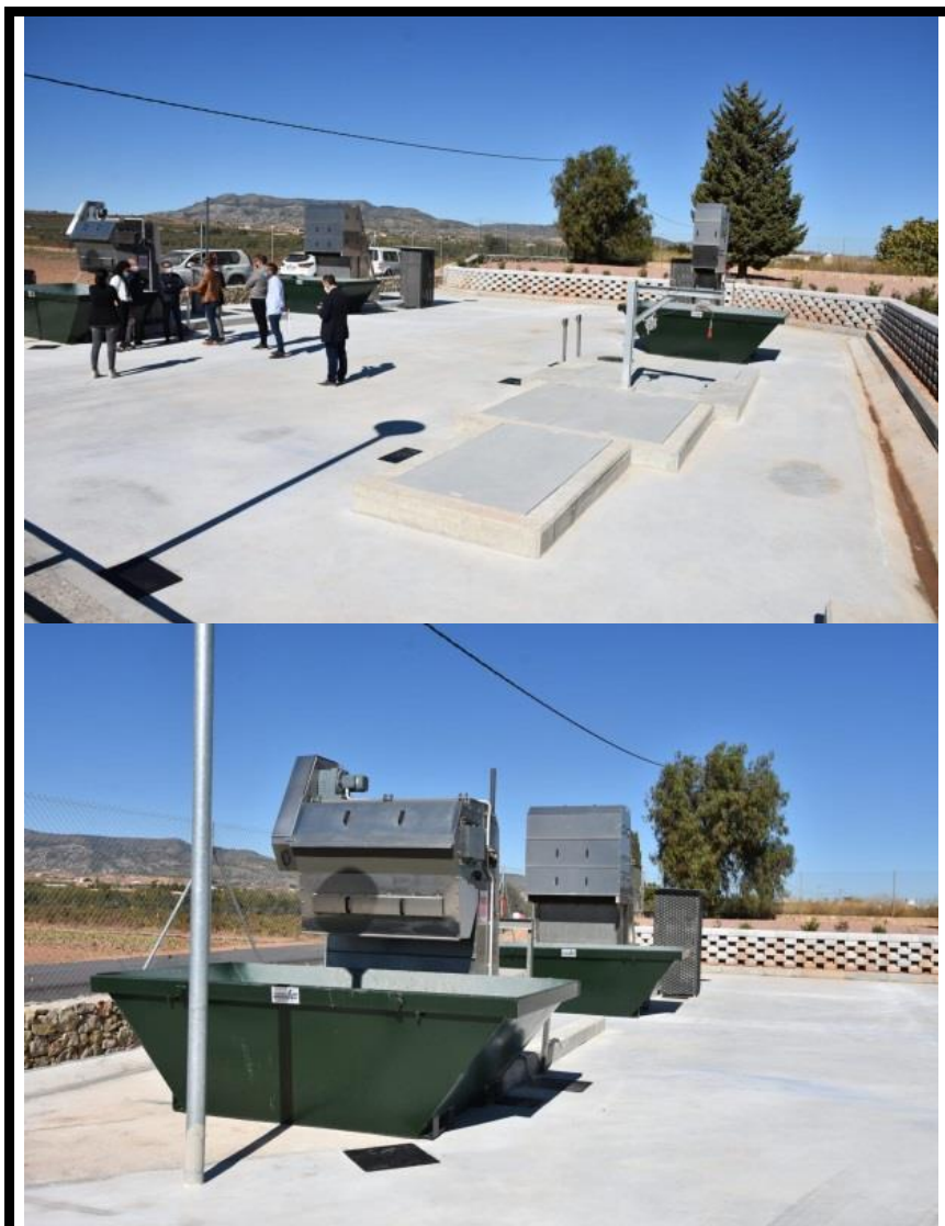
Planta de Pretratamiento de aguas pluviales en Pinoso (Alicante). Se ha desviado el colector de pluviales a la Planta de Pretratamiento donde se ha instalado un desbaste y una arqueta de sólidos donde se almacenará el residuo sólido, mientras que las aguas pluviales de escorrentía así tratadas serán devueltas al cauce del Rodrigillo. Octubre 2020. Cortesía del Ayuntamiento de Pinoso (Alicante).
