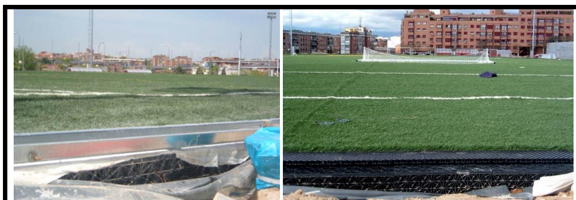
Celdas drenantes (o conductos planos) para drenaje horizontal. Polideportivo Marqués de Samaranch (Arganzuela – Madrid – España). Se utilizaron celdas drenantes de 30 mm bajo el terreno de juego para la captación y evacuación del agua de lluvia y riego a depósitos modulares perimetrales para su acumulación y posterior reciclado. Año 2006. Cortesía de «SUDS S.L - Atlantis».
