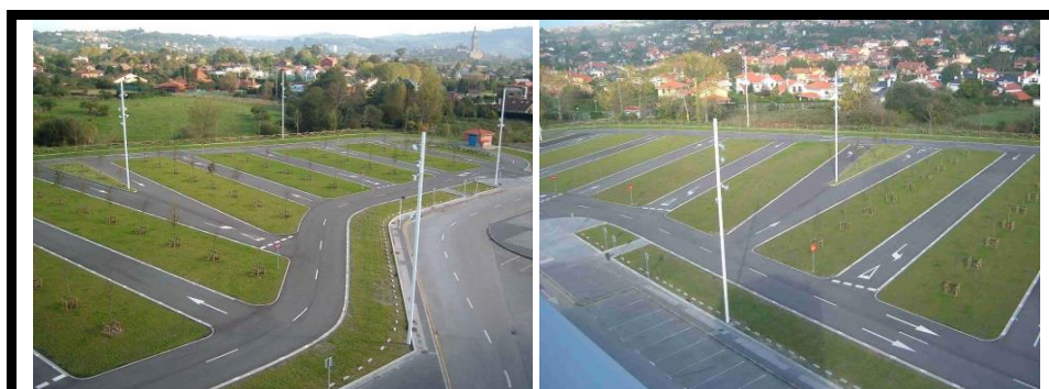
Ecoparking vegetado. Palacio de Deportes de La Guía - Presidente Adolfo Suárez (Gijón - Asturias). Las celdas drenantes rellenas con tierra y césped se utilizaron como zona de aparcamiento, consiguiendo una mejor integración medioambiental y paisajística. Cortesía de «SUDS S.L - Atlantis».
