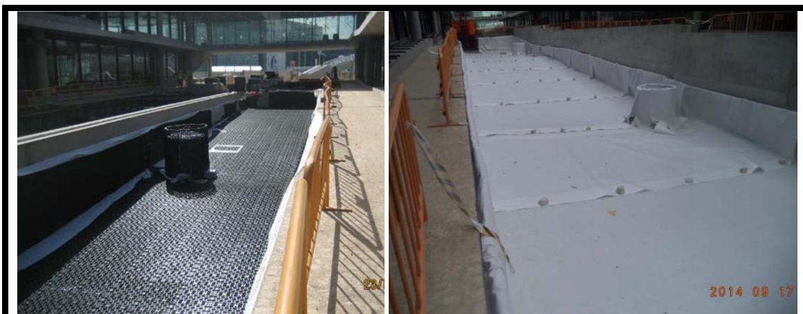
Celdas drenantes (drenaje horizontal) en Jardinera. Nueva Sede BBVA en el Barrio de Las Tablas Madrid (Fase I y Fase II). El agua se desplaza inferiormente por las celdas (creando un nivel freático en suspensión) y evitando filtraciones o humedades a la infraestructura inferior. Años 2013-2015. Cortesía de «SUDS S.L - Atlantis».
