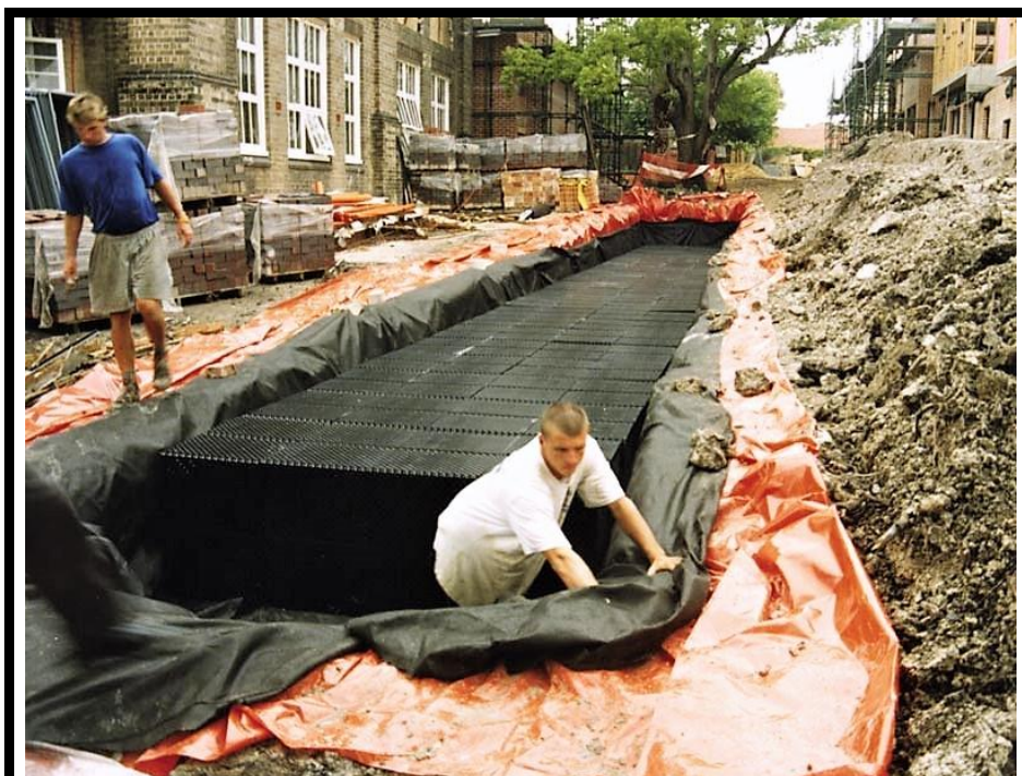
El agua previamente filtrada en los SUDS puede ser almacenada en depósitos. Depósito modular impermeable constituido con cajas drenantes de 450 mm y envuelto en geomembrana. Cortesía de «SUDS S.L. Atlantis».
