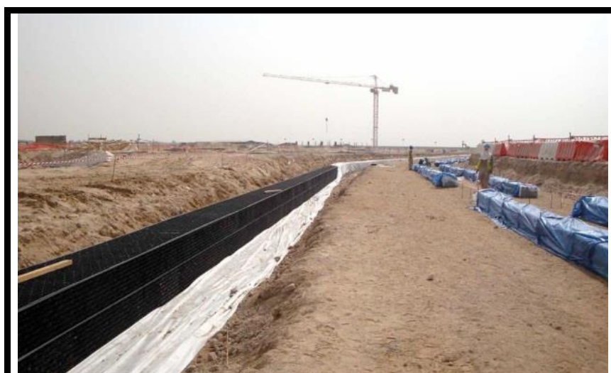
Canal permeable construido con cajas drenantes y envuelto en geotextil. Cortesía de «SUDS S.L - Atlantis».
