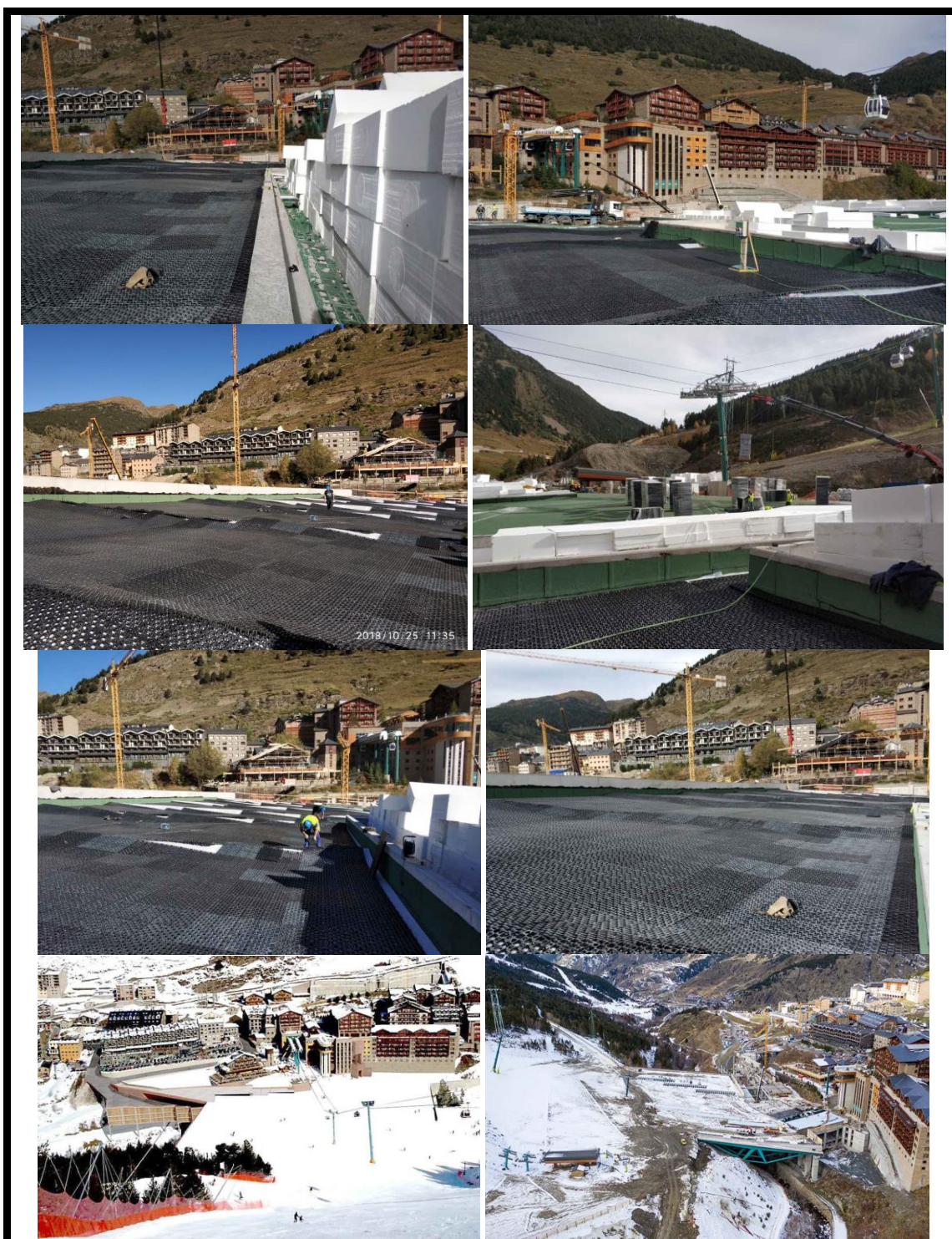
Drenaje horizontal. Plataforma esquiable de Soldeu (Andorra). Se utilizaron celdas drenantes de 52 mm para proteger la impermeabilización de la estructura y evacuar subsuperficialmente el agua de la nieve/lluvia. Año 2018. Cortesía de «SUDS S.L - Atlantis».
