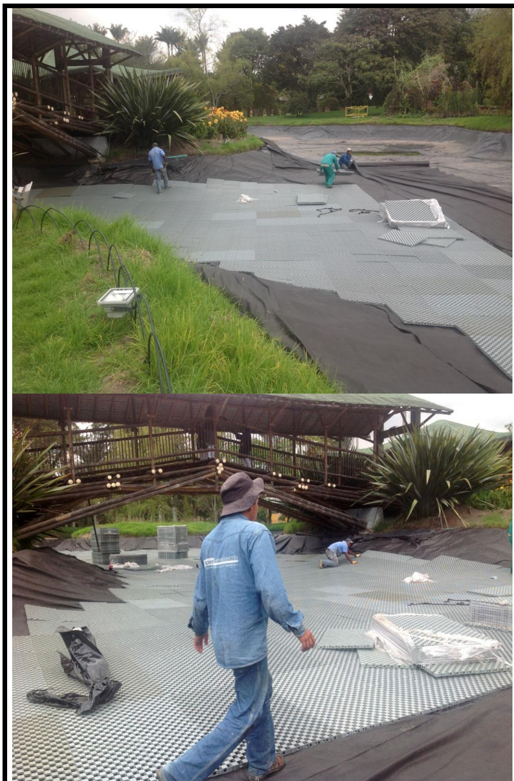
Humedal. Jardín Botánico de Bogotá José Celestino Mutis. Existían problemas de fugas en el humedal, se utilizó una geomembrana, celdas drenantes y cajas, y se rellenó con grava, creando montículos para una recirculación natural del agua. Cortesía de «SUDS S.L - Atlantis».
