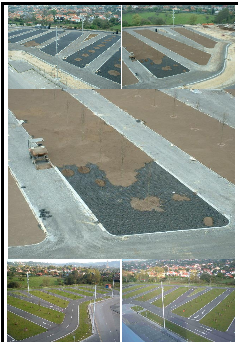
Ecoparking vegetado. Palacio de Deportes de La Guía - Presidente Adolfo Suárez (Gijón - Asturias). Las celdas drenantes rellenas con tierra y césped se utilizaron como zona de aparcamiento, consiguiendo una mejor integración medioambiental y paisajística. Cortesía de «SUDS S.L - Atlantis».
