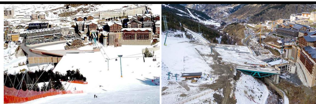
Drenaje horizontal. Plataforma esquiable de Soldeu (Andorra). Se utilizaron celdas drenantes de 52 mm para proteger la impermeabilización de la estructura y evacuar subsuperficialmente el agua de la nieve/lluvia. Año 2018. Cortesía de «SUDS S.L - Atlantis».
