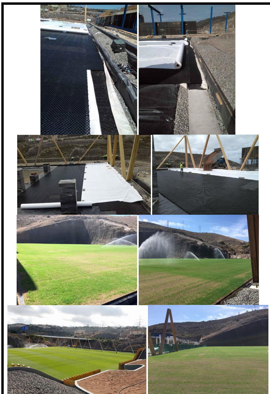
Drenaje horizontal en el nuevo complejo de la ciudad deportiva de la Unión Deportiva Las Palmas (España). Se utilizaron celdas drenantes de 30 mm bajo uno de los terrenos deportivos para la captación y canalización de las aguas pluviales, y depósitos modulares perimetrales para su acumulación y posterior reciclado. Años 2016-2017. Cortesía de «SUDS S.L - Atlantis».
