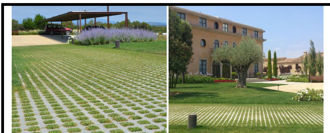
Pavimentos permeables (o drenantes). Pieza de 12 cm de espesor que crea una superficie de césped a la vez que soporta las cargas de vehículos. Aproximadamente el 40% del área de la pieza es área verde y el 60% distribuye las cargas a las capas inferiores. Ollers (Girona). Cortesía de Breinco.
