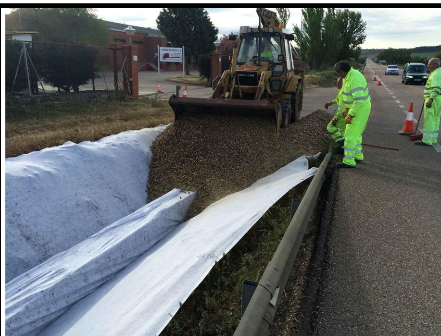
Ecocuneta constituida con cajas drenantes envueltas en geotextil. Medina de Rioseco (Valladolid). Cortesía de «SUDS S.L - Atlantis».
