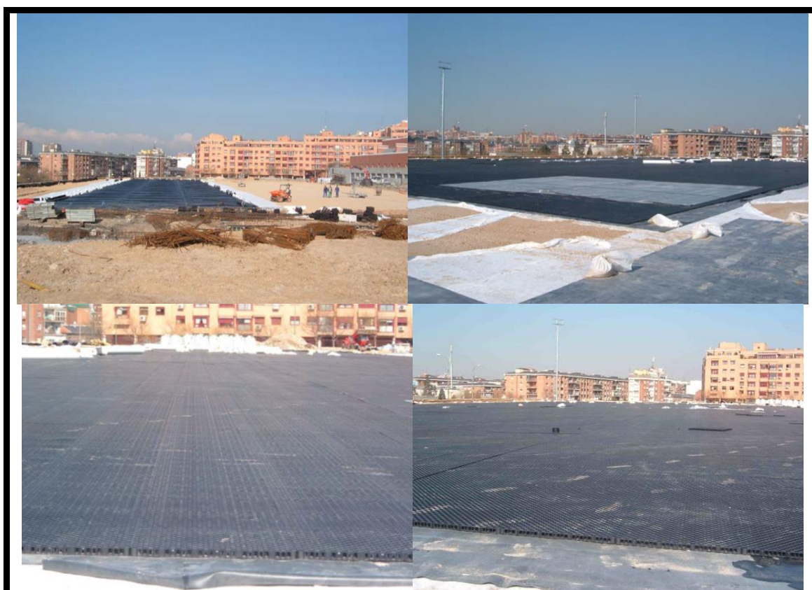
Celdas drenantes (o conductos planos) para drenaje horizontal. Polideportivo Marqués de Samaranch (Arganzuela – Madrid – España). Se utilizaron celdas drenantes de 30 mm bajo el terreno de juego para la captación y evacuación del agua de lluvia y riego a depósitos modulares perimetrales para su acumulación y posterior reciclado. Año 2006. Cortesía de «SUDS S.L - Atlantis».
