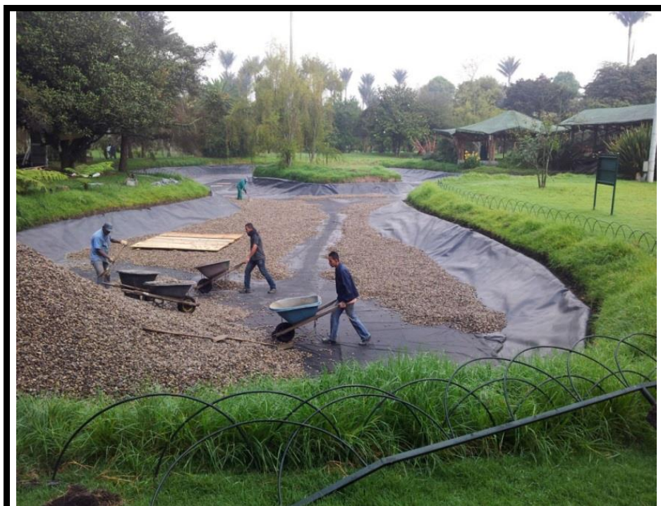
Humedal. Jardín Botánico de Bogotá José Celestino Mutis. Existían problemas de fugas en el humedal, se utilizó una geomembrana, celdas drenantes y cajas, y se rellenó con grava, creando montículos para una recirculación natural del agua. Cortesía de «SUDS S.L - Atlantis».
