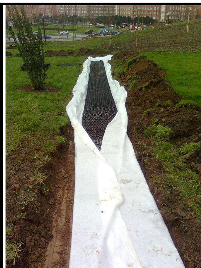
Canal permeable ejecutado con celdas drenantes de 52 mm (conductos planos) y envuelto en geotextil. Cortesía de «SUDS S.L - Atlantis».
