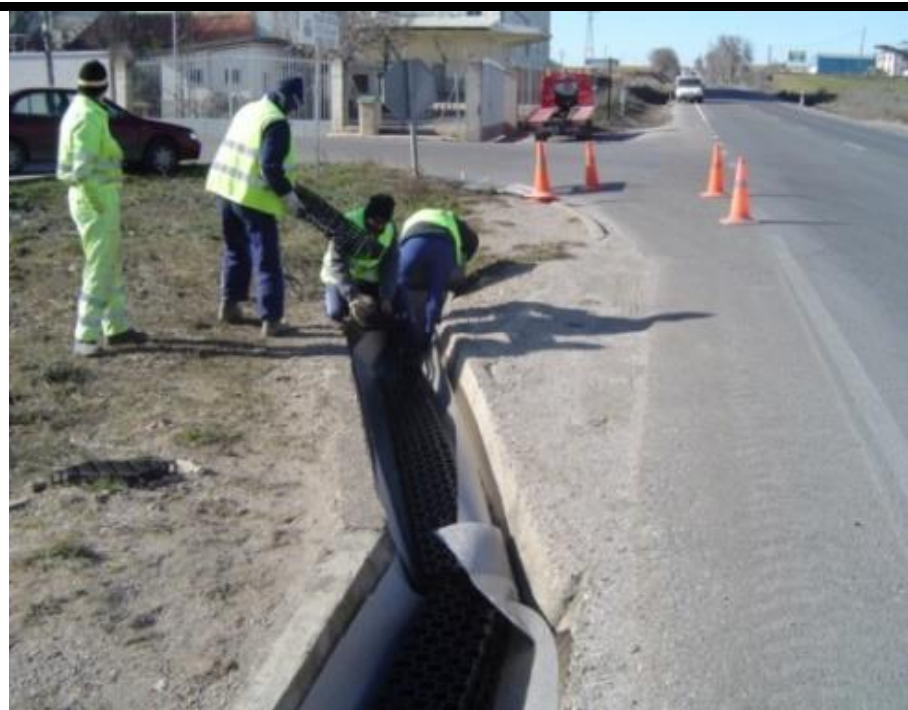
Ecocuneta reducida constituida con celdas drenantes de 52 mm envueltas en geotextil y cubiertas con gravilla. Medina de Rioseco (Valladolid). Cortesía de «SUDS S.L - Atlantis».
