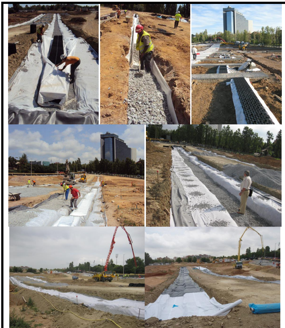
Riego pasivo por capilaridad. Parque de Can Rigaal en la Zona industrial portuaria de Barcelona (España). Creación de nuevos ecosistemas aprovechando el agua pluvial mediante riego pasivo por capilaridad. Año 2011. Cortesía de «SUDS S.L - Atlantis».
