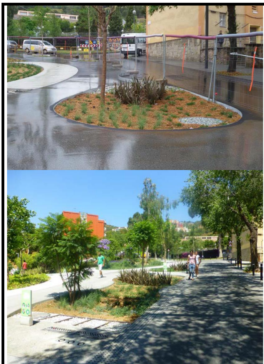
Jardín de lluvia. Transformación de un patio-aparcamiento en un parque en el Barrio Les Roquetes, Distrito Nou Barris (Barcelona). Bordillos enrasados para que el agua pluvial de escorrentía vierta a las zonas terrazas, y cuencos de retención (ondulaciones cóncavas que actúan como represas) o a las gravas que dirige el agua al Depósito de infiltración. Una vez se supera la capacidad de retención/infiltración el agua llega a los sumideros que conectan con el sistema de saneamiento. Año 2017. Cortesía de «SUDS S.L - Atlantis».
