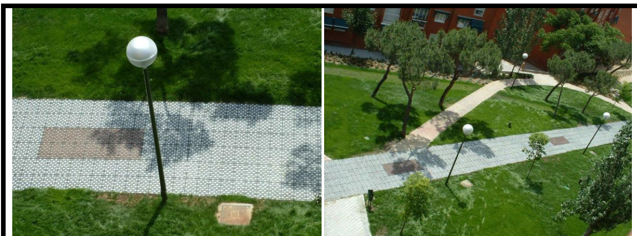
Parque Gómez Narro (Madrid). El pavimento permeable actúa de sumidero filtrante, interceptando las aguas laterales. Se crearon 10 depósitos de percolación (5 a cada margen del camino) con una capacidad de almacenamiento total de 100 m 3 . Mayo de 2003. Cortesía de «SUDS S.L - Atlantis».
