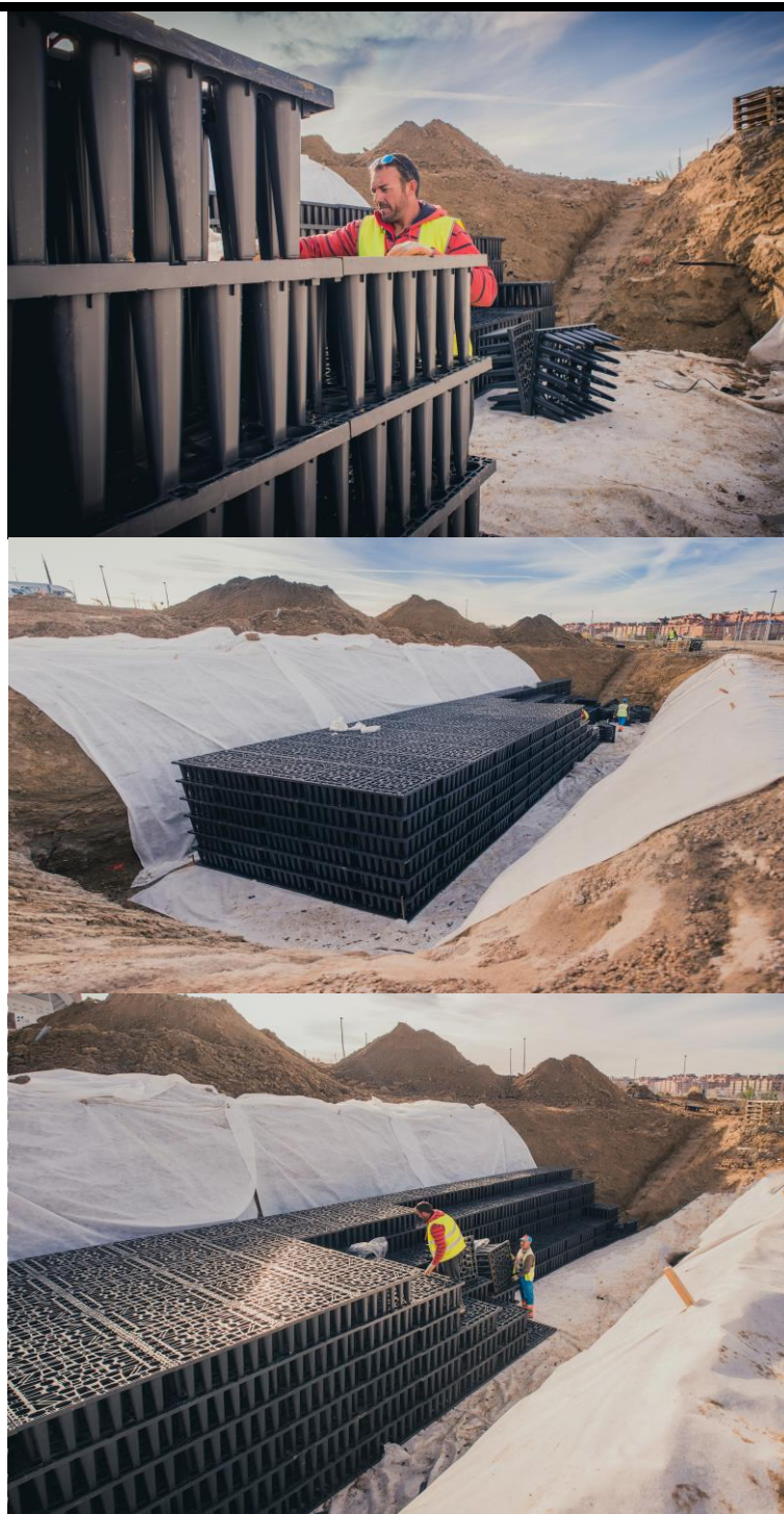
El agua previamente filtrada en los SUDS puede ser almacenada en depósitos. Depósito de infiltración de 145 m 3 de capacidad, equipado con 624 bloques Ecobloc Maxx, Arquetas Vario 800 Flex y cubierta peatonal. Parque Olímpico de Madrid - Estadio Wanda Metropolitano. Noviembre de 2018. Cortesía de GRAF Iberica.
