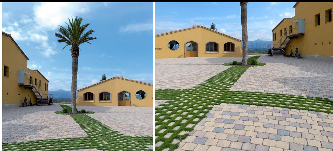
Pavimentos permeables (o drenantes): Adoquín Juntas Verdes. El adoquín con junta verde acumula el agua de lluvia y deja que se vuelva a evaporar. Aproximadamente el 25% del área es junta verde y el 75% es adoquín. Masquefa (Barcelona). Cortesía de Breinco.
