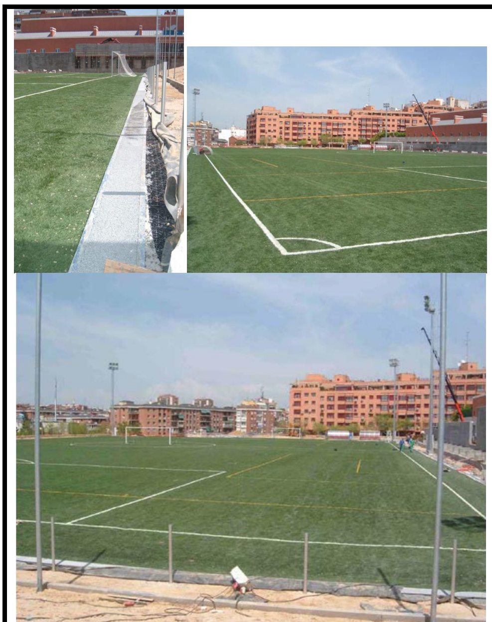
Celdas drenantes (o conductos planos) para drenaje horizontal. Polideportivo Marqués de Samaranch (Arganzuela – Madrid – España). Se utilizaron celdas drenantes de 30 mm bajo el terreno de juego para la captación y evacuación del agua de lluvia y riego a depósitos modulares perimetrales para su acumulación y posterior reciclado. Año 2006. Cortesía de «SUDS S.L - Atlantis».
