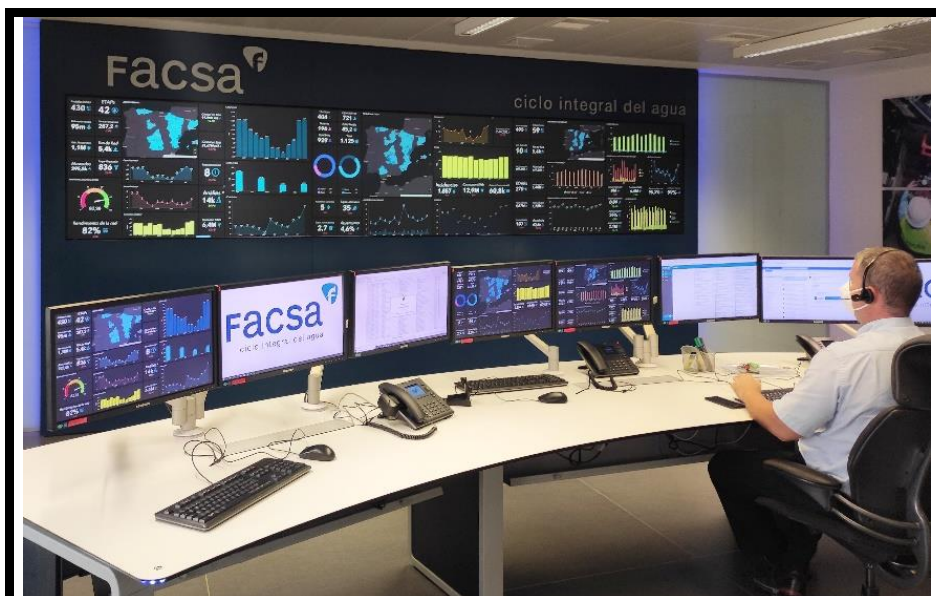
Centro de control. Fuente: Facsá.
