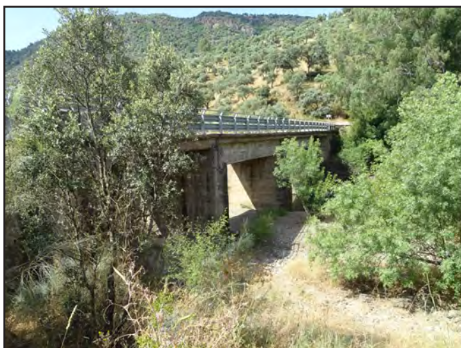
Foto 12. Puente de la carretera CO-6413 sobre el río Cuzna, aguas arriba de la confluencia del río Gato
