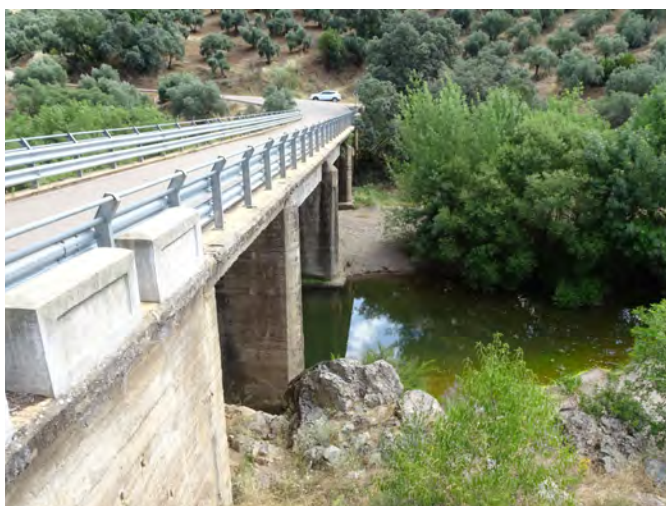
Foto 17. Puente de la carretera A-3175 sobre el río Cuzna, aguas abajo del río Gato.
