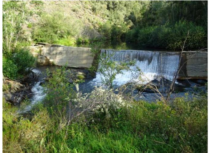
Foto 8. Azud situado en el límite inferior del tramo medio, con canal de derivación en la margen derecha
