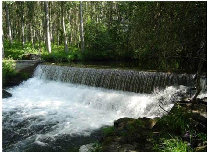
Foto 10. Azud situado en el tramo bajo del río (R. Ancares III), con canal de derivación para riego de las choperas y pastos de las márgenes
