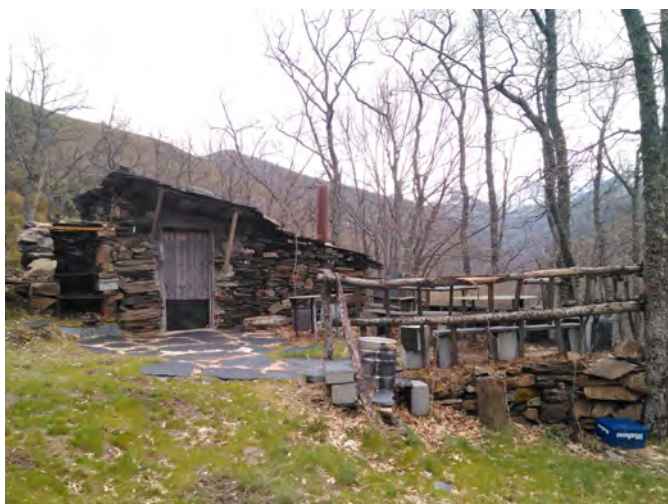
Foto 7. Casa de los maquis; junto a la ermita, únicas construcciones en las proximidades de la reserva.
