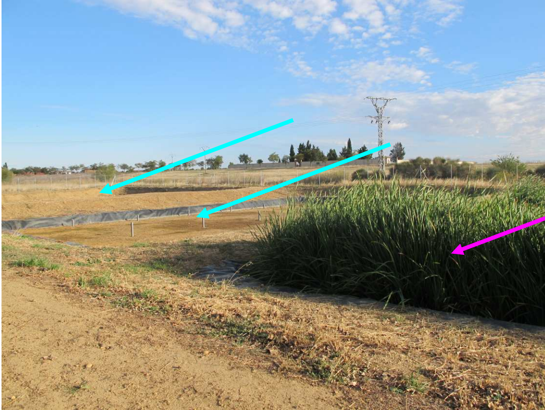
Foto 4: Vista general de la depuradora de Tardajos - Rabé de la Calzadas (Burgos): en primer término (color turquesa) humedales de flujos subsuperficial vertical y al fondo (color fucsia) macrófitas en flotación.
