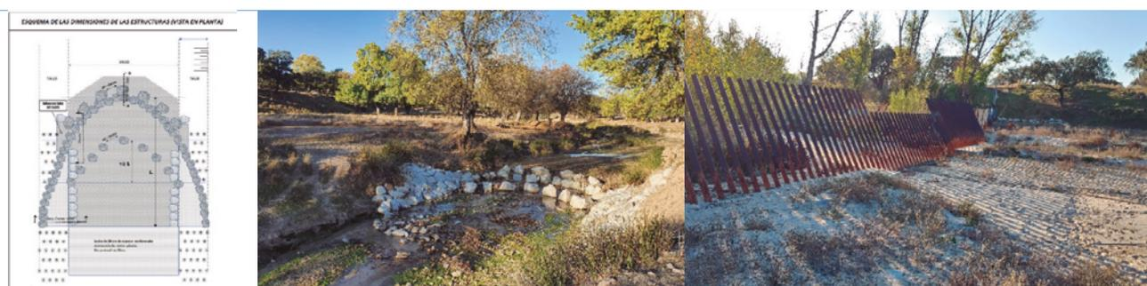
Figura A.4.8.3 Actuaciones de protección de la erosión (a) esquema de la hidrotecnia tipo cross vane en planta, (b) localización de la hidrotecnia en una sección del cauce y (c) peine retenedor de sedimentos en el tramo final del arroyo de la Trofa.
