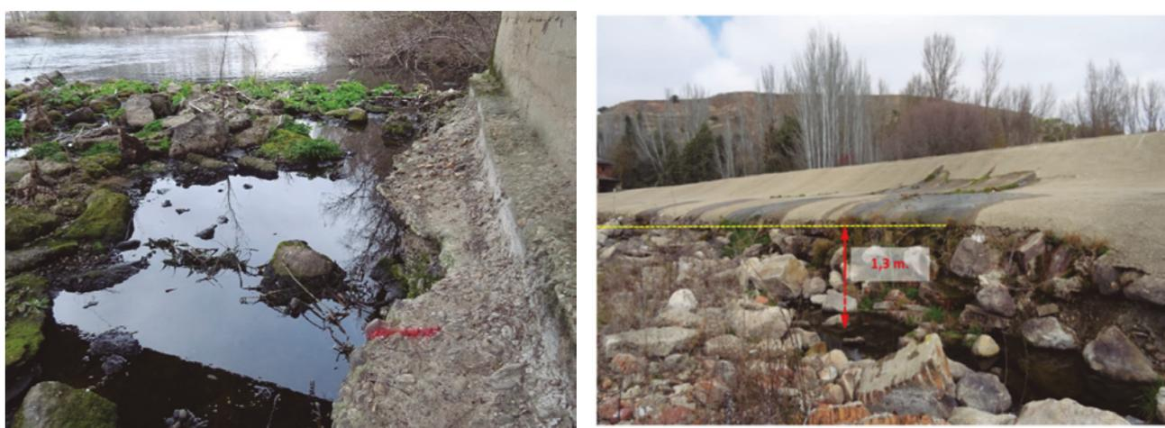
Figura A.4.4.2 Fenómenos de erosión local en dos puntos del tramo medio del río Tormes. (a) Base del pilar derecho del puente viejo de Encinas de abajo y (b) Azud de la Flecha.
