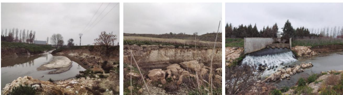
Figura A.4.10.2 (a) Fenómenos de erosión activa del cauce, (b) pérdida de sedimento y colapso de taludes y (c) descalce de infraestructuras, salida de la EDAR Arroyo Culebro Cuenca Baja.
