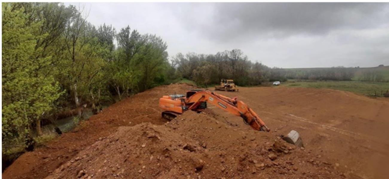
Figura A.4.3.4. Trabajos de eliminación de una mota en la margen derecha del río Sequillo en Belver de los Montes (Zamora). Todo el material fue vertido al río definido por la hilera de chopos. Fuente. CHD.
