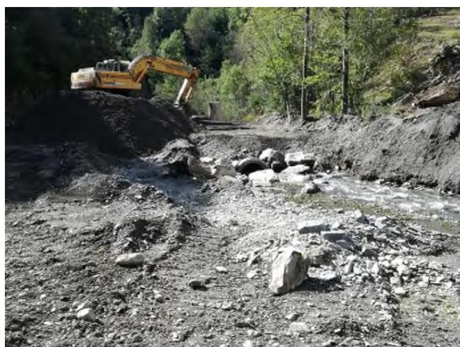
Figura A.2.4.2 (a) Trabajos de demolición de la presa y del antiguo desarenador y retirada parcial del sedimento retenido en el vaso del azud; (b) Trabajos de retirada de sedimento anóxico en la zona de presa mediante excavadora. Fuente: ACA.
