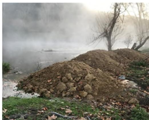
Figura A.2.10.2 (a) Acopio de los sedimentos a inyectar en el río Llobregat y (b) disposición de los cordones de sedimento paralelos a la orilla del río Ter. Fuente: ACA.
