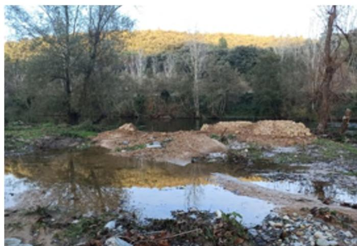
Figura. A.2.10.3. (a) Imagen de los cordones de sedimento durante la crecida (b) y tras su paso. Únicamente, un tercio del total del sedimento dispuesto en forma de cordones en la margen derecha del río Ter fue movilizado por la crecida. Fuente: ACA.
