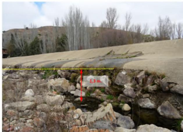
Figura A.4.4.2 Fenómenos de erosión local en dos puntos del tramo medio del río Tormes. (a) Base del pilar derecho del puente viejo de Encinas de abajo y (b) Azud de la Flecha.
