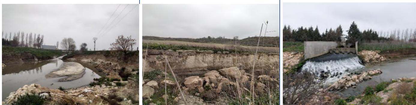
Figura A.4.10.2 (a) Fenómenos de erosión activa del cauce, (b) pérdida de sedimento y colapso de taludes y (c) descalce de infraestructuras, salida de la EDAR Arroyo Culebro Cuenca Baja.
