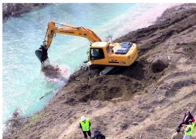
Figura A.2.2.2 (a) Eliminación de obras de defensa frente a inundaciones para reconectar el lecho del río y las llanuras de inundación en los espacios de la Red Natura2000; (b) Eliminación de diques y reintroducción de sedimentos; en algunos casos, realizada por los mismos operadores que hace décadas habían dragado el río y construido las obras de defensa. Fuente: Gobierno de Navarra y MN Consultores.
