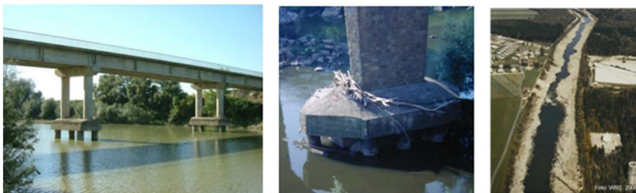
Figura 2.1. Erosión excesiva del lecho del río (a) y (b) que socava las estructuras; y (c) que incide en el lecho del río y provoca su ruptura (fuentes: (a) Fernando Magdaleno Mas; (b) Hervé Piegay; (c) Habersack & Piegay, 2007).
