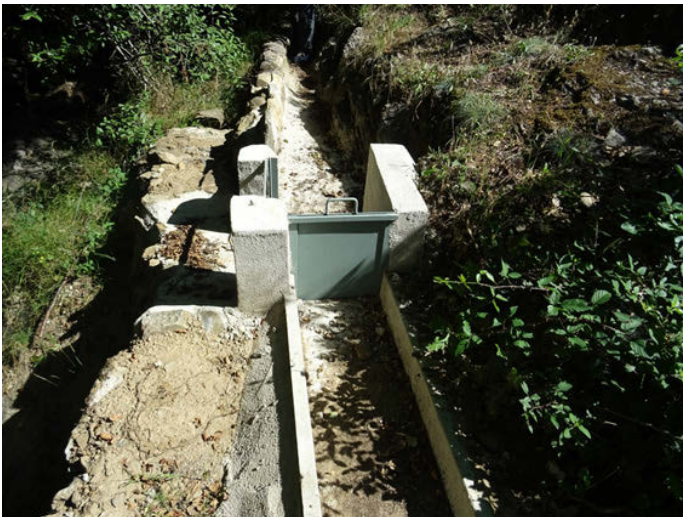
Foto 9: Tramo alto Río Puebla (Zona 2). Azud con acequia remodelada.
