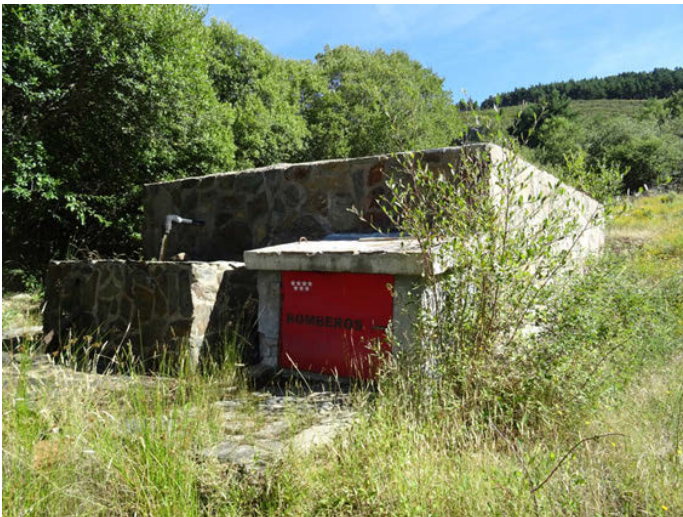
Foto 3: Tramo alto Río Riato (Zona1). Deposito bomberos
