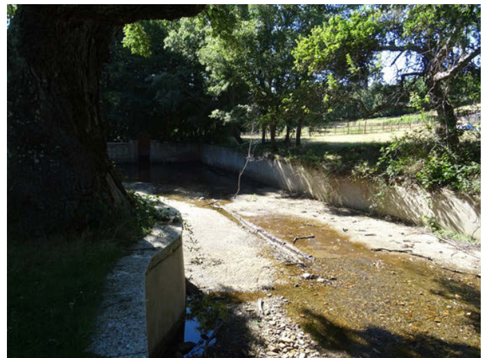
Foto 6: Tramo alto Río Puebla (Zona 2). Piscina en el cauce.
