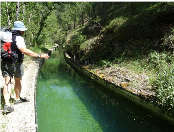
Foto 11. Canal de derivación de la central hidroeléctrica en la reserva
