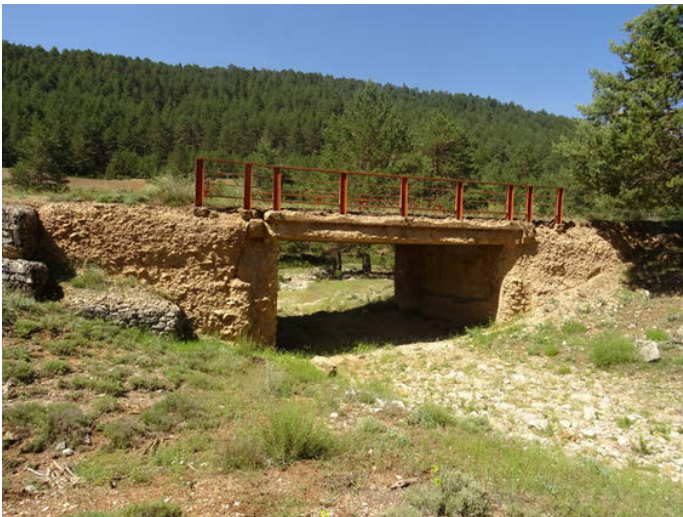
Foto 3: Puente de la pista forestal GU-982
