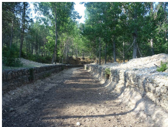
Foto 10: Encauzamiento para prevenir inundaciones en el Arroyo de las Truchas cerca de su unión al río Escabas
