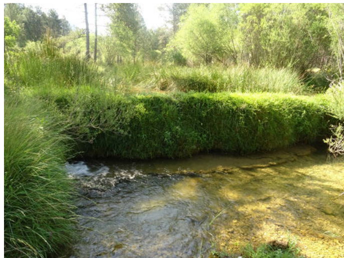
Foto 8: Azud en Río Escabas en el interior del Parque del Hosquillo
