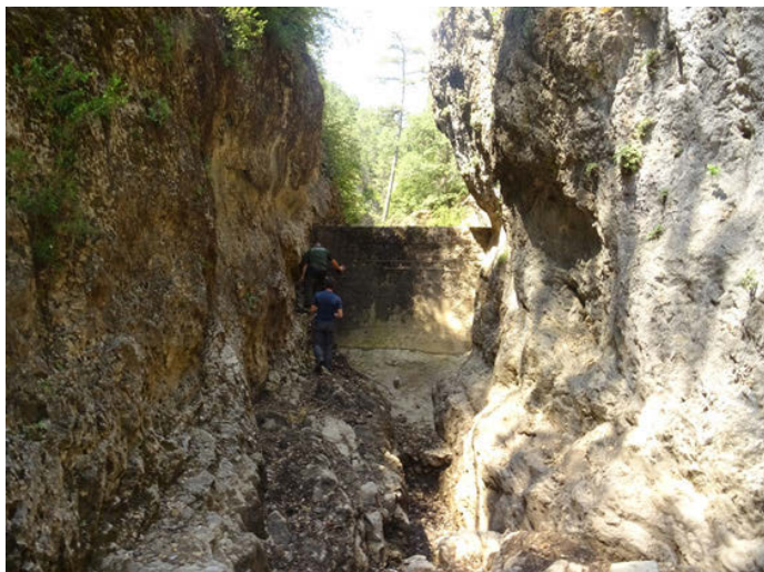
Foto 7: Azud en arroyo de las Truchas para control de inundaciones
