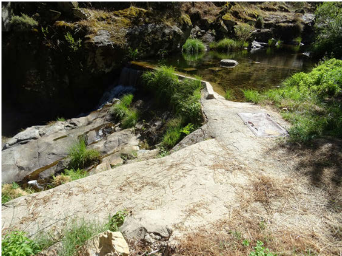
Foto 7. Azud para la toma de agua de abastecimiento de Poyales del Hoyo en la zona 1 de la reserva
