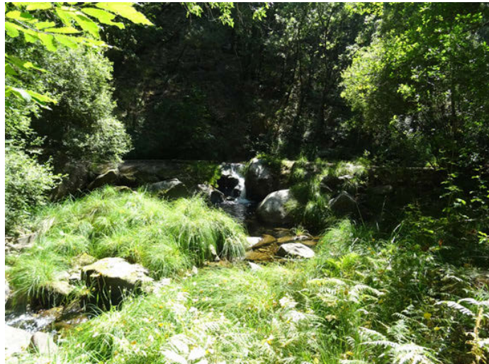
Foto 8. Azud roto aguas arriba del campamento
