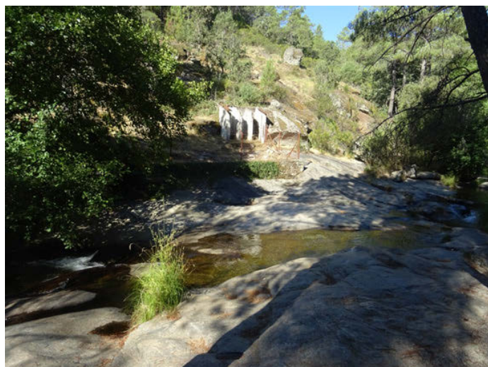
Foto 12. Muro ocupando el DPH en la zona de chiringuitos
