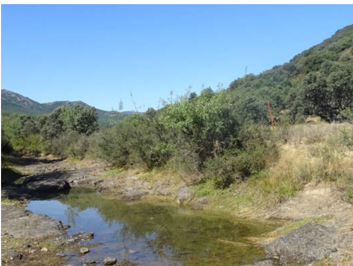
Foto17: Alambrada paralela y próxima al cauce del río Montoro situada en la margen izquierda, unos 200m aguas arriba de Ventillas.
