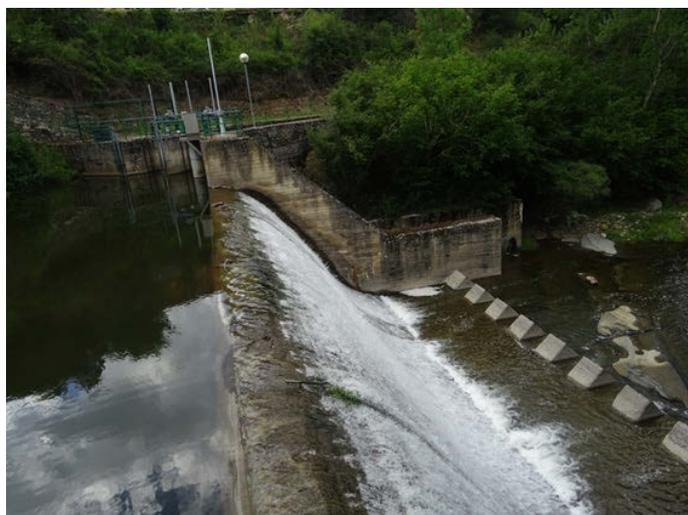
Foto 10. Azud del canal de trasvase al Embalse de Ortigosa, coincidente con el fin de la RNF.
