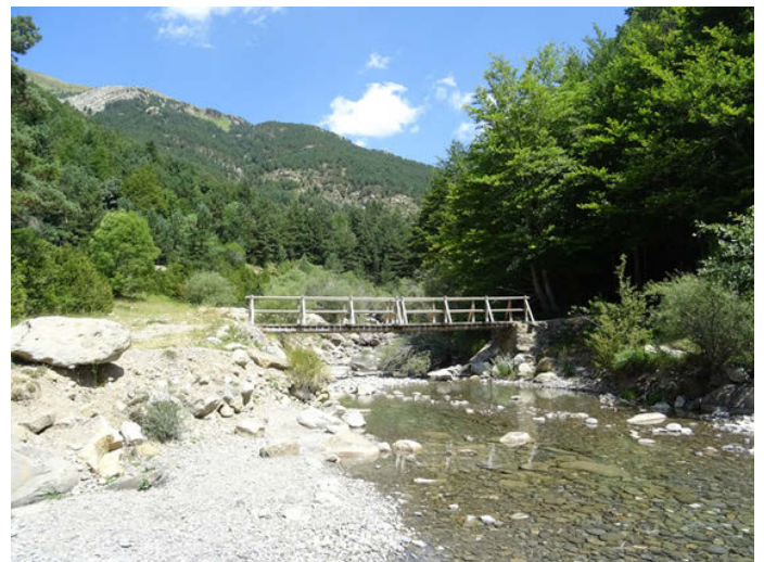
Foto 6. Pasarela localizada en la zona 2.
