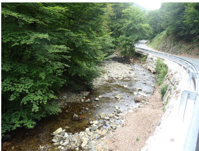
Foto 8. Escollera de protección de la carretera N-138 coincidente con el fin de la Reserva Natural Fluvial.
