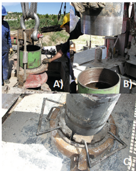
Figura 7.3.10. Operación de descenso de una tubería metálica unida mediante rosca. Autor: Juan Antonio Hernández Bravo
