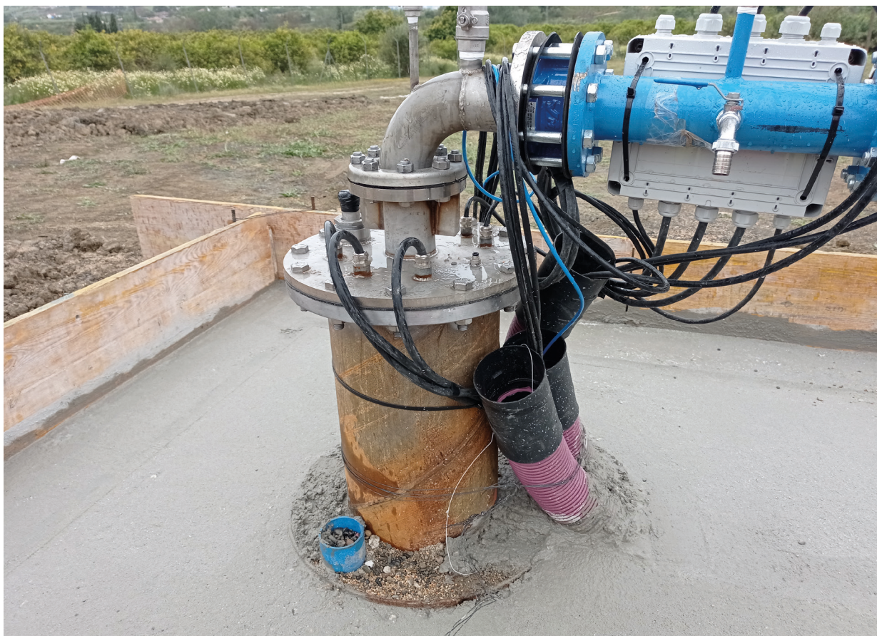
Figura 7.7.4. Cierre estanco con placa de anclaje unida a la tubería de emboquilla del sondeo con brida y tornillería. Elevación de seguridad de 60 cm sobre la cota del suelo. Fuente: AQUATEC.
