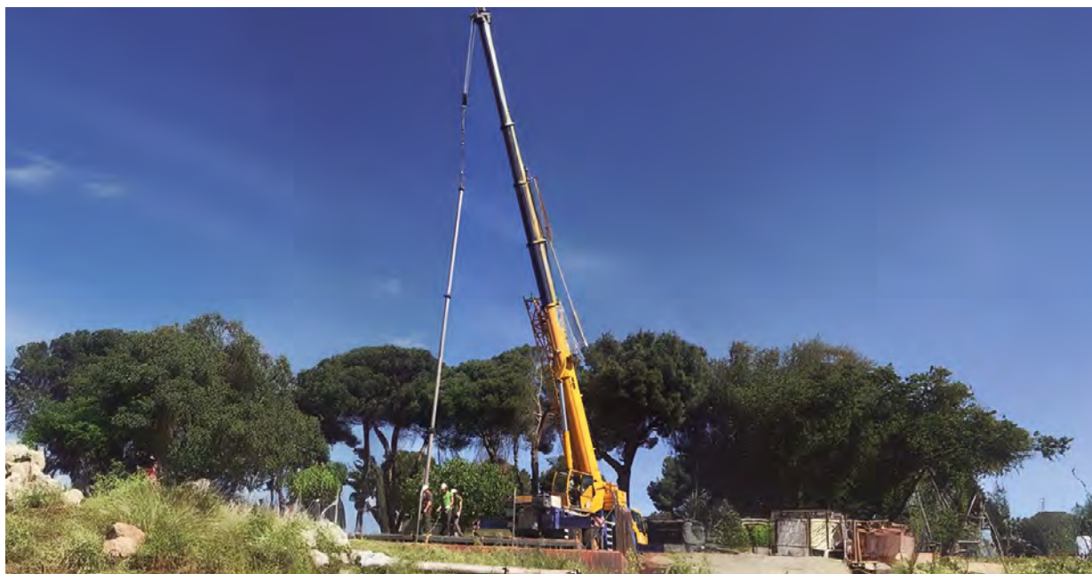
Figura 7 - Extracción de la tubería de impulsión de un pozo. Autora: Esther Sánchez.
