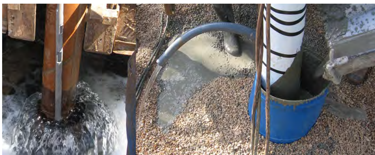
Figura 16. Labores de cementación en sondeo surgente. Autor: Gabriel Gallardo
