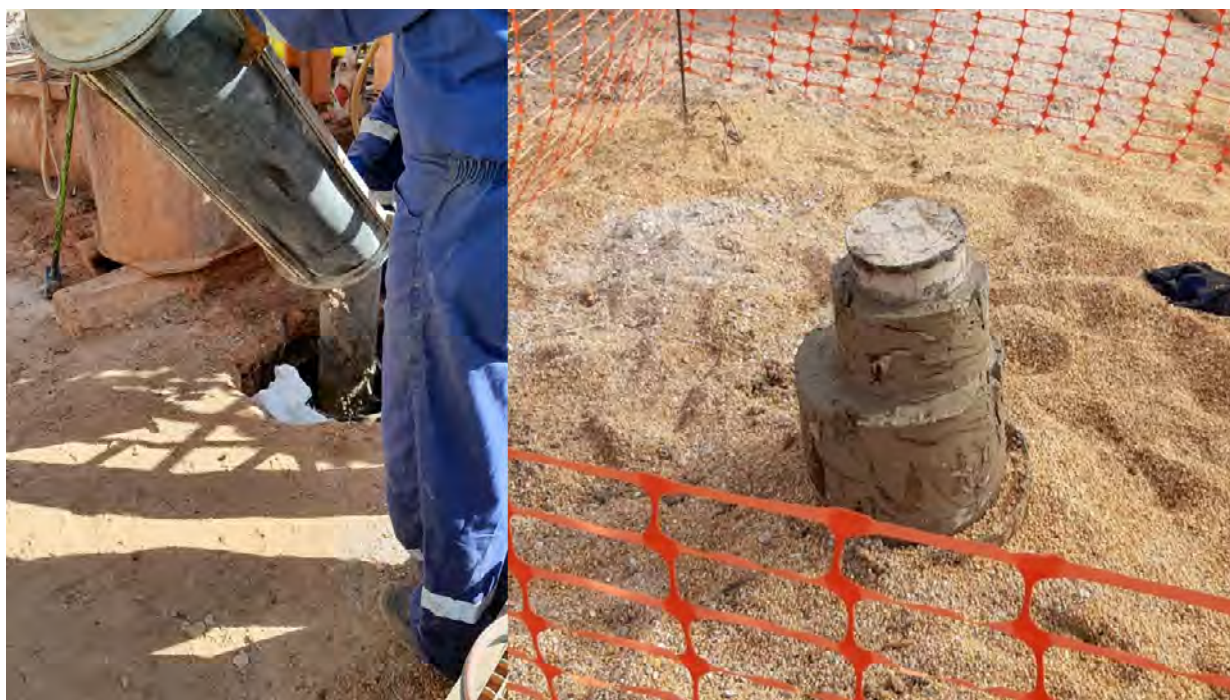
Figura 3. Cementación en anular de sondeo Autor: Javier Serrano
