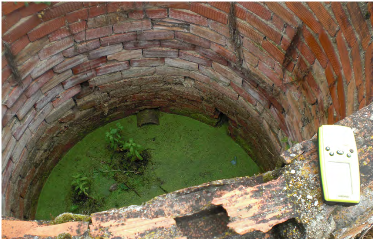
Figura 19. Pozo excavado abierto de gran diámetro. Autores: José Luis Barroso y Marc Martínez
