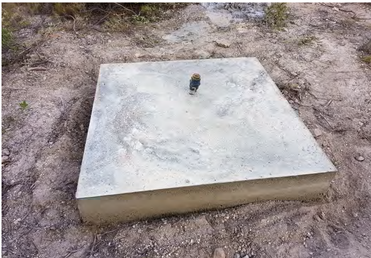
Figura 2. Losa de hormigón para la clausura temporal de un sondeo, con un acceso que permite medir el nivel piezométrico.
