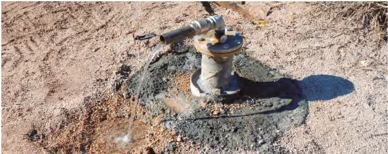
Figura 14.- Detalle de la cementación y el cierre de un pozo surgente.
