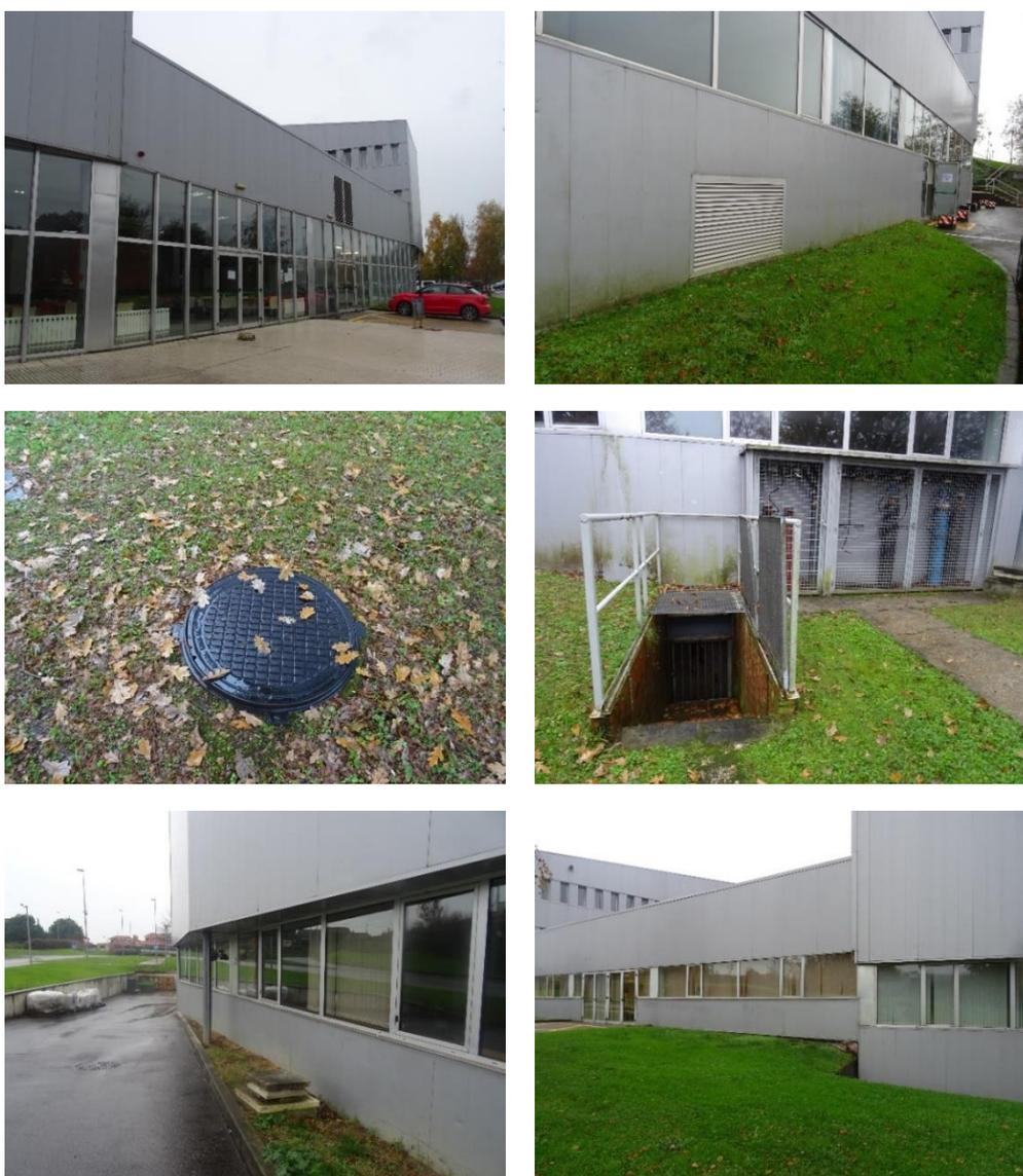
Fig. 22: EPI Gijón: principales puntos de entrada de agua desde el exterior.
