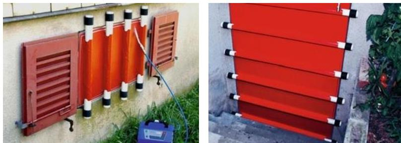
Fig. 43: Ejemplos de sellado temporal. Flood proofing in urban areas. 2019.
