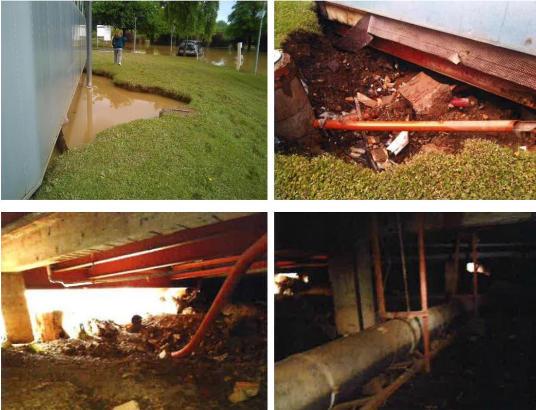
Fig. 23: Daños en cámara bajo forjado sanitario tras la inundación en junio de 2018. Universidad de Oviedo.
