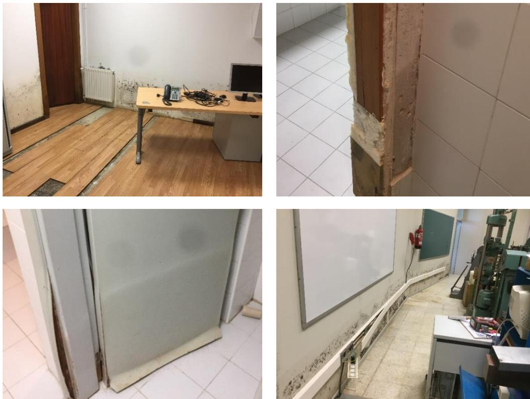
Fig. 25: Daños en pavimentos, paramentos, puertas e instalaciones tras la inundación en junio de 2018. Universidad de Oviedo.
