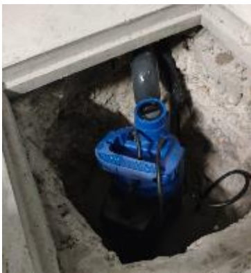
Colocación de bomba de achique.
