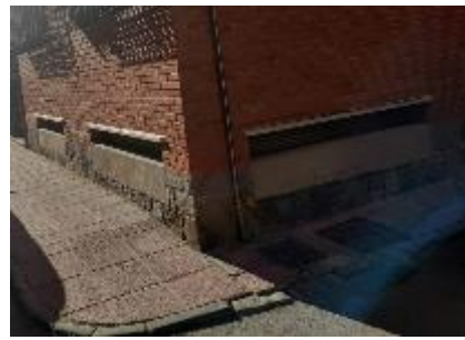
Muro en ventanas garaje
