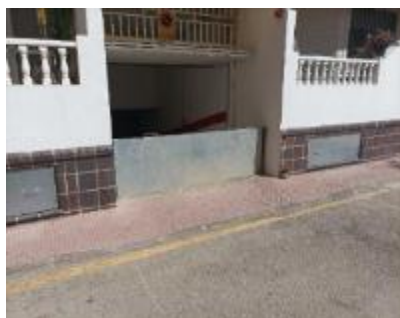
Barreras en puertas y ventanas garaje.
