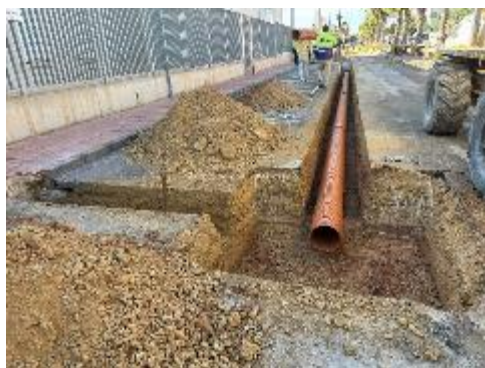
Detalle de la construcción de las líneas independientes de sumideros de evacuación de aguas pluviales
