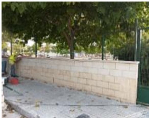
Demolición de albardilla prefabricada.
