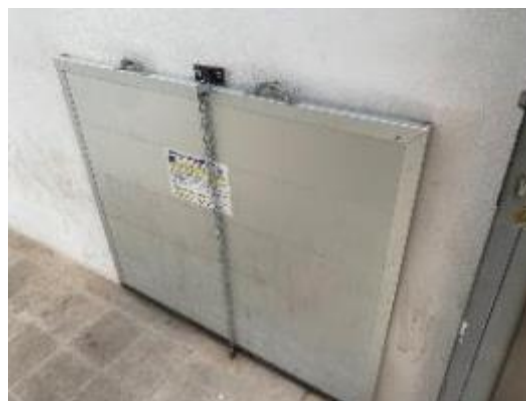
Detalle de barreras anti-inundación instaladas en puertas, acceso a parking para personas y vehículos y en rejillas de ventilación del edificio.
