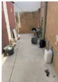
Solera de hormigón.
