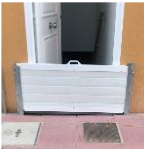
Colocación de barreras temporales
