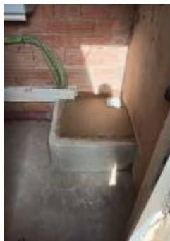
Hormigonado de zapatas y placas de anclaje.
