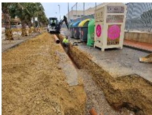
Detalle de la construcción de las líneas independientes de sumideros de evacuación de aguas pluviales
