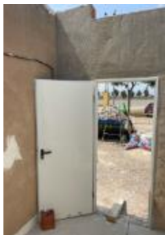
Sustitución de puertas.
