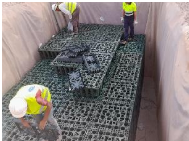
Detalle de la construcción del sistema de drenaje sostenible
