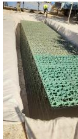
Detalle de la construcción del sistema de drenaje sostenible
