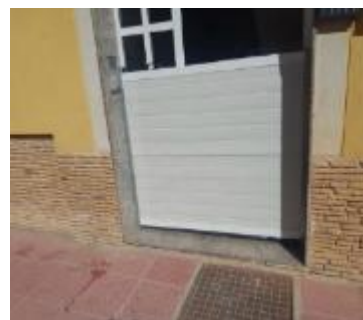
Compuerta acceso a escalera del edificio.
