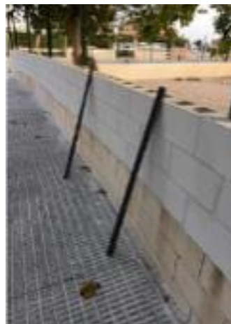
Desmontaje de valla metálica.
