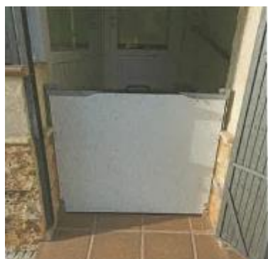
Colocación de barreras temporales
