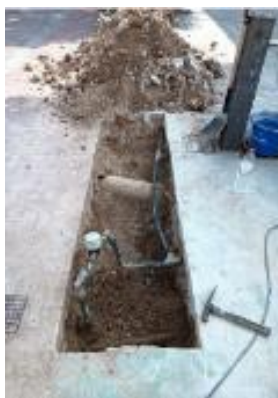
Excavación de zanjas y pozos.
