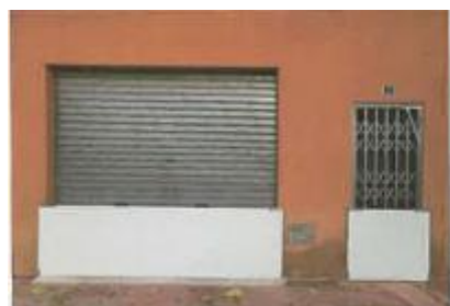
Colocación de barreras temporales
