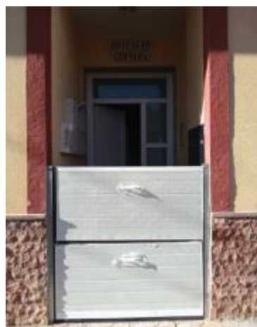
Puerta de acceso al edificio con paneles de protección.
