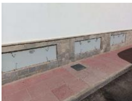
Barreras ejecutadas en ventanas de garaje.
