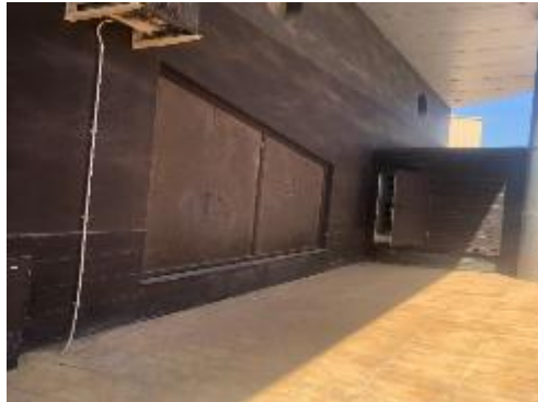
Pintura impermeabilizante, chapa fenólica y sellado carpintería metálica
