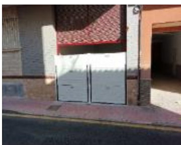
Barrera en puerta de garaje. Calle Isidoro.
