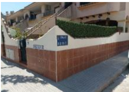
Revestimiento impermeable en muro perimetral.
