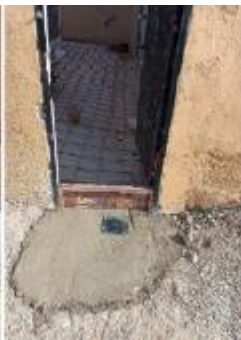
Hormigonado de zapatas y placas de anclaje.
