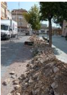
Demolición de muro vallado.
