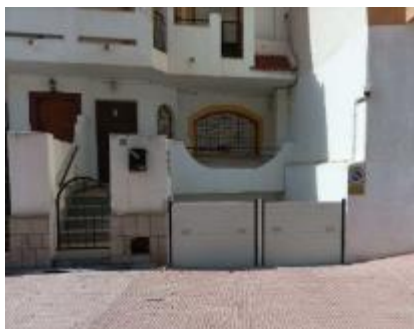
Barrera en puerta de garaje. Avenida Fernando Muñoz Zambudio.
