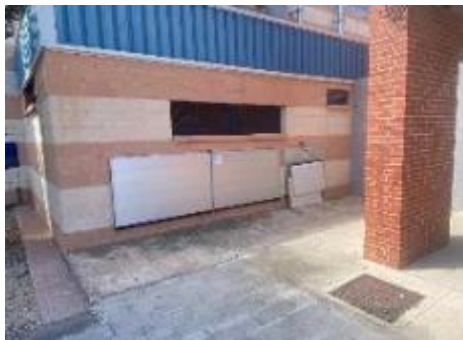
Detalle de barreras anti-inundaciones instaladas en puertas de acceso a la biblioteca. Detalle de las barreras instaladas en la pared lateral para su instalación en puertas y accesos si hay una emergencia
