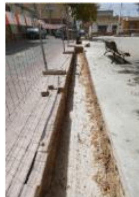
Vertido de hormigón de limpieza en zapata de cimentación.
