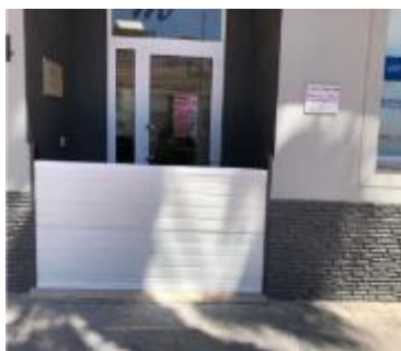
Compuerta acceso a local de planta baja.
