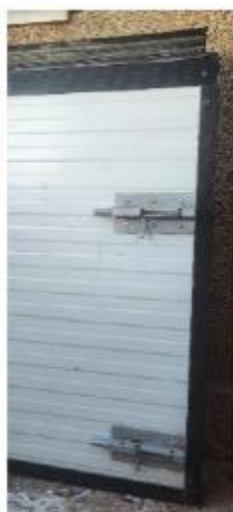
Colocación de barreras temporales. Detalle anclaje a jambas
