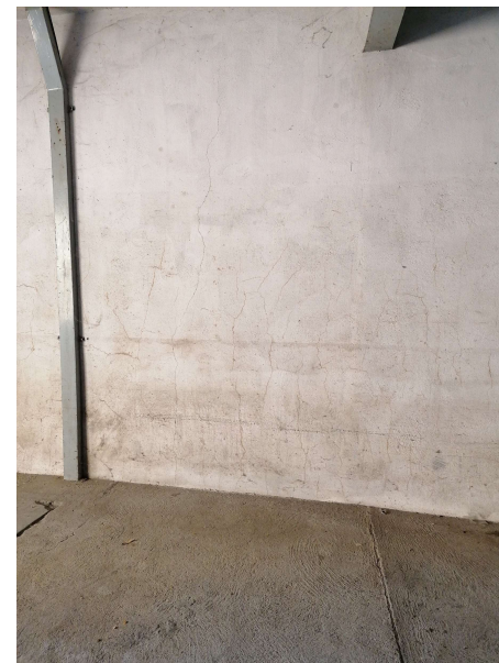
Detalle de la marca de agua en las paredes del garaje.
