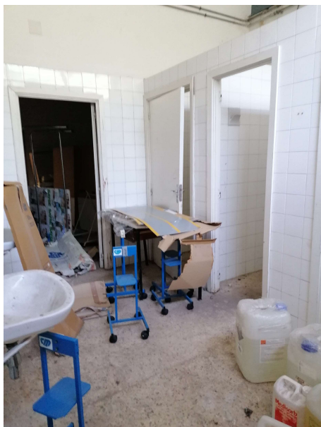
Baños utilizados como almacén en la planta semisótano.
