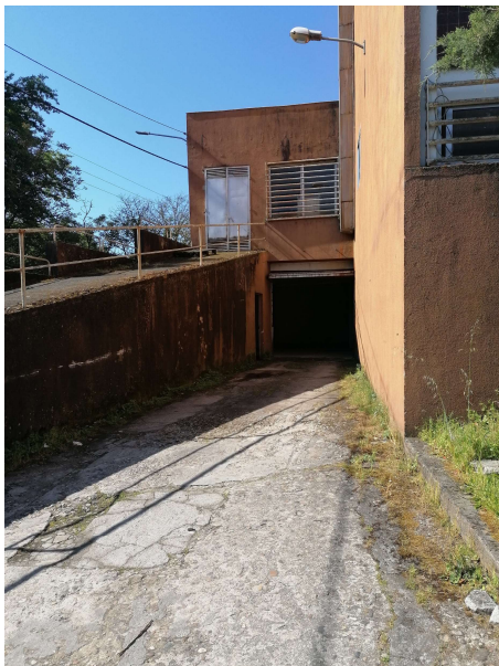
Rampa acceso al garaje en la planta semisótano.
