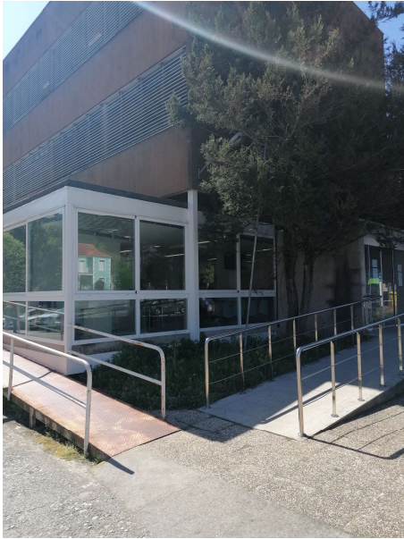
Rampas acceso a la Tesorería General de la Seguridad Social. Orientación NO
