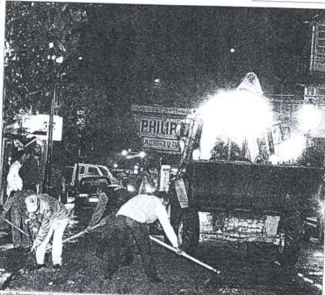
La calle Progreso quedó convertida en un barrizal tras la tormenta.
