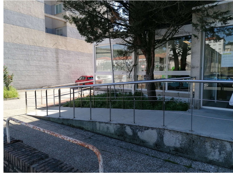
Rampa de acceso en la fachada en orientación NO.
