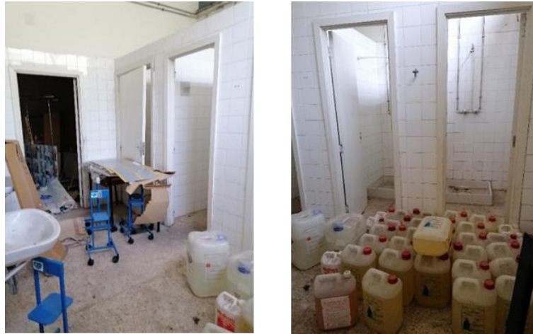
Figura 49. Punto de entrada de agua a través del saneamiento
