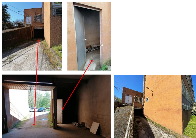
Figura 27. Portón y puerta de acceso al garaje, ubicado en la esquina SE del centro de salud
