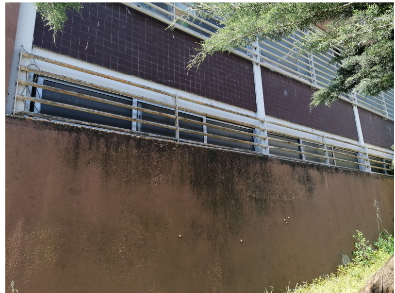
Ventanales en la esquina SE del edificio.
