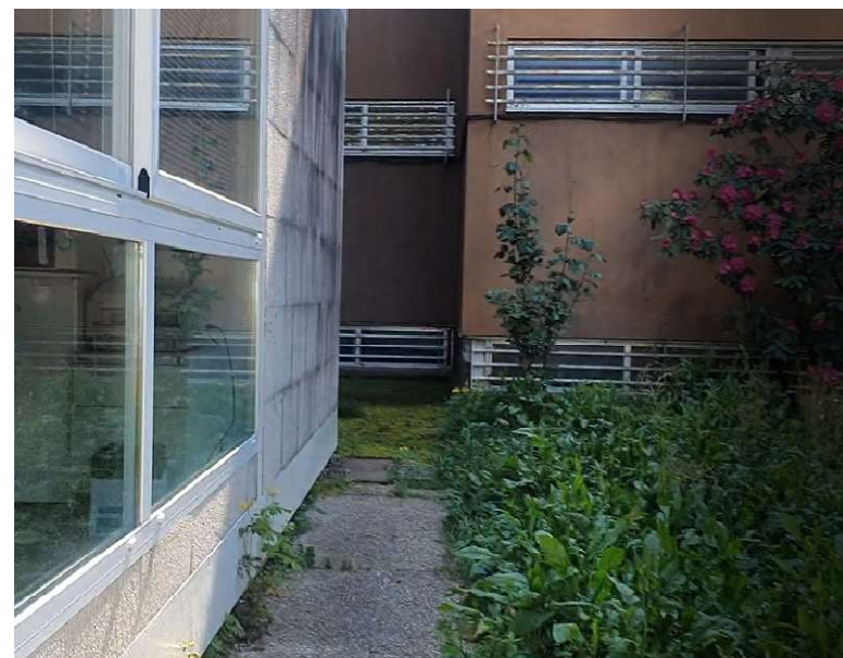
Ventanas en fachada NO de la instalación.
