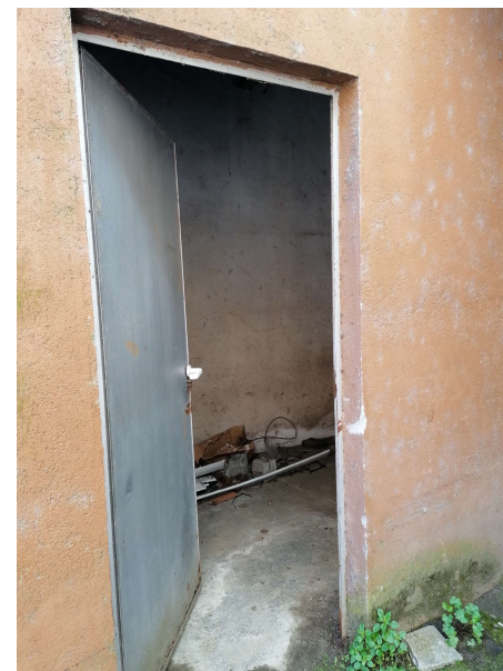
Acceso peatonal al garaje de la planta semisótano.
