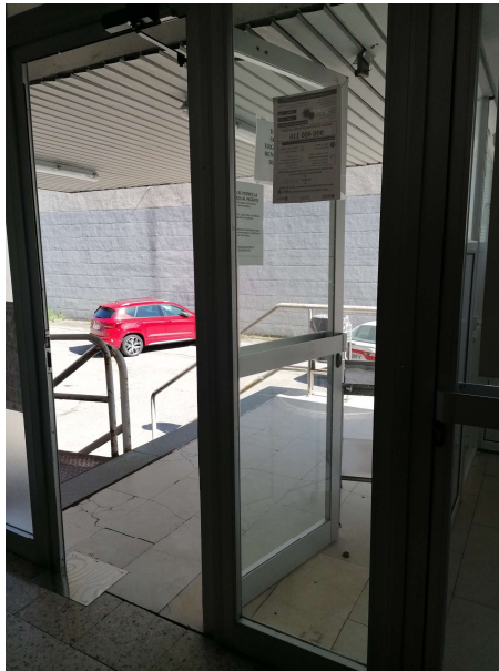
Puerta acristalada en el acceso del servicio emergencias fachada NE
