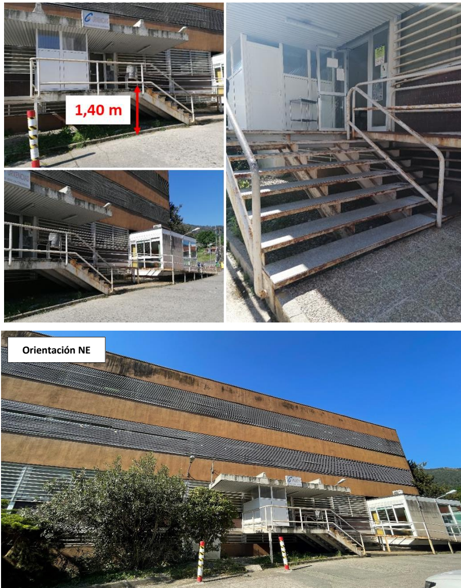
Figura 25. Acceso servicio de urgencias, fachada NE del centro de salud
