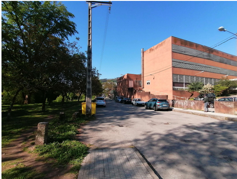
Vista de la fachada SE del centro de salud y vista de la entrada peatonal al aparcamiento.
