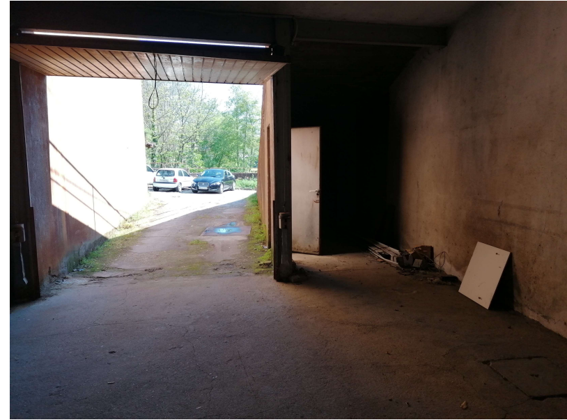
Vista del interior del garaje en la planta semisótano y rampa de acceso
