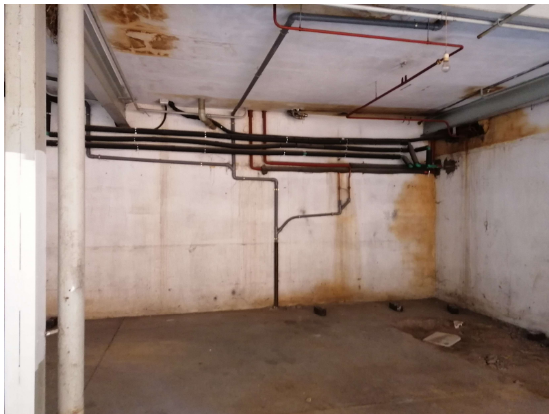
Interior del garaje en planta semisótano.
