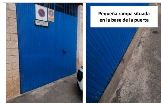
Figura 77. Puerta ubicada en la fachada posterior al Hotel Acosta próxima a la esquina de la Calle Colombia. Vista desde el exterior.
