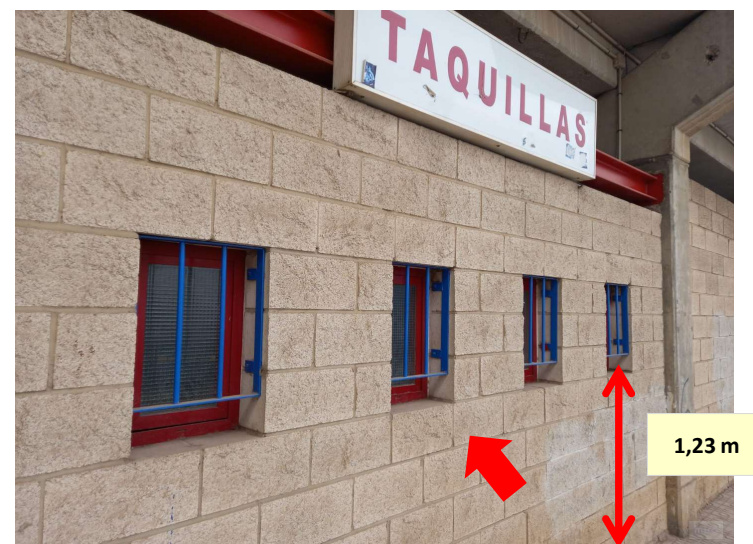
Fachada calle Badajoz. Ventanas con rejas metálicas usadas como taquillas para el público, de dimensiones 0,4 m de ancho por 0,63 m de alto, situadas a 1,23 m del pavimento.
