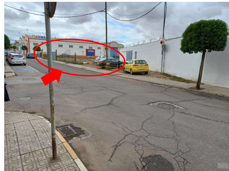
Esquina calles Colombia y Fray Alonso Cabezas. Por este punto se desagua gran parte de la avenida hacia el descampado que se ve en la fotografía.
