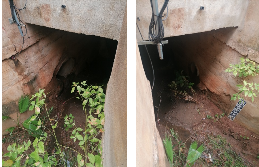
Figura 5. Obra de drenaje sobre el Arroyo del Charnecal en el parque de las Mercedes
