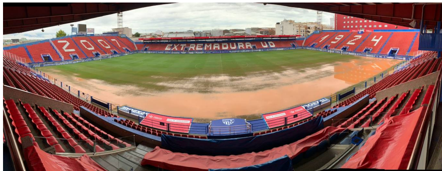
Figura 83. Terreno de juego afectado por las inundaciones. Evento septiembre de 2021.
