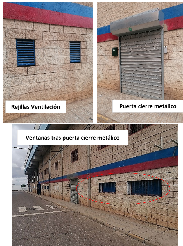
Figura 45. Rejillas de ventilación, puerta con cierre metálico y ventanas con verja metálica
