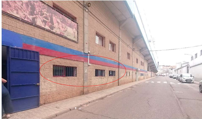
Ventanas dispuestas en la fachada de la calle Colombia. 4 ventanas de dimensiones, 0,62 m de altura y 1,62 m de longitud, con una cota desde acerado de 1,20-1,25 m.
