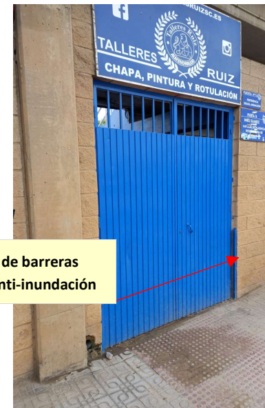
Fachada calle Badajoz. Puerta 16 con dimensiones de 2 m de ancho por 2.20 m de alto, con sistemas anti-inundaciones instalado. Se desconoce si el sistema está homologado.
