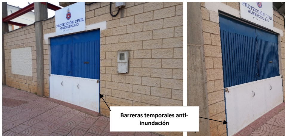
Figura 68. Acceso Oficina de Protección Civil
