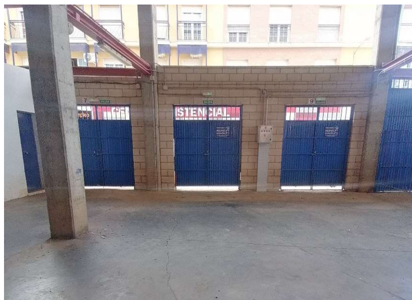
Fachada ubicada calle Colombia. Puertas 9, 8 y 7 en la zona interior de la instalación.
