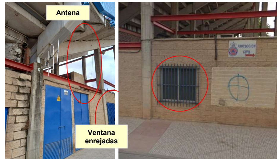
Centro de transformación y de comunidaciones ubicado en la esquina de la calle Badajoz y la calle Fray Alonso Cabezas.
