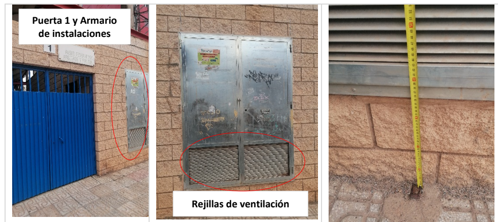
Figura 88. Rejillas y Puerta metálica de 1 hoja
