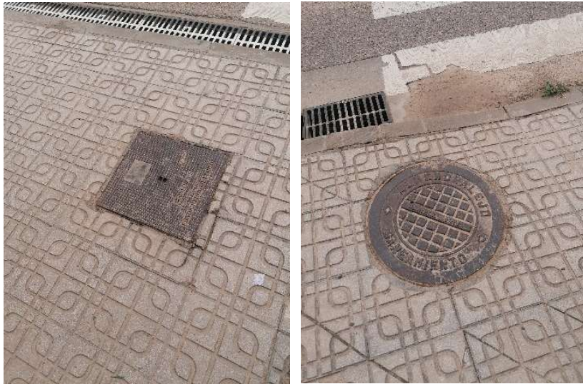
Inmediaciones de la puerta 16. Acometida de saneamiento y agua potable.
