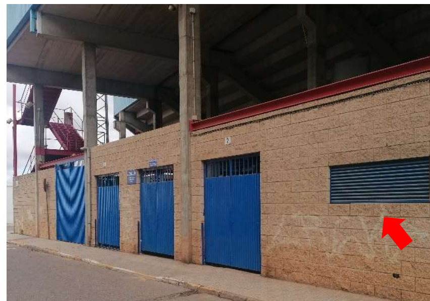
Fachada calle Colombia. Rejilla de ventilación de dimensiones, ancho 1,62 m y altura 62-63 cm.
