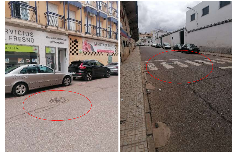
Calle Colombia. En las fotografías pueden se observarse las tapas de los pozos de registro de uno de los colectores que recogen las aguas del municipio.
