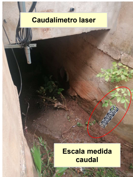
Embocadura del arroyo en el Parque de las Mercedes mediante un marco hormigón de aproximadamente 2,5 m de ancho por 2,20 m de alto.
