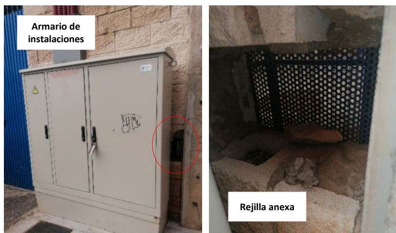
Figura 91. Rejilla anexa a la puerta de acceso ubicada en la calle posterior al Hotel Acosta Centro
