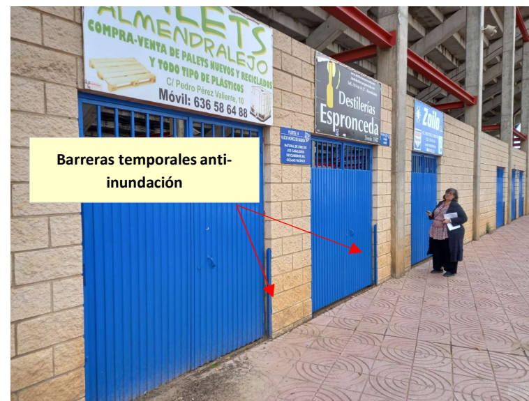
Fachada calle Fray Alonso Cabezas. Puertas 13, 14, 15 con dimensiones de 2 m de ancho por 2,20 m de alto, con sistemas anti-inundaciones instalados hasta una cota de 1 m .
