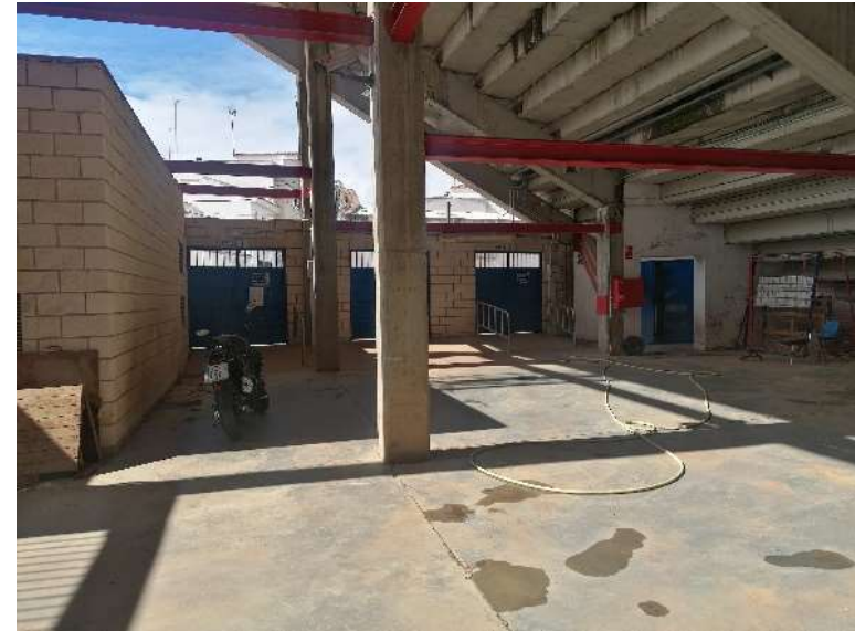
Fachada calle Colombia. Puertas 3, 2 y 1 desde el interior de la instalación.
