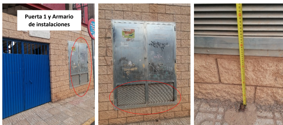
Figura 49. Puerta 1 y armario de instalaciones. Rejillas en su parte más baja
