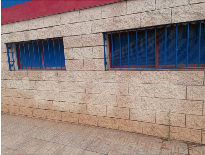
Ventanas dispuestas en la fachada de la calle Colombia. 2 ventanas de dimensiones, ancho 1,62 m y altura de 0,62 m. Distancia a acerado de 1,05 m.
