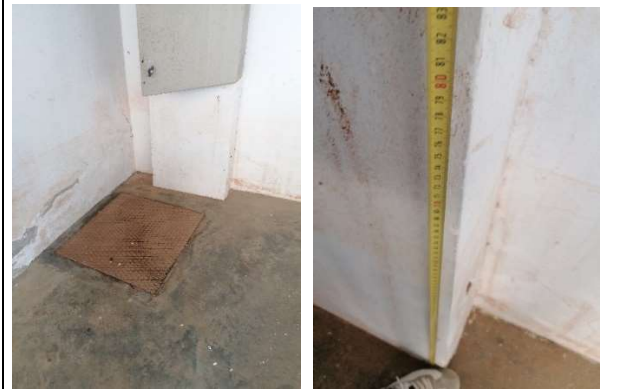
Cuadro eléctrico general
