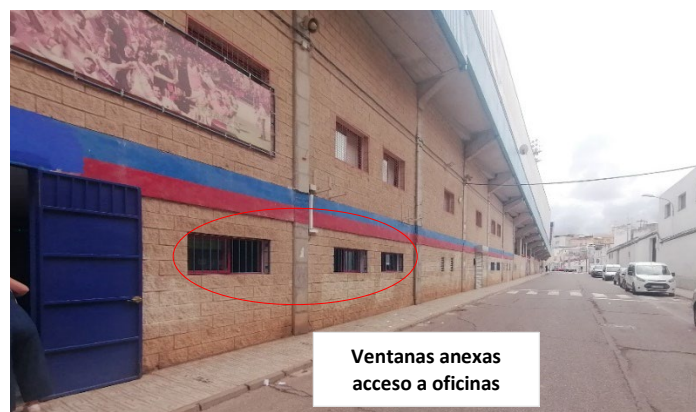
Figura 43. Vista general de la fachada desde la puerta de acceso a oficinas hasta la esquina de la calle Colombia, con la parte posterior al hotel Acosta Centro
