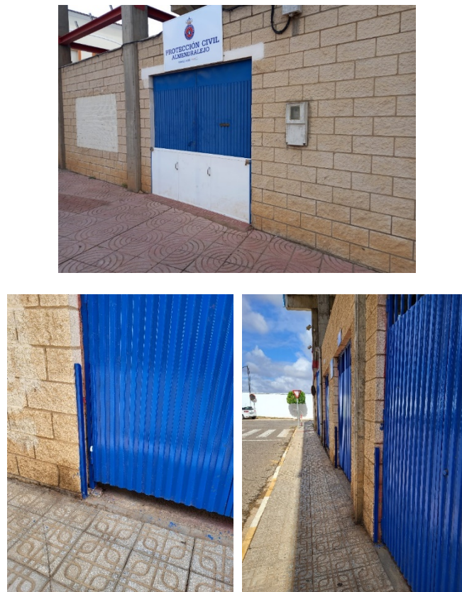
Figura 110. Protecciones anti-inundaciones instaladas
