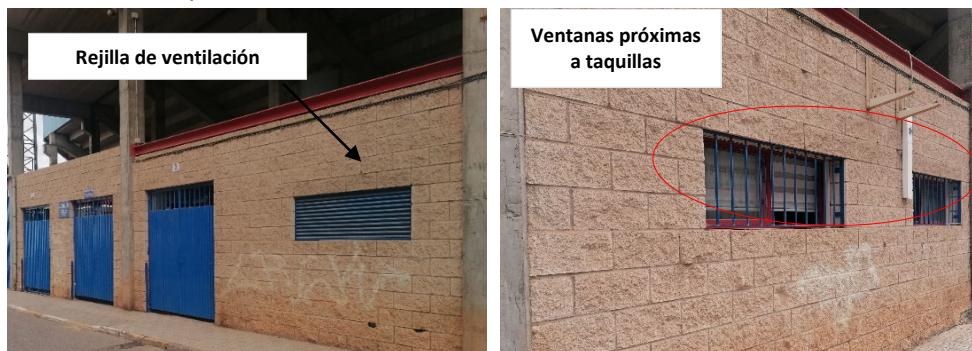
Figura 39. Rejilla y ventanas próximas a taquilla.
