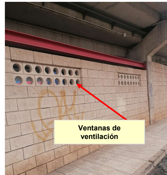
Fachada calle Colombia. Dos ventanas altas con aberturas redondas situadas a una cota de 1,8 m del acerado.
