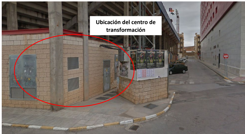
Figura 50. Vista general de la esquina de la Calle posterior Hotel Acosta Centro con la calle Colombia
