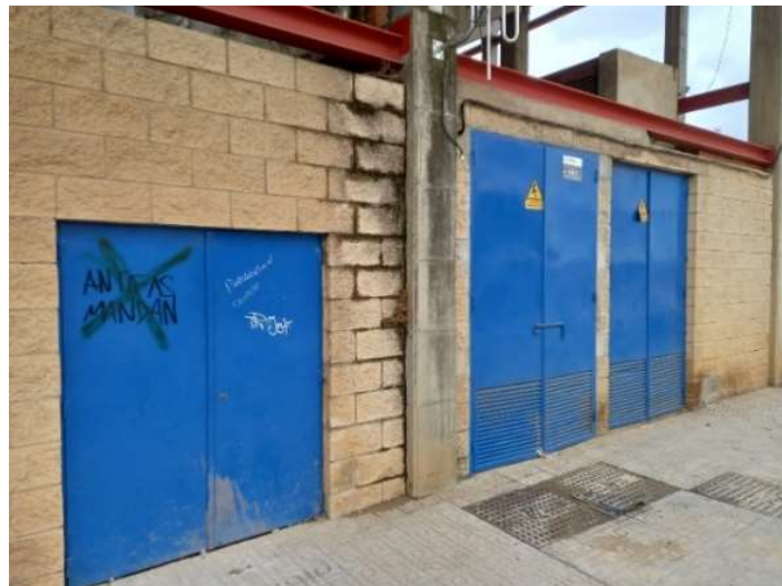
Inmediaciones de la esquina de la calle Badajoz con la calle Fray Alonso Cabezas. Centro de transformación con 2 accesos a pie de calle, de dimensiones 1,6 m de ancho y 2,57 m de alto, que cuentan con dos rejillas de ventilación en su parte inferior. En esta esquina se encuentra igualmente, un tercer armario de instalaciones de dimensiones 1,44 m de ancho y 1,80 m de altura.
