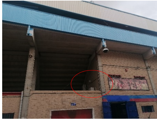
Figura 105. Unidad exterior de climatización
