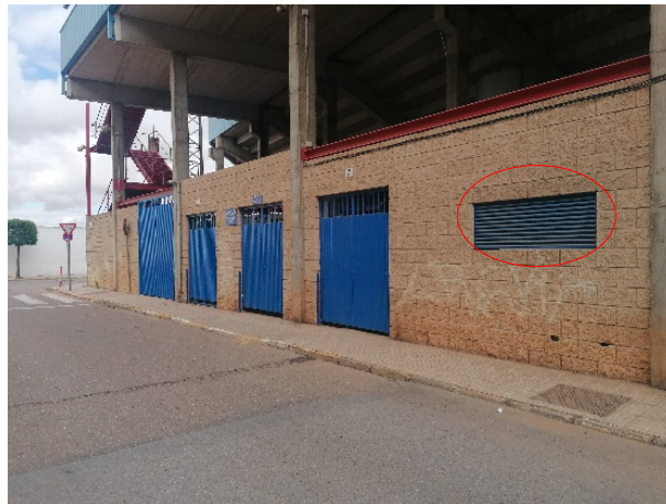
Figura 85. Rejilla de ventilación, calle Colombia
