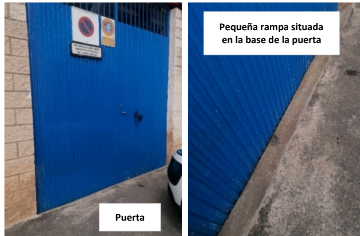
Figura 54. Puerta de acceso ubicada en la calle posterior al hotel
