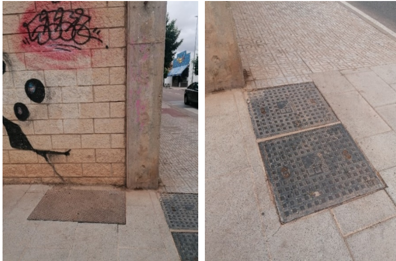
Figura 56. Arquetas de instalaciones ubicadas en la esquina de la calle Badajoz con la calle posterior al Hotel Acosta
