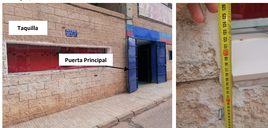
Figura 40. Taquilla y acceso a zona de oficinas ubicado en la calle Colombia
