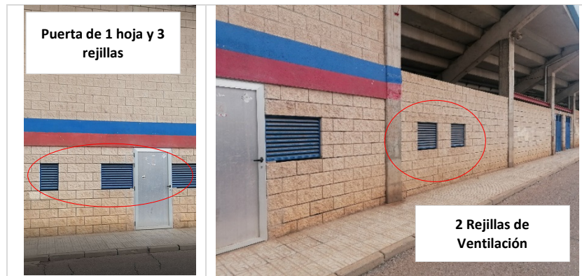
Figura 87. Rejillas anexas a Puerta metálica de 1 hoja
