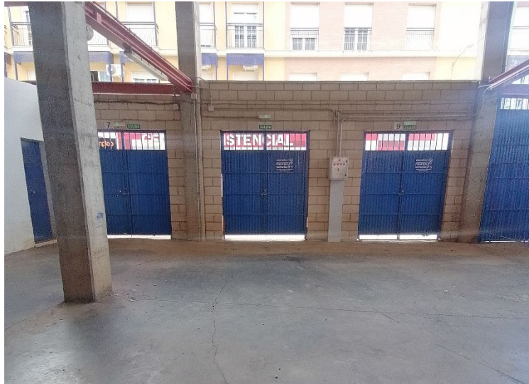
Figura 38. Puertas 9,8 y 7. Vista desde el interior de la instalación
