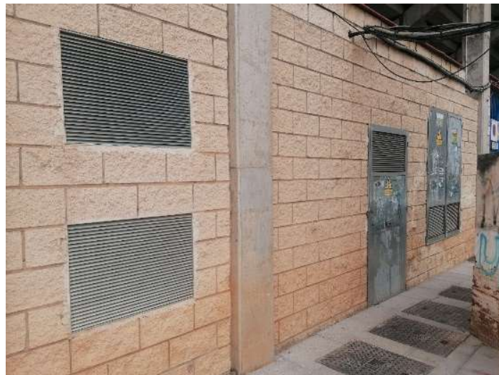
Esquina calle Colombia con la calle posterior al Hotel Acosta Centro. Rejillas de ventilación de dimensiones 80 cm de ancho y 60 cm de altura.
