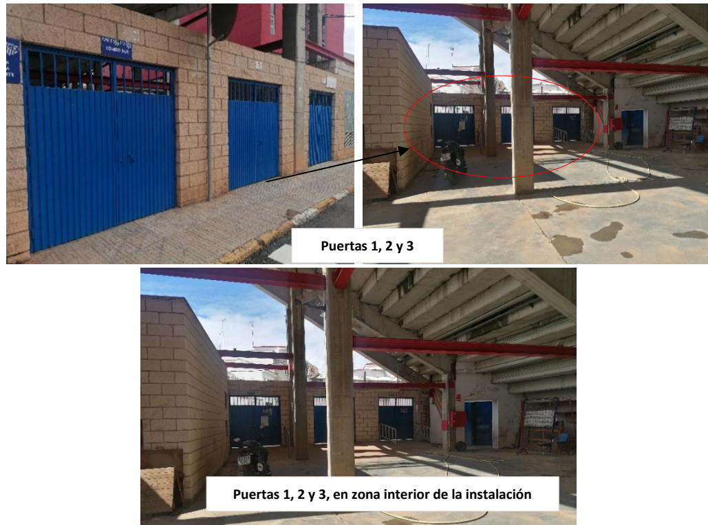
Figura 48. Puertas 1, 2 y 3. Puertas de dos hojas, de ancho 2,03 m
