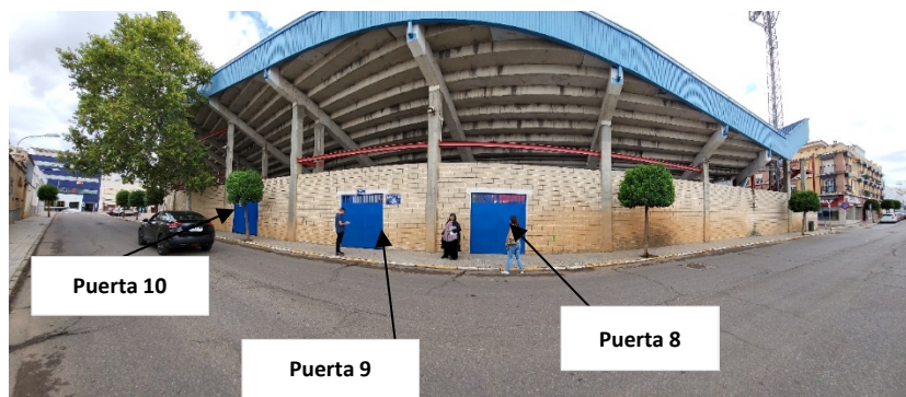
Figura 73. Vista general puertas 10, 9 y 8
