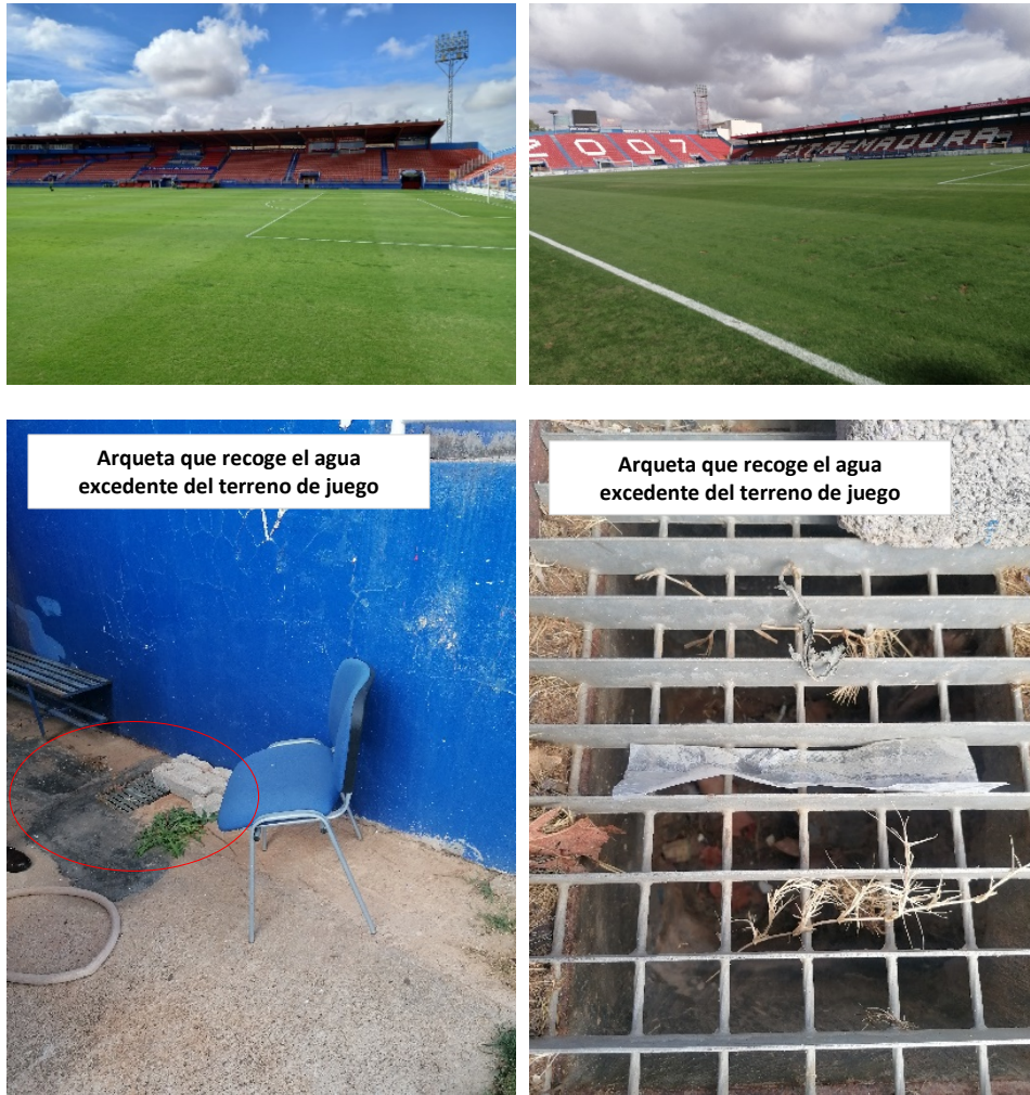
Figura 33. Terreno de juego y arqueta que recoge el excedente del drenaje de la sección de juego
