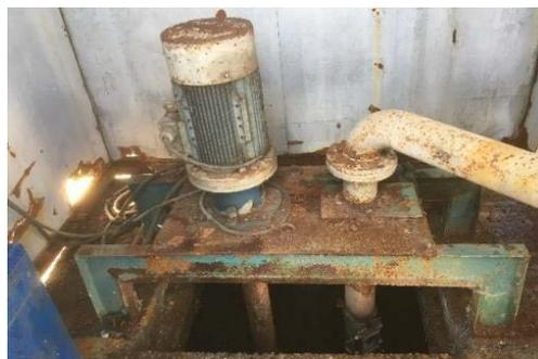
Ilustración 47 Medidas de autoprotección en Teknia: bombas de achique.
