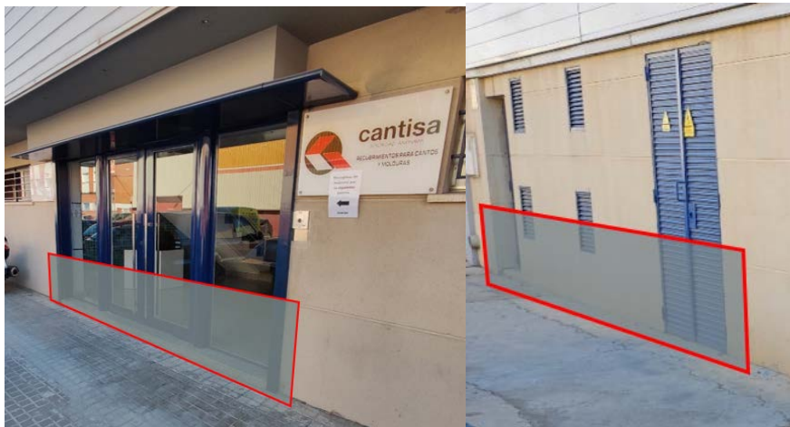
Ilustración 39. Ejemplos de barreras temporales de paneles apilables de aluminio y croquis de ubicación en accesos naves C/Pintor Joaquín Sorolla.
