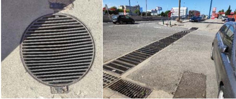
Ilustración 31. Detalle drenaje C/Pintor Sorolla
