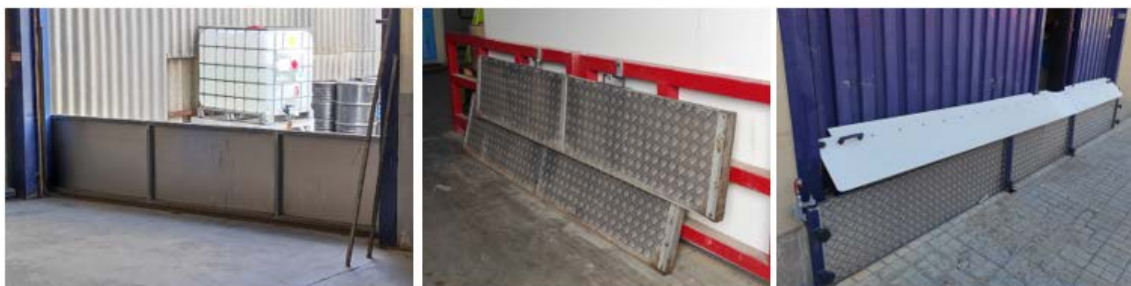
Ilustración 30. Detalle de barreras temporales artesanales empleadas en Cantisa.
