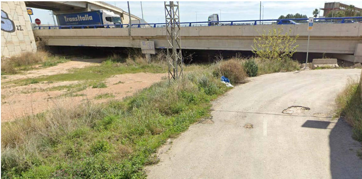
Ilustración 11. Detalle barranco de la Saleta en su cruce con la A-3
