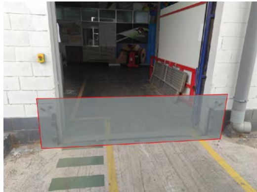
Ilustración 41. Puertas de acceso interiores
