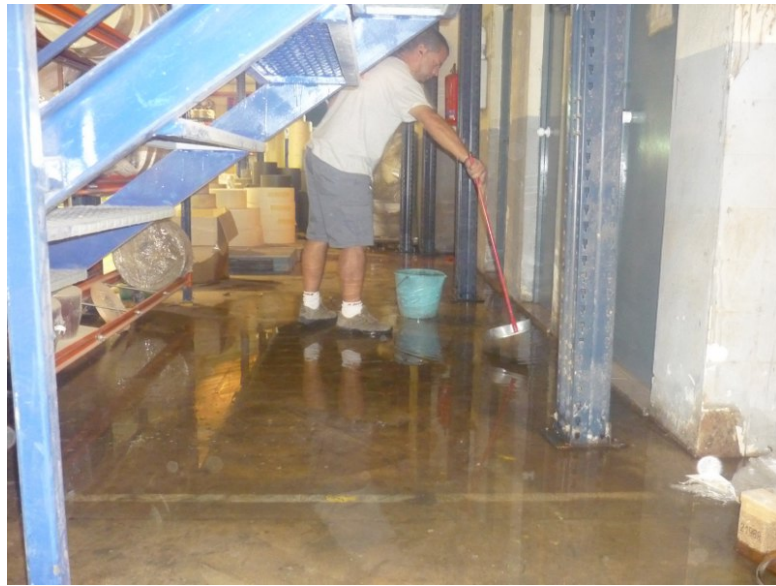
Ilustración 3. Trabajos de limpieza en la nave de Cantisa
