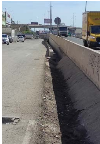
Ilustración 32. Zanja de drenaje junto a la A-3.
