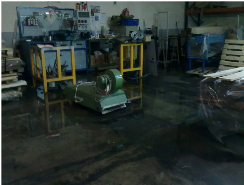
Ilustración 2. Efectos de la inundación en la nave de Cantisa
