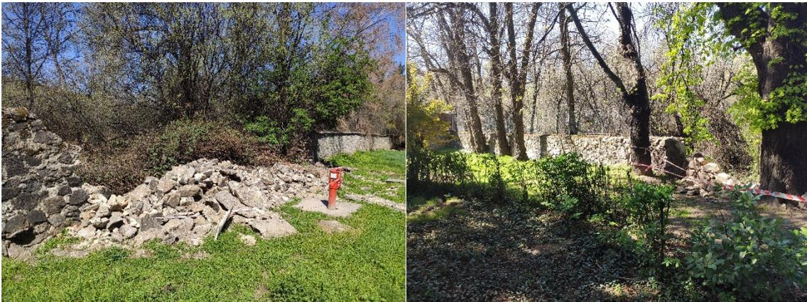
Ilustración 23 y 24 Murete perimetral derribado
