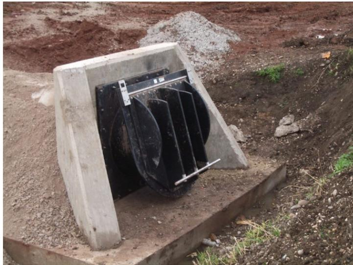
*Ilustración 49 Válvula de retención*
