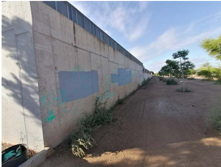
Fachada NE Pabellón deportivo
