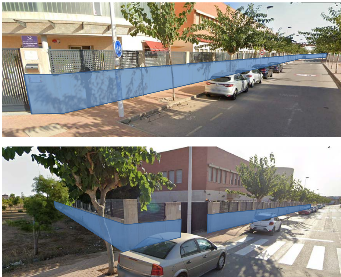
Figura 70. Impermeabilización de muro perimetral
