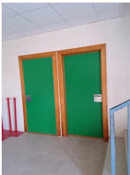
Figura 47. Sala de calderas tras las puertas
