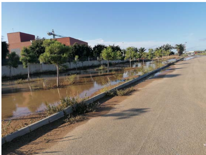
Zonas ajardinadas fachada NO (II)
