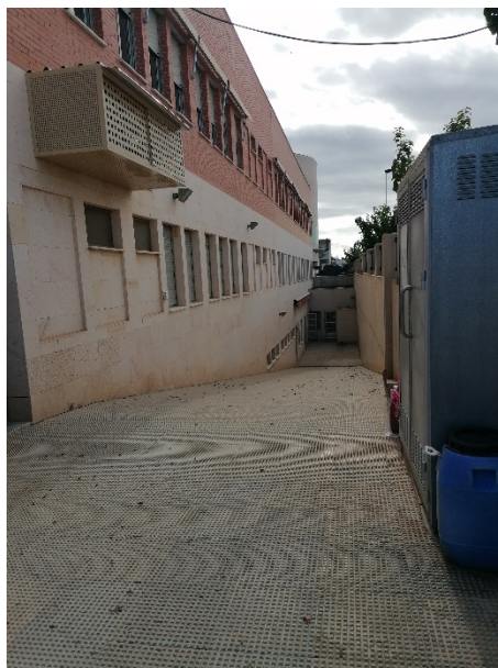
Figura 46. Cuarto de instalaciones en el pabellón docente
