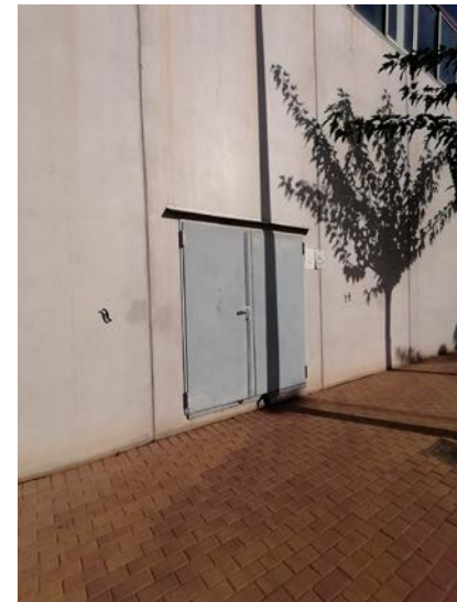
Puerta acceso Pabellón deportivo c/ Pablo Gargallo
