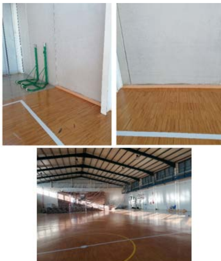
Figura 49. Vistas de la tarima del pabellón deportivo
