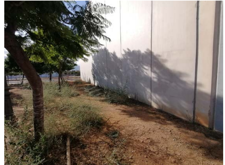
Muro Pabellón deportivo (II)
