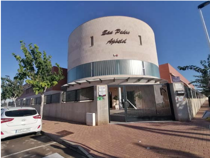
Acceso perimetral principal al CEC San Pedro Apóstol
