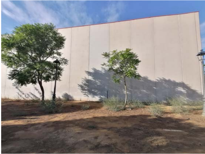
Muro Pabellón deportivo (I)
