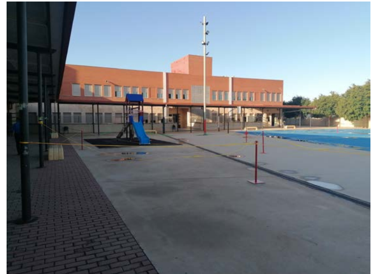
Fachada NO Pabellón docente
