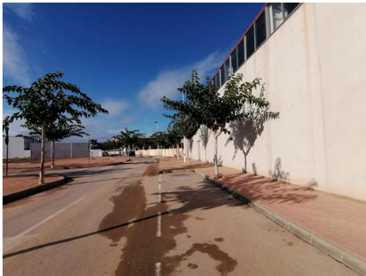
Fachada NE Pabellón deportivo
