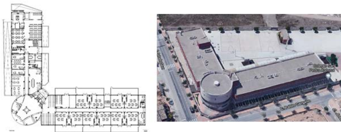
Figura 13. Pabellón docente (Imagen: Google Earth)
