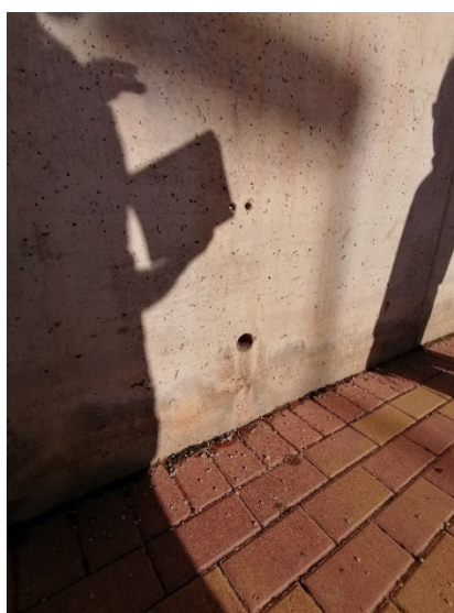
Figura 22. Mechinales en el muro perimetral
