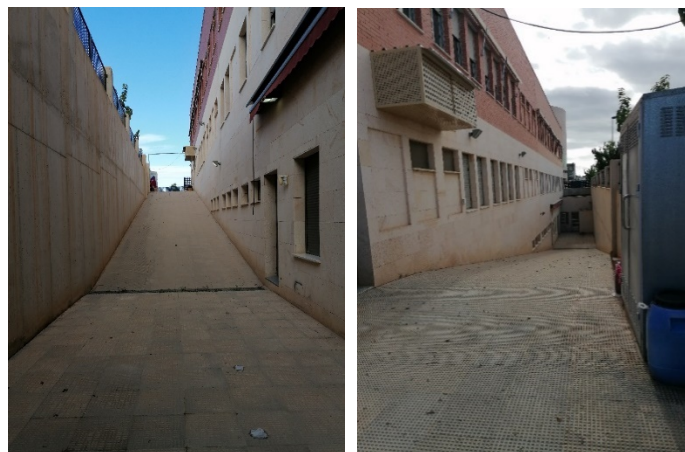
Figura 32. Rampa de acceso al sótano del pabellón docente
