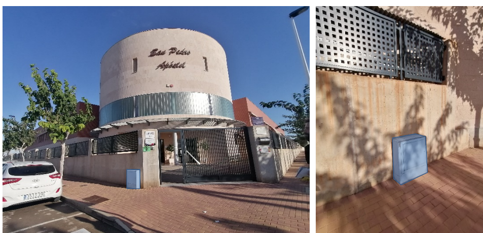
Figura 67. Protección de las acometidas de agua al pabellón docente y pabellón deportivo
