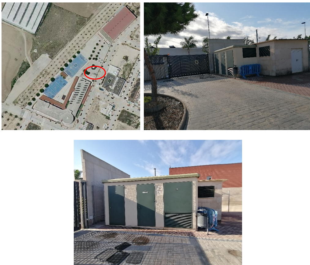
Figura 21. Localización del centro de transformación eléctrica
