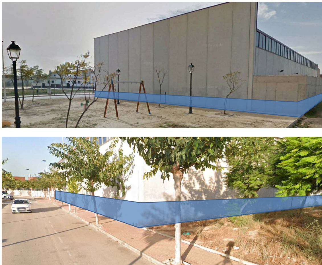
Figura 66. Impermeabilización del muro perimetral posterior y fachadas NE y SE del pabellón deportivo
