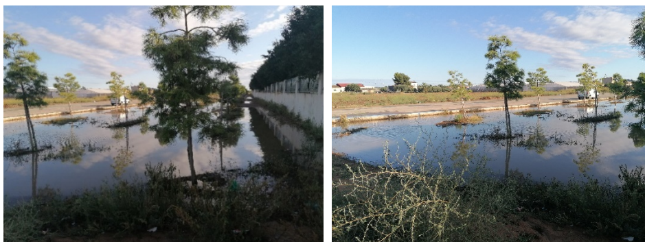
Figura 53. Condena de acceso en el límite de zona ajardinada propensa a inundarse
