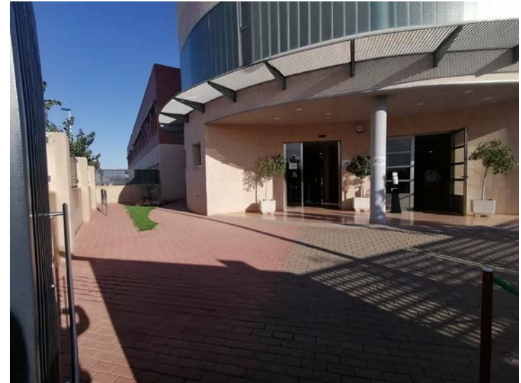
Detalle acceso principal al pabellón docente
