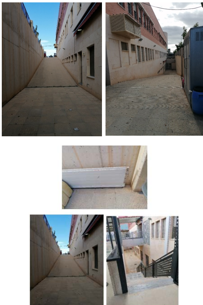
Figura 50. Barrera anti-inundación/Rampa de acceso al sótano del pabellón docente
