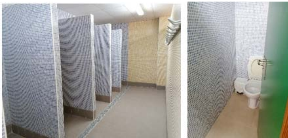
Figura 38. Aseas del pabellón deportivo
