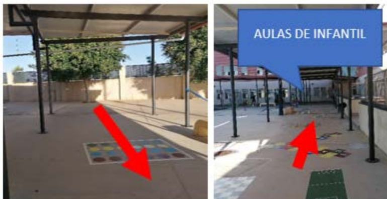
Figura 52. Recorrido del agua en la zona del patio previo a las actuaciones
