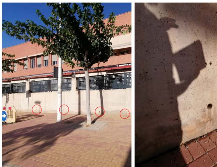
Figura 57. Mechinales en el muro perimetral
