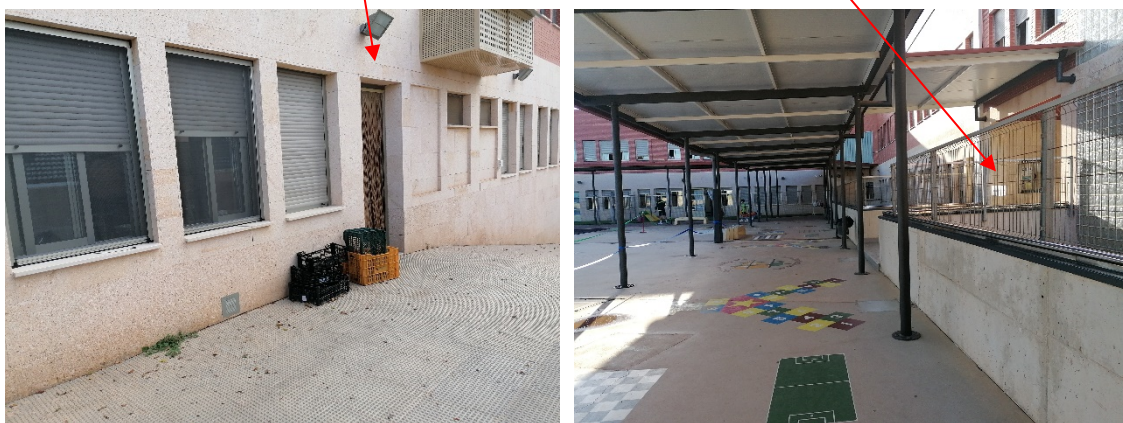
Figura 31. Puertas de acceso a cocina y salida desde el porche al patio de juegos
