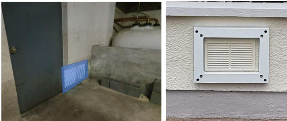
Figura 42. Protección de rejillas de ventilación
