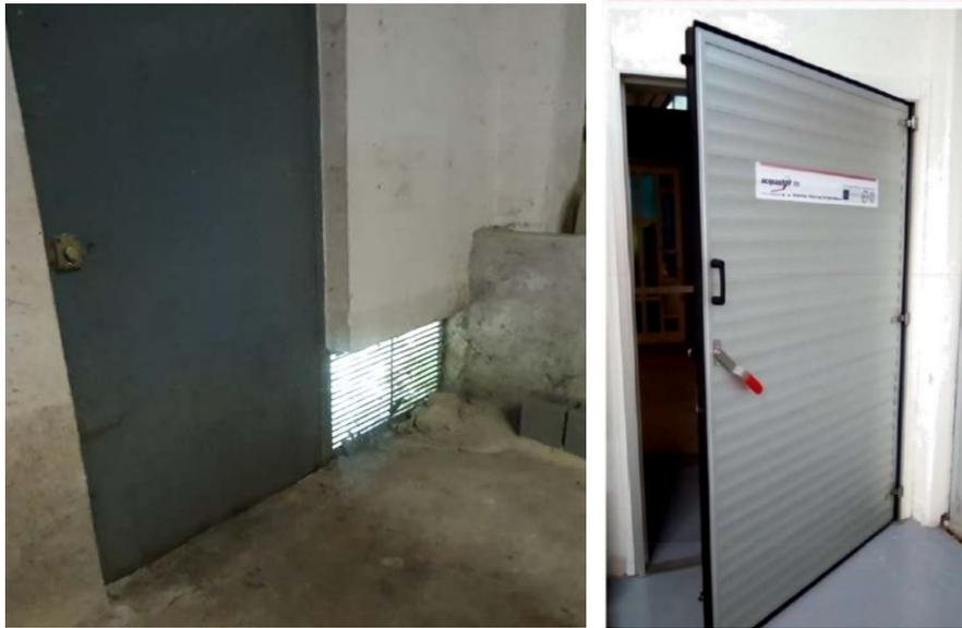
Figura 43. Puerta estanca en acceso a sala de calderas, en planta sótano de edificio anexo
