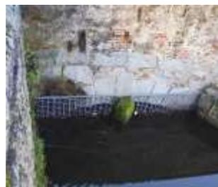
Figura 78. Instalación de rejas metálicas previas a los canales para evitar el paso de electos sólidos (Fuente RCMS).
