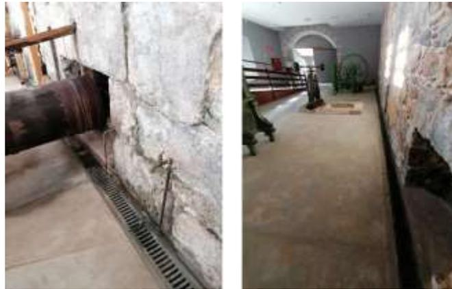
Figura 59. Rejillas para la filtración del agua en el interior del museo
