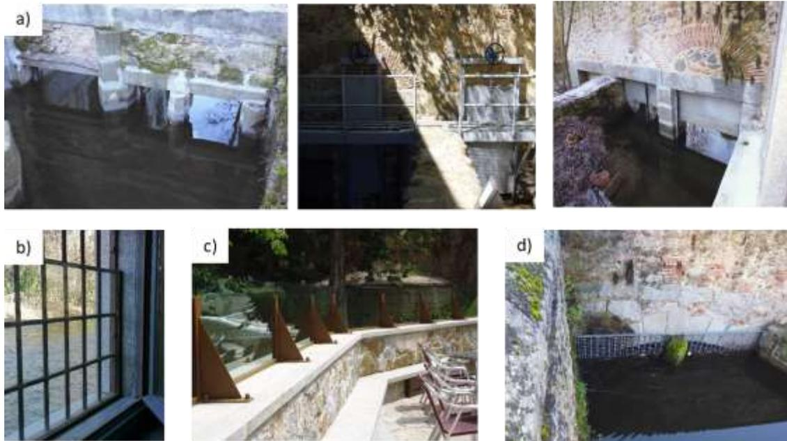
Figura 19. a) Colocación de compuertas metálicas y estructura auxiliar para evitar el paso del agua a los canales por el retroceso del río; colocación de vidrios de seguridad sobre perfil metálico en las ventanas de la herrería; c) recrecido del muro de la terraza de la cafetería con la colocación de un peto de vidrio fijado con soportes metálicos; d) instalación de rejillas metálicas previas a los canales para evitar el paso de electos sólidos
