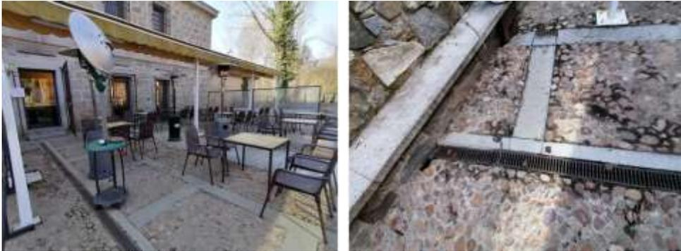
Figura 58. Rejillas para la filtración del agua en la terraza del restaurante
