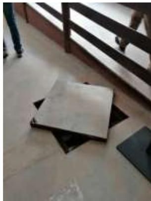
Figura 57. Arqueta del tanque de tormentas ubicada en el interior del taller
