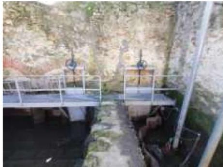
Figura 49. Compuertas de salida del canal al río
