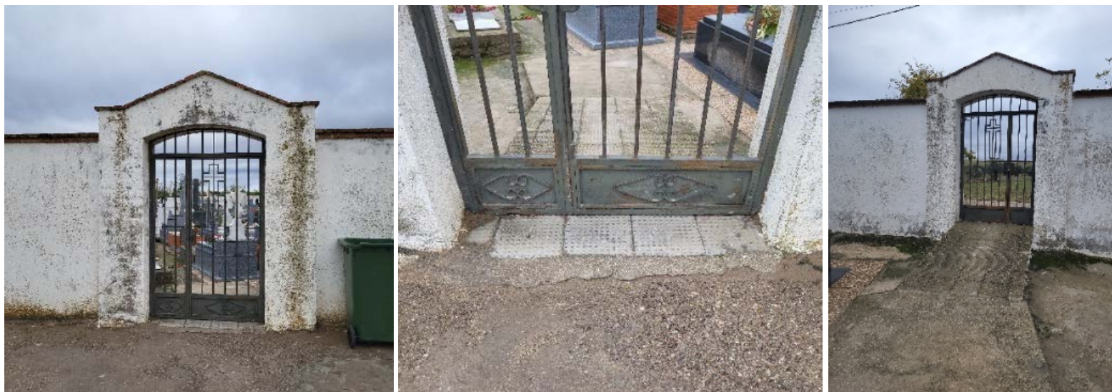
Puerta acceso al cementerio en el camino de Domingo Pérez, con chapa inferior, y con rampa hacia el interior
