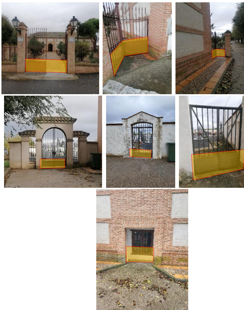
Figura 54. Disposición de barreras metálicas desmontables en accesos a los jardines, al cementerio y ventana en fachada oeste
