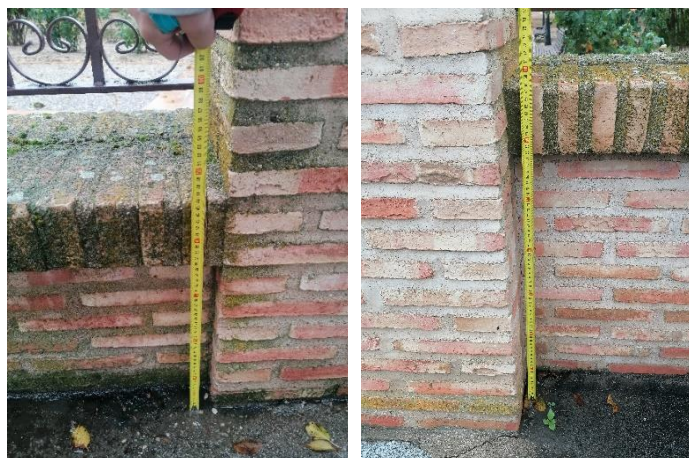
Figura 22. Altura del murete exterior, en las inmediaciones de la entrada principal. Lado izquierdo, con 46 cm de alto, lado derecho 68 cm
