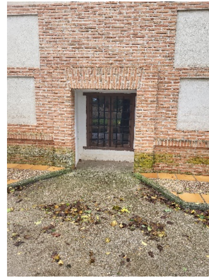
Humedades en la fachada del edificio, orientación oeste
