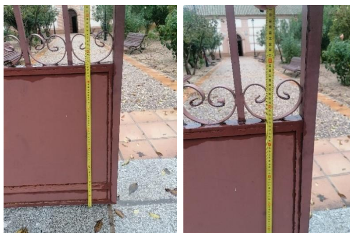
Figura 23. Altura la chapa opaca de la forja de la puerta de entrada (76 cm)
