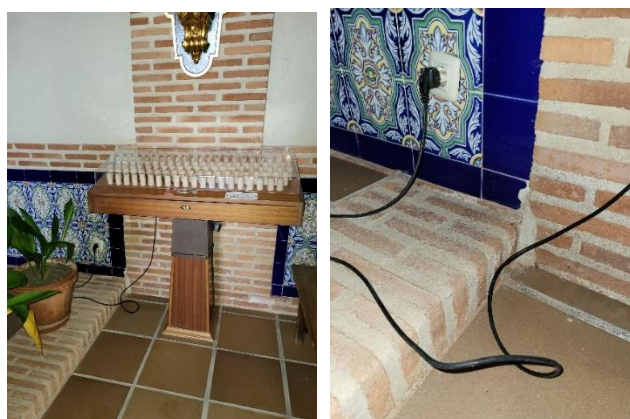
Figura 45. Toma eléctrica, no elevada, que da servicio al lampadario
