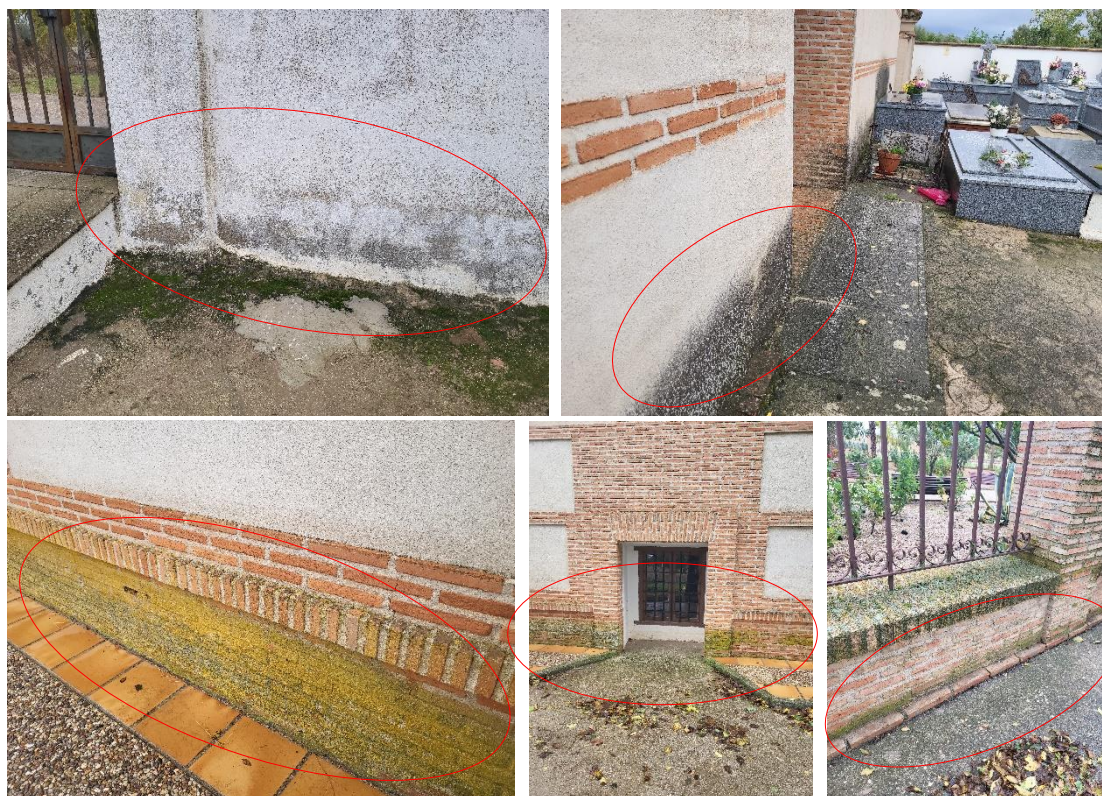
Figura 42. Marcas de inundación en cerramiento del cementerio, edificio y murete perimetral de la ermita
