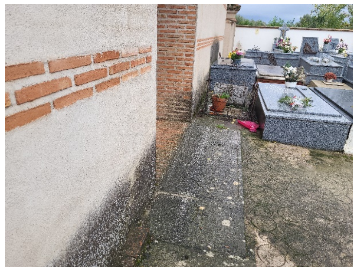
Humedades en la fachada del edificio, orientación norte
