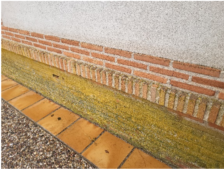
Humedades en la fachada del edificio, orientación sur
