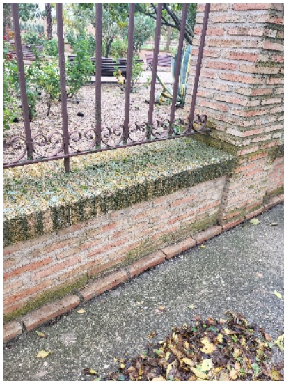
Humedades en el murete perimetral, orientación oeste
