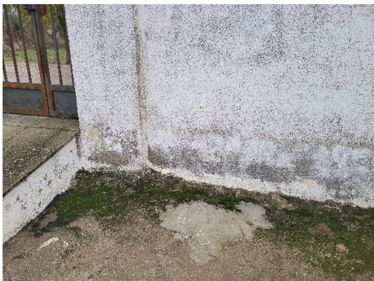
Humedades en el interior del muro del cementerio
