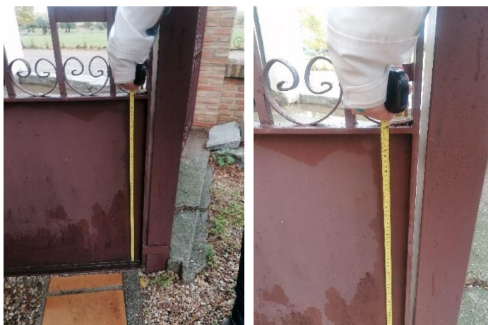
Figura 26. Acceso lateral en orientación este. Anchura de la parte opaca de la forja: 0,74 m
