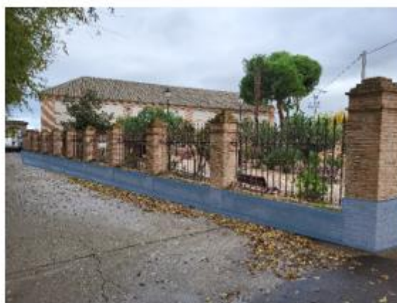
Figura 56. Impermeabilización de murete perimetral de los jardines y muro del cementerio
