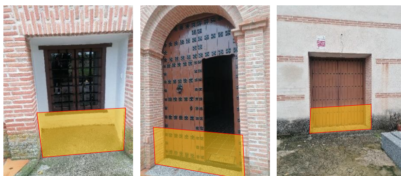
Figura 58. Disposición de barreras metálicas desmontables
