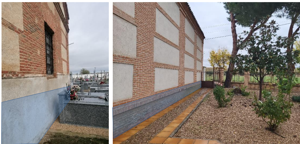
Figura 57. Impermeabilización del edificio de la ermita
