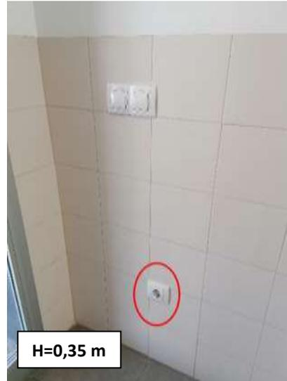
Figura 39. Toma situada a la entrada del edificio junto a los baños
