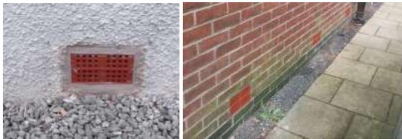
Figura 51. Ejemplos de tipología de protección diseñada en rejillas.
