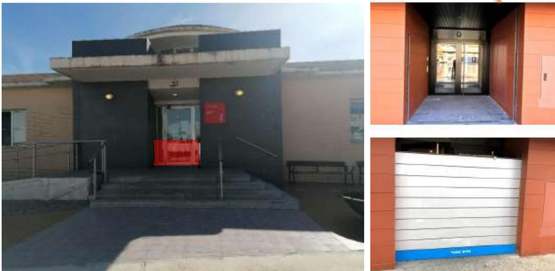
*Figura 49. Instalación de barrera temporal frente inundaciones en acceso a edificio. ( Fuente: CAG Canalizaciones).*
