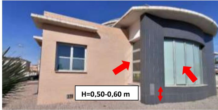
Figura 50. Acristalamiento a sustituir en fachada SE.
