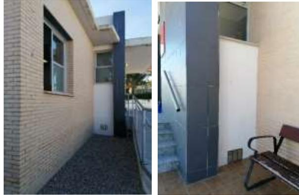
Figura 29. Ventanas laterales ubicadas sobre cota de inundación ( $h > 1,5$  m) en el acceso principal al edificio
