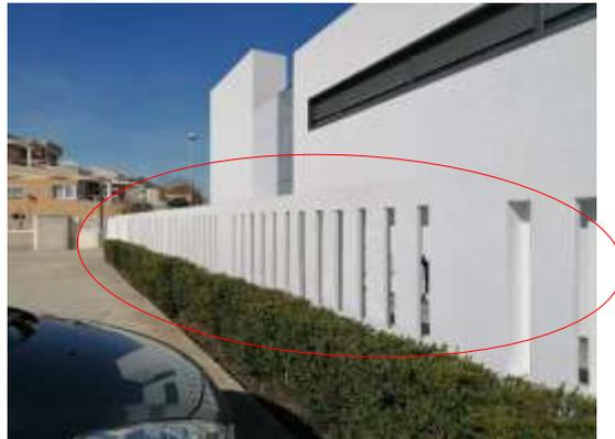
Figura 47. Cierre de huecos en muro hasta 1 m de altura
