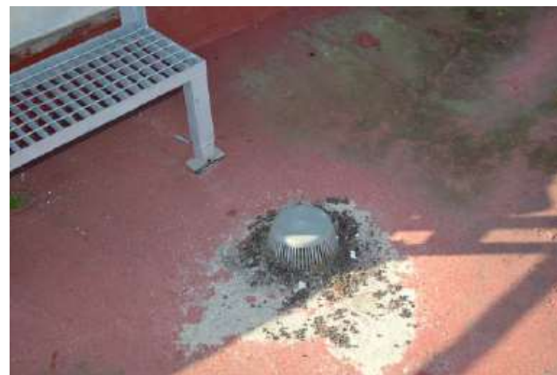
Rotura y obstrucción de sumideros en cubiertas.
