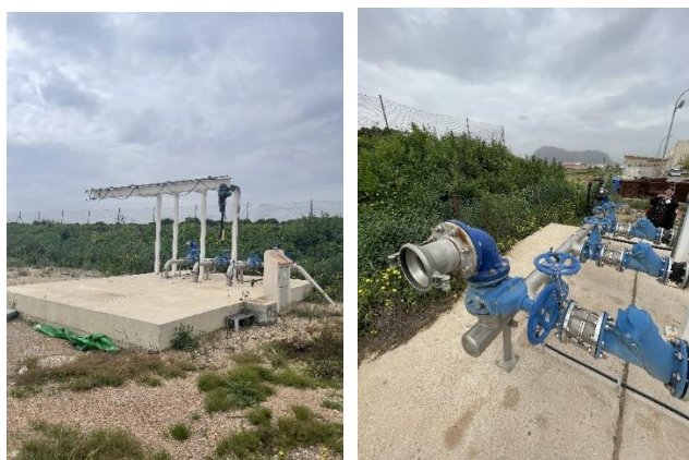
Figura 111. Sistema de bombeo.
