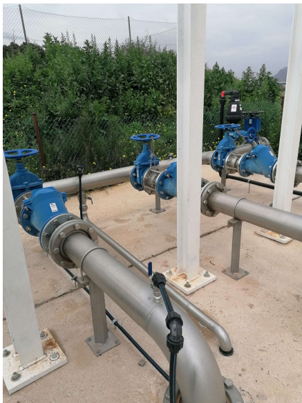
Sistema de bombeo instalado para evacuar la escorrentía de la parcela.
