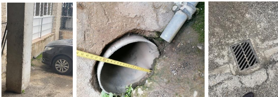
Figura 92. Tubo de evacuación de la plaza donde se ubican los transformadores y drenaje del vial anexo.
