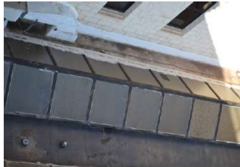
Entrada de agua por lucernarios por sellado deficiente y falta de solape entre la lámina impermeabilizante de cubierta y los lucernarios.
