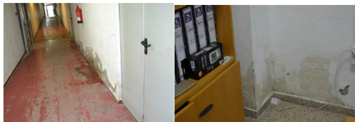
Figura 19. Daños detectados en particiones interiores. (Fuente: Informe de Daños y Medidas Urgentes).
