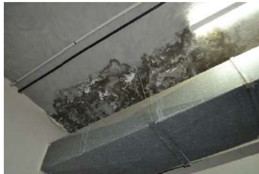
Manifestación de filtraciones y goteras procedentes de azoteas.
