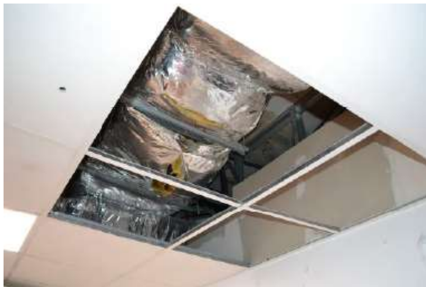
Deterioro conductos de climatización.
