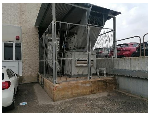
Figura 87. Climatizador emplazado anexo al aparcamiento
