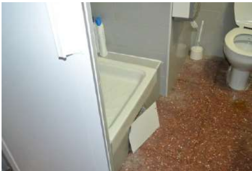
Salida de agua por los sanitarios a través de la red de saneamiento.
