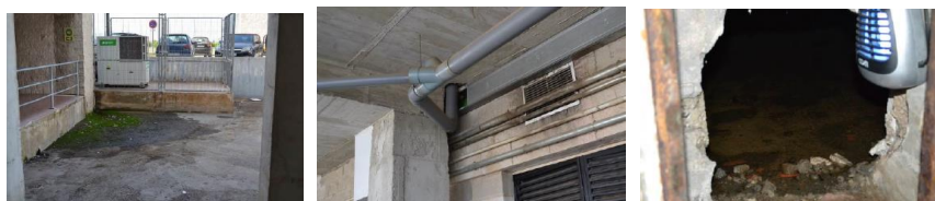
Figura 35. Atascos en las conducciones por un mal dimensionado e inundación del forjado sanitario.
