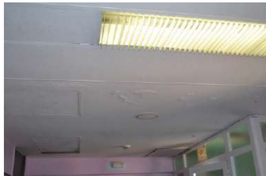
Humedades detectadas en techos, producidas por condensaciones o fugas de las instalaciones.
