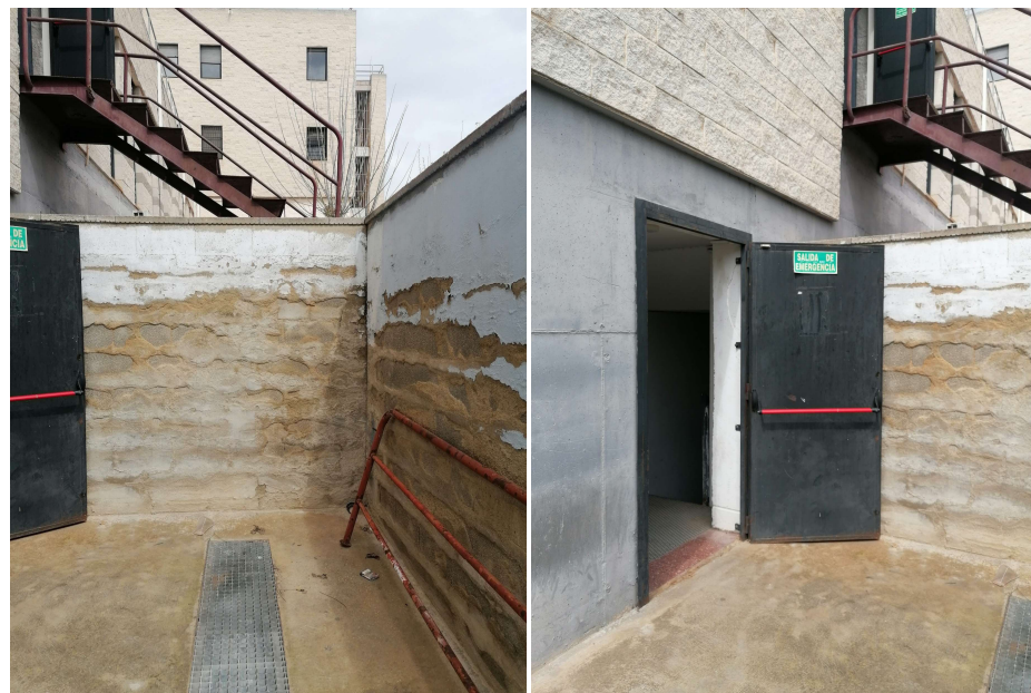
Fachada este. Puerta de acceso a talleres y sala de mantenimiento. Pueden observarse daños en el muro por humedades.
