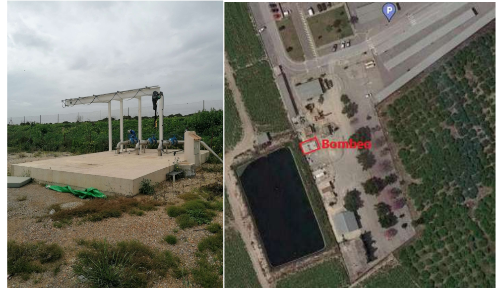
Nuevo sistema de bombeo situada en orientación suroeste. El sistema cuenta con tres bombas
