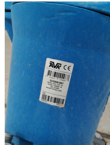
Válvula de retención de bola embridada ubicada en el sistema de bombeo.
