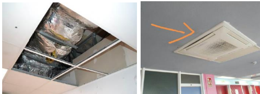
Figura 95. Deterioro conductos de climatización. (Fuente: Informe de Daños y Medidas Urgentes.)
