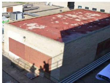
Figura 118. Rotura de membrana impermeabilizante en azotea. (Fuente: Informe de Daños y Medidas Urgentes. Evaluación del Estado de las Infraestructuras del Hospital Vega Baja tras la DANA de 2019).
