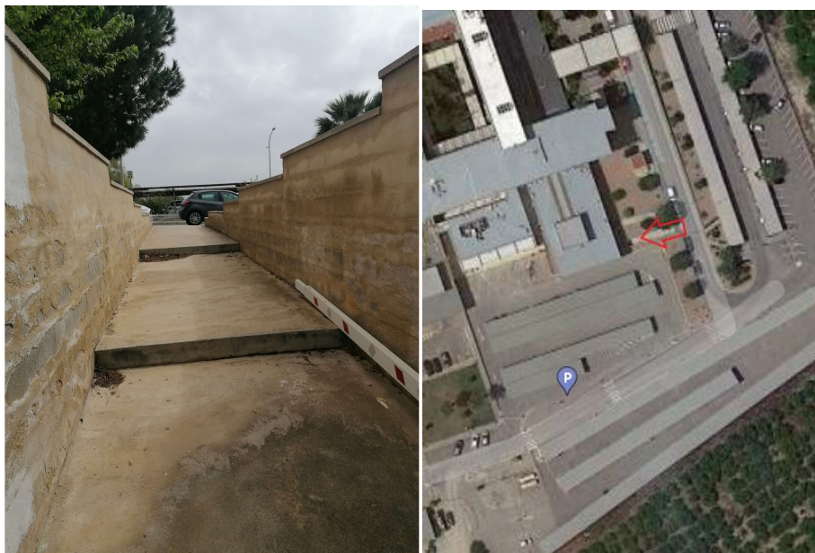
Fachada este. Rampa de acceso a talleres y sala de mantenimiento. A esta sala el agua no entró desde el exterior, únicamente entró agua por el saneamiento.
