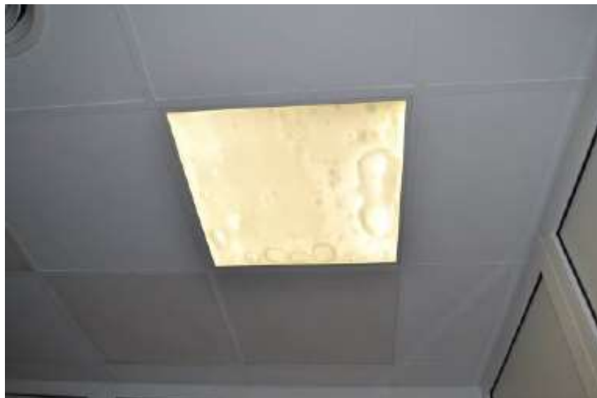
Luminaria afectada por la entrada de agua.
