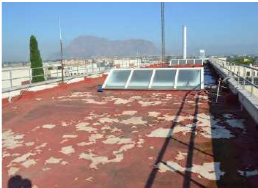
Ausencia y rotura de membrana impermeabilizante de azotea.
