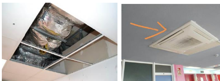
Figura 36. Deterioro conductos de climatización.
