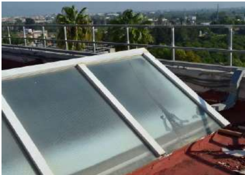
Rotura y falta de estanqueidad de claraboyas en cubiertas.
