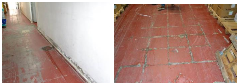
Figura 21. Daños detectados en pavimentos. (Fuente: Informe de Daños y Medidas Urgentes).
