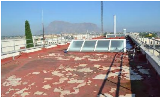
Figura 11. Ausencia y rotura de membrana impermeabilizante de azotea (Fuente: Informe de Daños y Medidas Urgentes).
