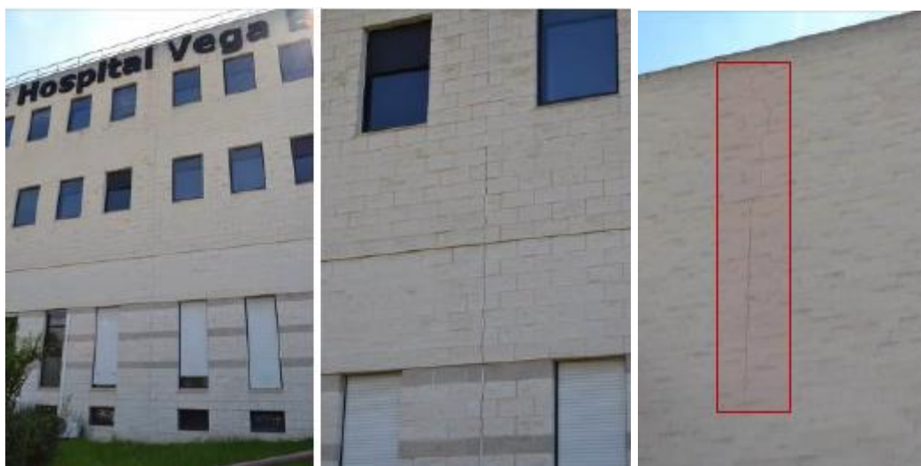
Figura 90. Degradación a ausencia de juntas en fachadas. (Fuente: Informe de Daños y Medidas Urgentes. Evaluación del Estado de las Infraestructuras del Hospital Vega Baja tras la DANA de 2019).
