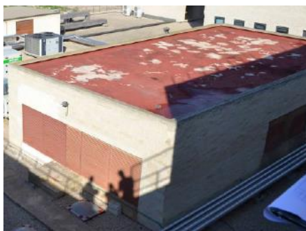
Figura 89. Rotura de membrana impermeabilizante en azotea. (Fuente: Informe de Daños y Medidas Urgentes. Evaluación del Estado de las Infraestructuras del Hospital Vega Baja tras la DANA de 2019).
