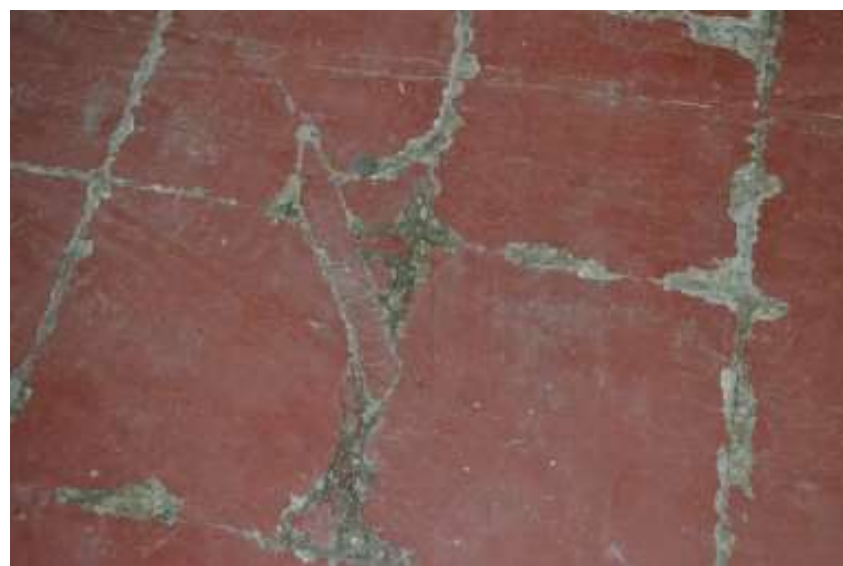
Degradación en pavimentos.
