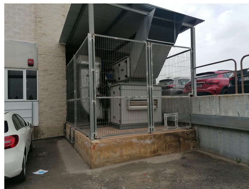
Muelle de carga ubicado en orientación oeste. Localización del climatizador. El agua llegó a la bancada pero no quedó afectado durante el evento de 2019.
