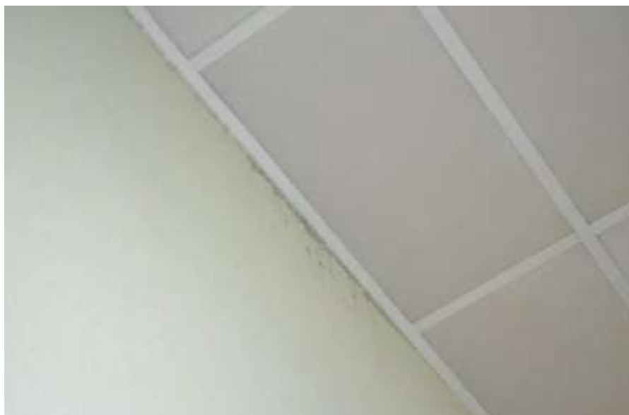
Presencia de vegetación y/o microorganismos (moho, musgo, bacterias...) en paramentos interiores.
